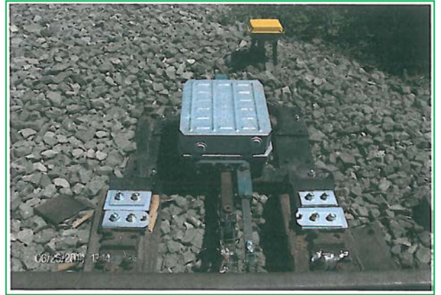
Înlocuire electromecanism de sabot, liniare și alunecători la sabotul S2 stația Periș
