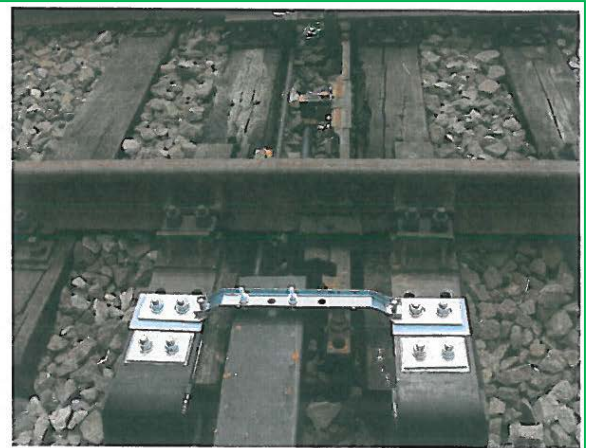
Montare inductori noi de 500Hz și 1000/2000Hz – stația Periș
