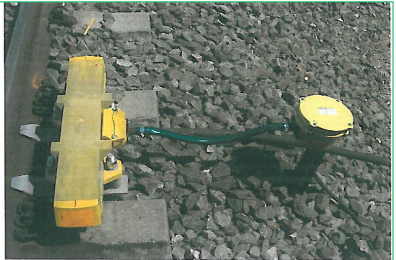
Montare electromecanism SIEMENS și înlocuire bare la schimbător de cale – stația Periș
