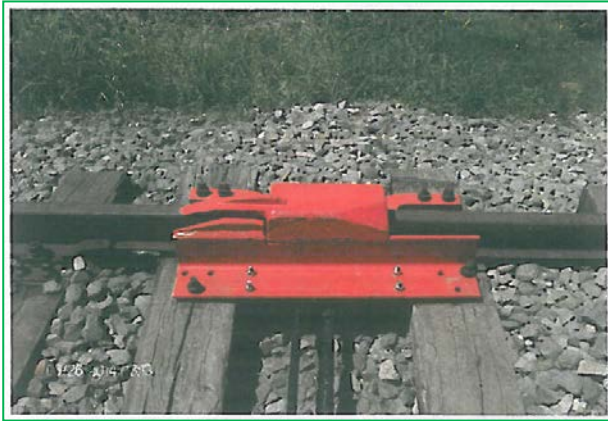
Înlocuire electromecanism de sabot, liniare și alunecători la sabotul S2 stația Periș
