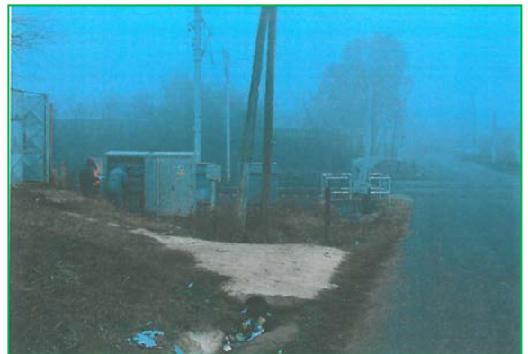
Lucrări de modificare a instalației BAT – Km 49+908
