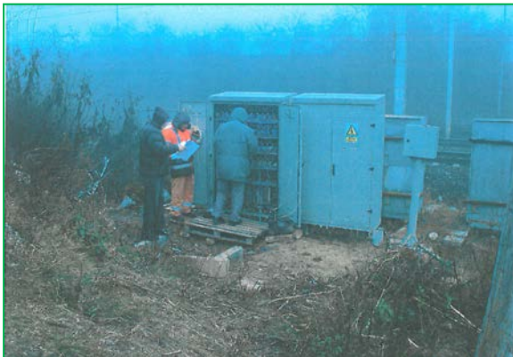
Lucrări de modificare a instalației BAT – Km 49+908
