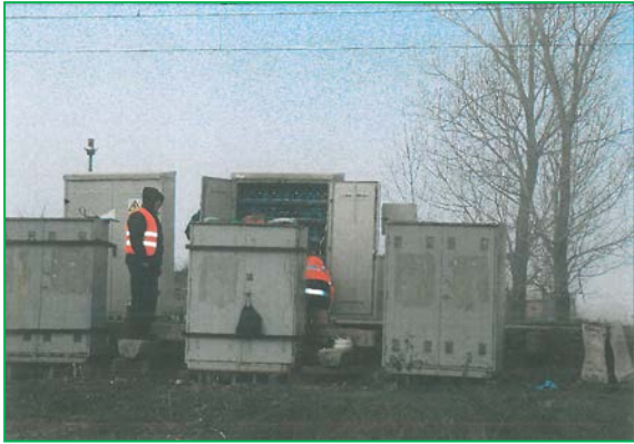
Lucrări de modificare a instalației BAT – P.O. Scroviștea
