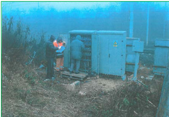
Lucrări de modificare a instalației BAT – Km 49+908
