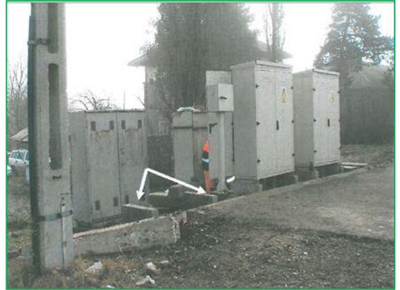
P.O. Scroviștea - noile fundații montate pentru dulapul suplimentar de aparataj
