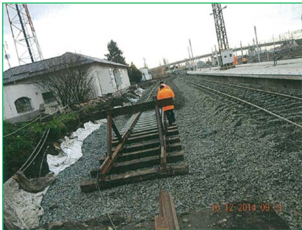
Stația Curtici – platformă de depozitare fila macara
