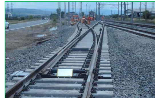
km 408+500 pr. – Stația BARABANT
