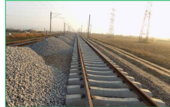
km 409+100 pr. – Stația BARABANT
