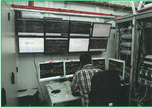
Executarea testelor de funcționare a instalațiilor
