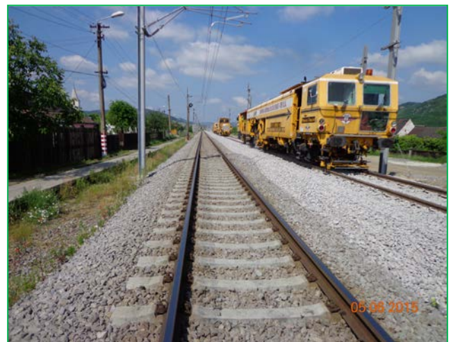
St. Coșea Mică LIII - buraj, profilare și stabilizare
