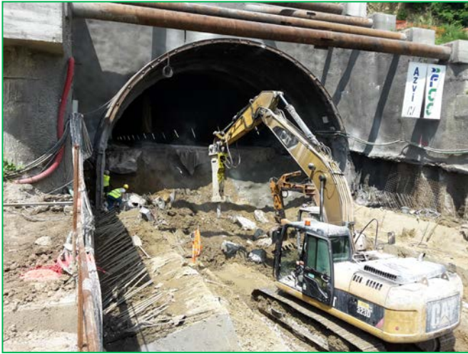
Tunel Daneş - portal ieșire - consolidare taluz
