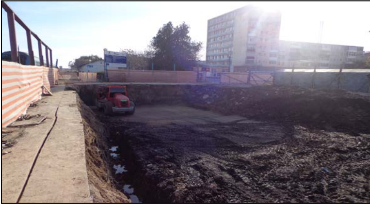
Corp A – Îmbunătățire teren de fundare
