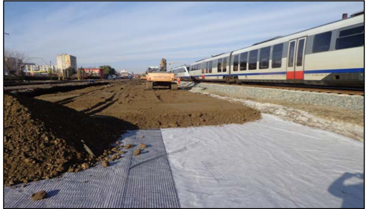
Linii CF – Așternere geotextil și balast
