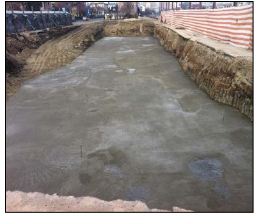
Corp A – Beton de egalizare fundație
