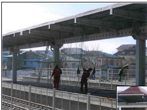
Pozare cabluri pentru instalația de sonorizare și informare a publicului călător
