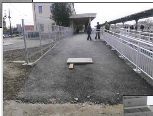
Turnare asfalt pe peronul principal Linia 1 cap X
