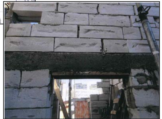
Realizare buiandrug de beton la corpul A1 clădire călători
