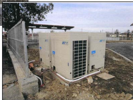
Montare unități exterioare de climatizare inclusiv instalația aferentă
