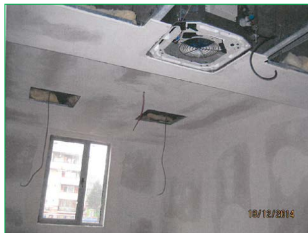
Clădire de călători – tavan fals și montare aparataj climatizare
