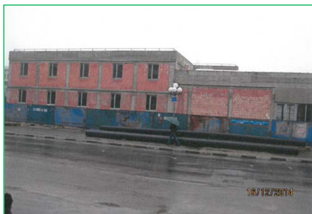
Clădire de călători – realizare zidărie
