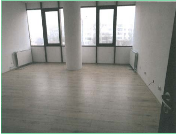
Montare parchet, instalații electrice și de climatizare
