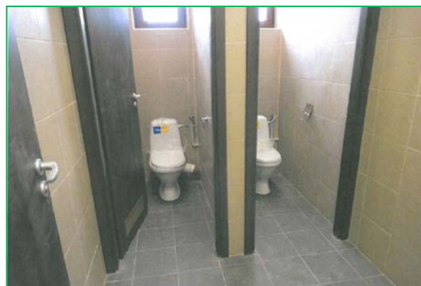
Montare obiecte sanitare Corp A1
