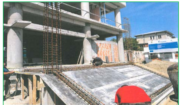
Cofrare rampă de acces clădire călători
