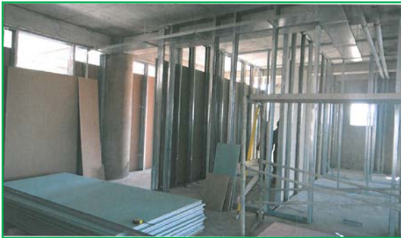
Montare structura metalică pentru placare cu ghips-carton
