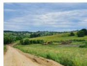
202106_Săpătură pentru platforma tehnologică coloane forate viaduct km 251+774
