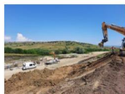
202107_Betonare și taluzare consolidare cu piloți Beia km 247+295 ÷ 247+633
