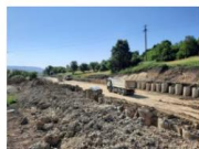
202106_Săpătură între coloane forate consolidare km 242+448 ÷ 242+929
