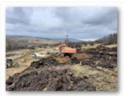
202102-Paloș 1 km - 242+700 Profilare taluz Fir II_2
