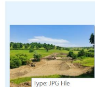
Type: JPG File Size: 85.7 KB Date modified: 31/01/2022 202106_Săpătură pentru platforma tehnologică coloane forate viaduct km 252+525
