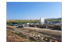
202107_Cofrare și armare grinda de coronament - consolidare Beia km 247+295 ÷ 247+633
