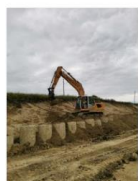
202106_Săpătură în ampriză, săpătură între piloți consolidare
