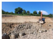
202106_Săpătură în ampriză, săpătură între piloți consolidare și taluzare km 242+448 ÷ 242+929
