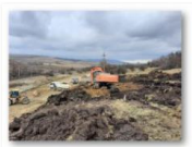
202102-Paloz 1 km - 242+700 Profilare taluz Fir II_2
