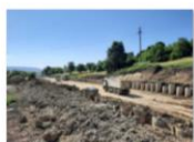
202106_Săpătură între coloane forate consolidare km 242+448 + 242+929
