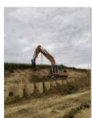
202106_Săpătură în ampriză, săpătură între piloți consolidare
