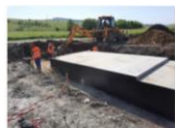
202106_Umpluturi compactate în straturi în jurul fundației podetului km 239+365
