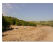
Livrare beton in santier
