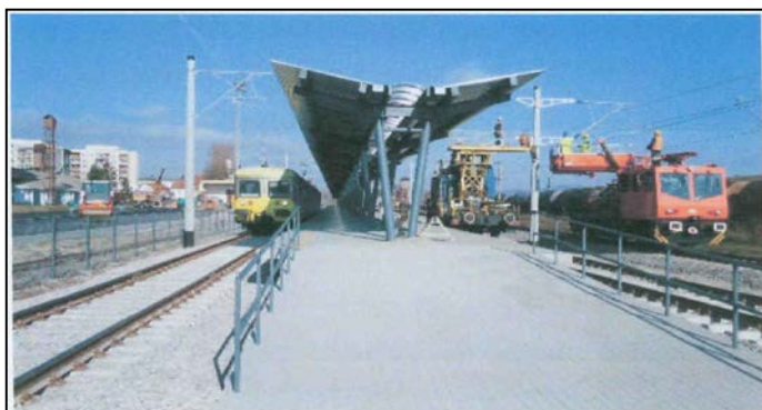
Lucrări pentru finalizarea electrificării liniei III
