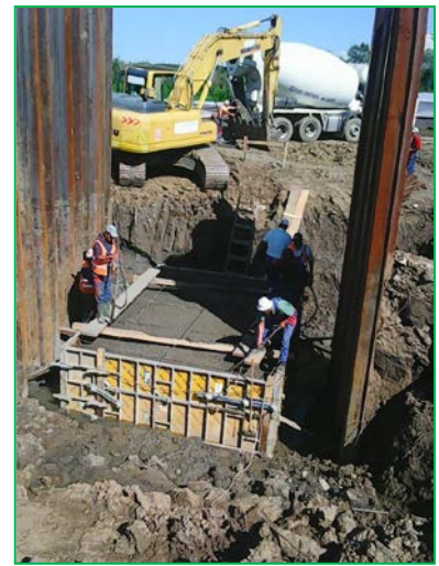
Realizare fundație pila P1
