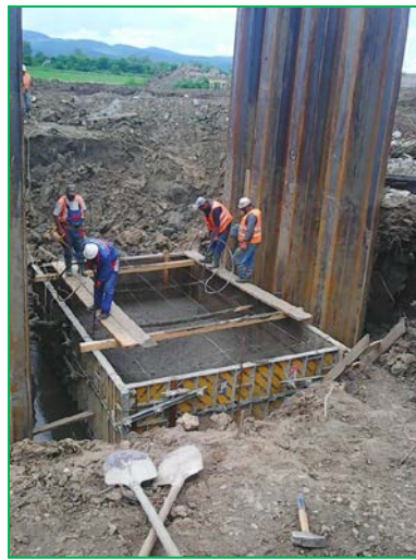
Realizare fundație pila P1
