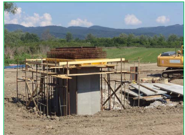
Armare pila P5
