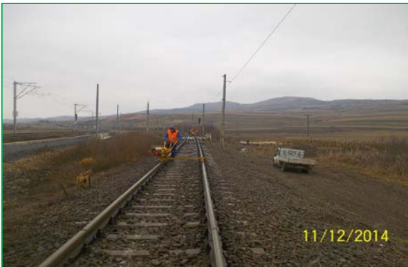
Reglare statica a linie de contact Micășasa cap X fir I
