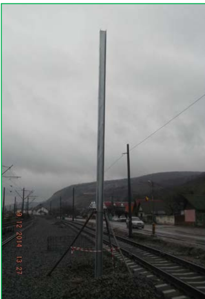
Stația Valea Lunga, Instalare stâlpi între liniile 1 și II
