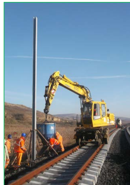
Turnare beton în fundație pe interval Crăciunel - Pod Mureș fir II
