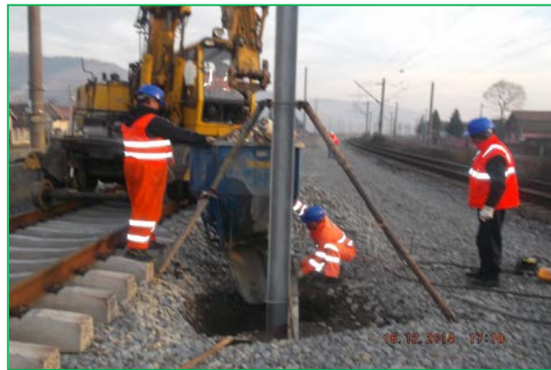
Stația Valea Lunga, Turnare beton în fundație
