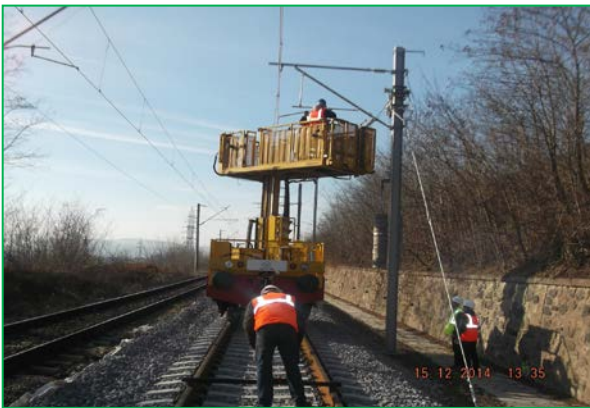
Reglare statica a linie de contact Micășasa cap X fir I
