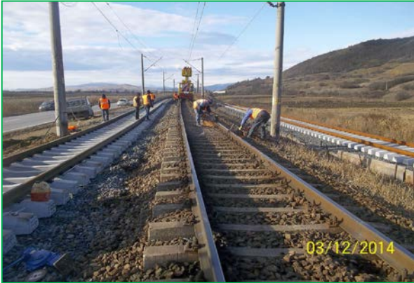
Interval Crăciunel-Podu Mureș, FIR I, Demontare Fir
