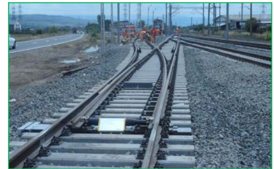
km 408+500 pr. – Stația BARABANT
