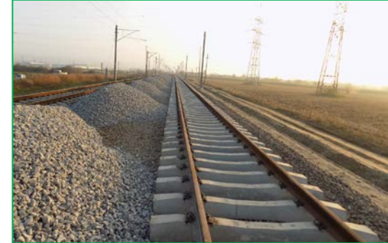
km 409+100 pr. – Stația BARABANT
