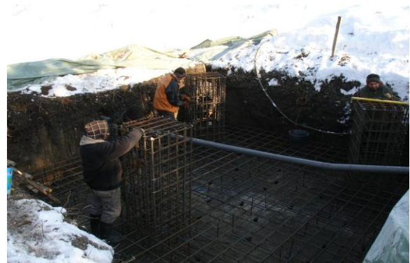
Foto 10. Montare armătură metalică fundație turn antenă GSM-R în stația Crivina. Se observă în ampriza fundației cele 5 cabluri de semnalizare care au fost protejate în țevă de plastic
