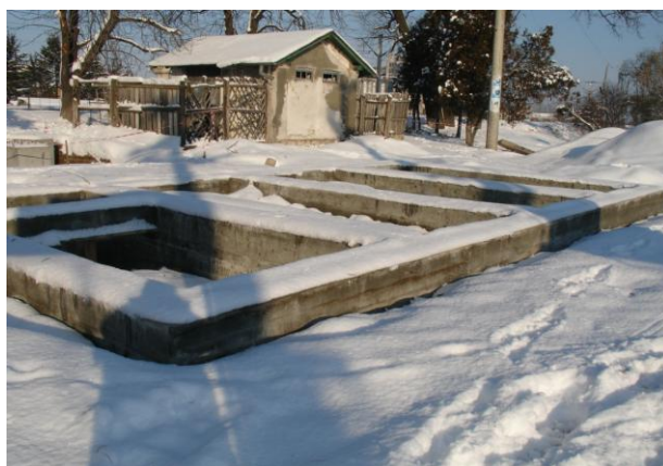
Foto 6. Vedere fundație clădire container stația Periș
