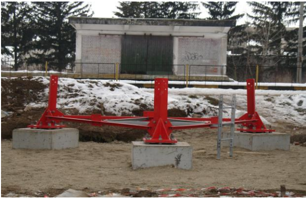
Foto 7. Montare elemente de susținere turn antenă GSM-R stația Periş
