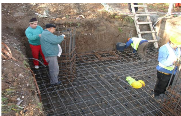
Foto 4. Montare armătură fundație turn GSM în stația Periș
