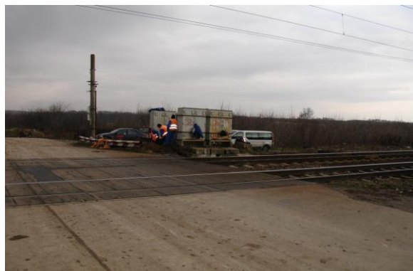
Foto 12. BAT Dîrza km.19+775 lucrări de montare a noilor fundații pentru semnalele de avertizare rutieră precum și a noilor dulapuri de aparat
