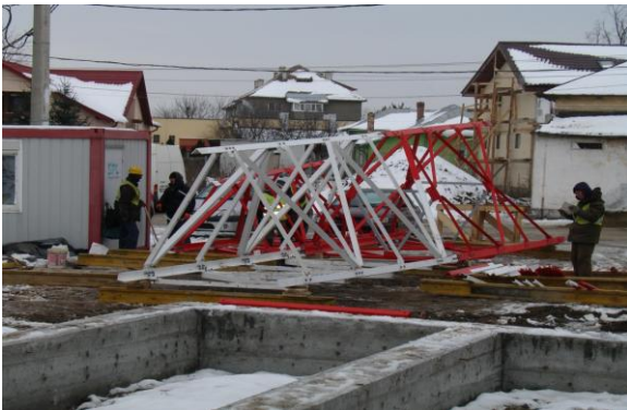
Foto 9. Se lucrează la montarea ultimelor segmente ale turnului de antenă GSM-R
