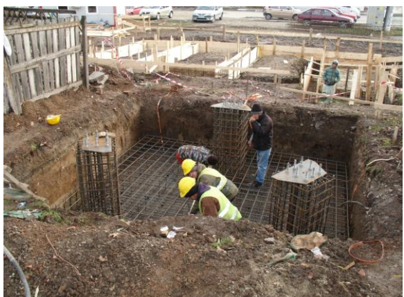
Foto 5. Confecție armătură metalică pentru fundația turnului GSM-R în stația Periș. În planul depărtat se observă armătura metalică și cofrajele realizate pentru fundația clădirii container pentru instalațiile electronice de semnalizare
