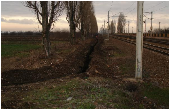
Foto 13. Pozare cabluri de semnalizare dulap DAC în stația Buftea
