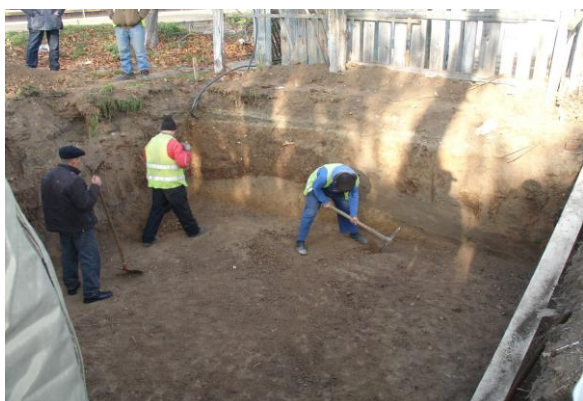
Foto 3. Săpătură pentru fundația turnului de antena GSM-R stația Periș
