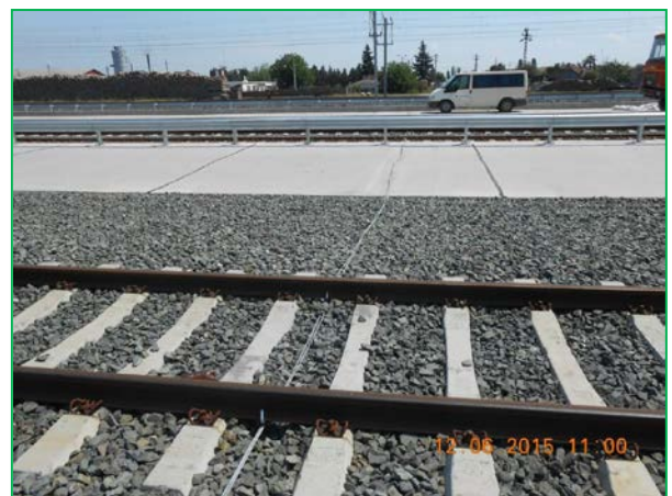
Stația Curtici – bază de montaj - execuție legături echipotențiale
