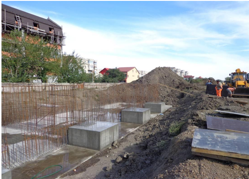
Corp B – Decofrarea cuzinetilor stâlpilor din axul K
