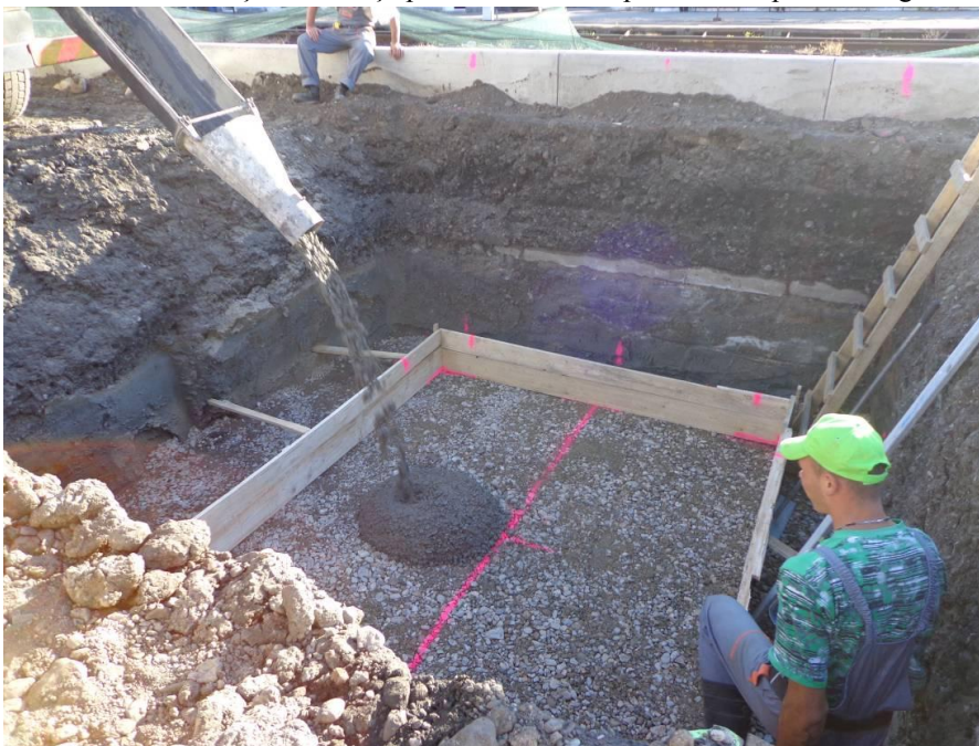
Peron L3 – Turnare beton de egalizare C8/10 fundație stâlpi copertină
