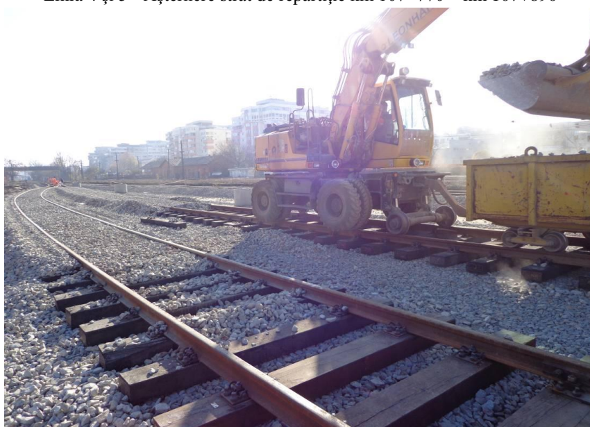
Liniile 4 și 5 – Așternerea celui de al doilea strat de piatră spartă km 107+770/+930
