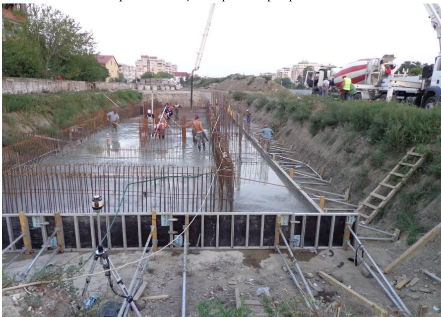
Corp C – Nivelare beton
