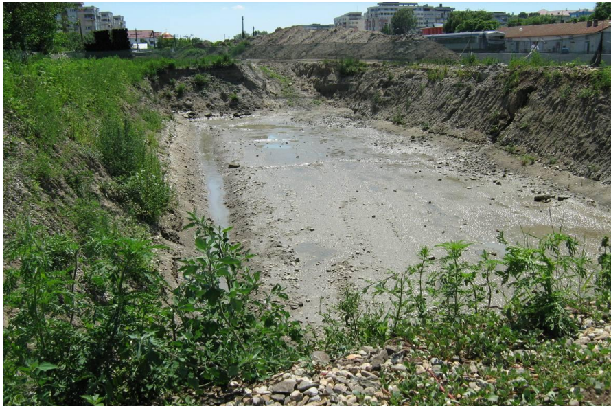
Săpătură fundație Corp C – după epuismenle
