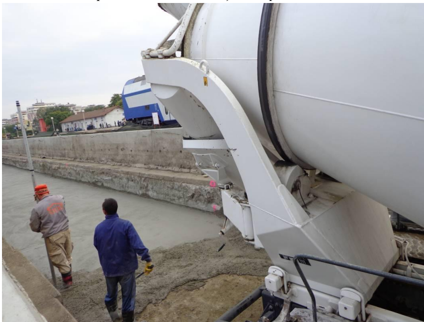
Corp B – Turnare beton de egalizare C8/10
