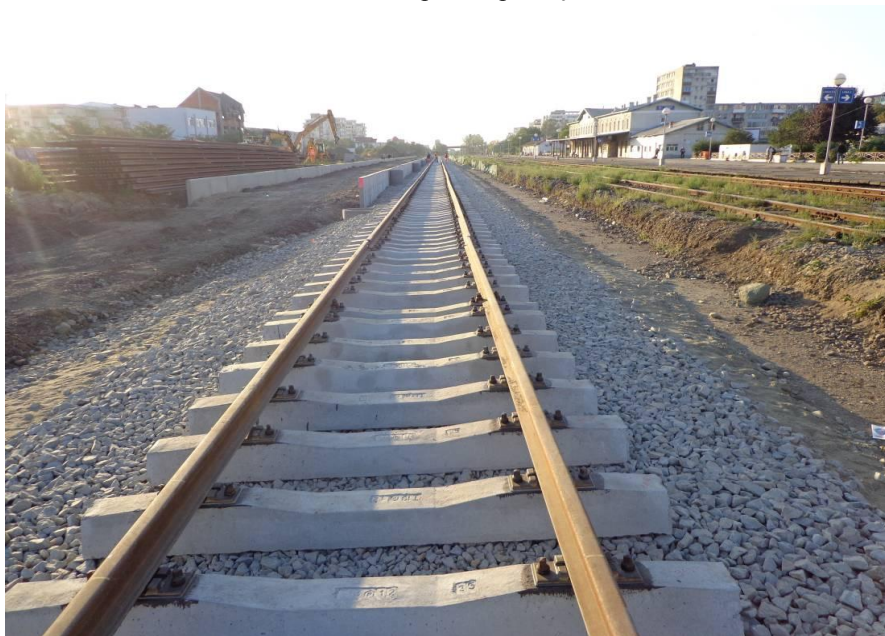
Linia 3 – Traversele și șina montate
