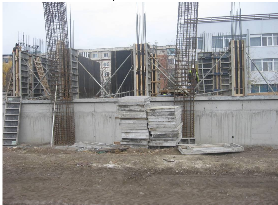
Corp C – Cofraj și armare elemente verticale parter
