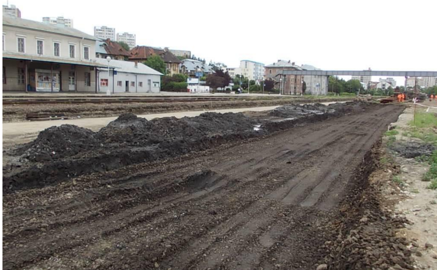
Linia 3 - săpătură platformă
