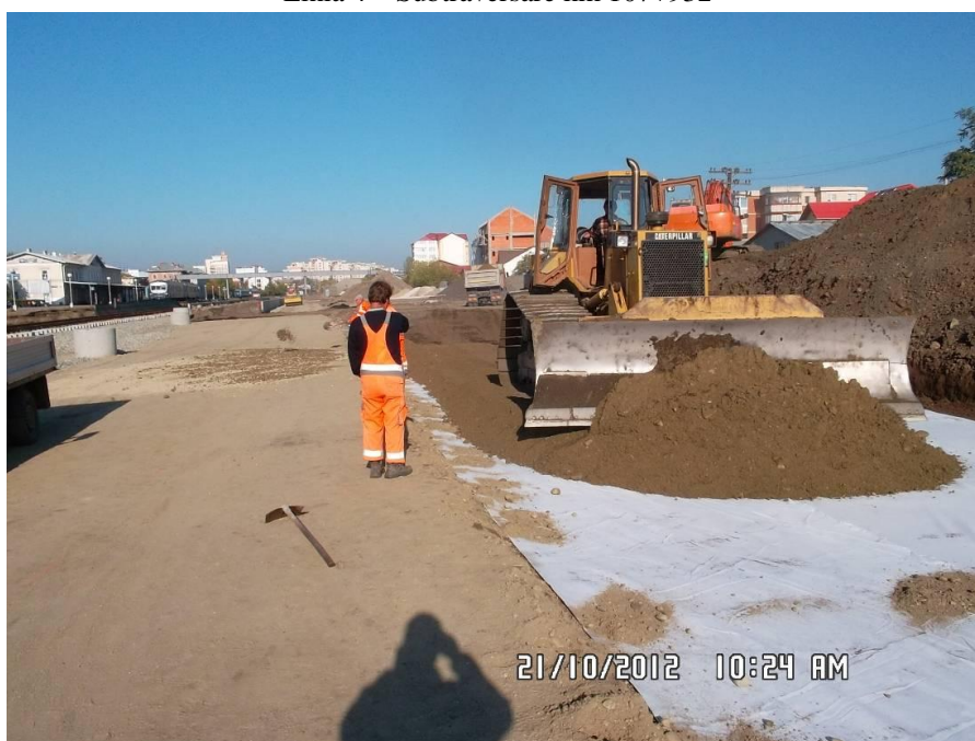
Linia 4 și 5 - Așternere strat de repartiție km 107+770 – km 107+890
