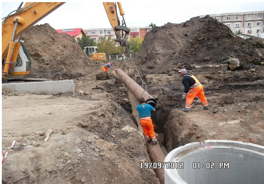
Linia 4 – Subtraversare km 107+932
