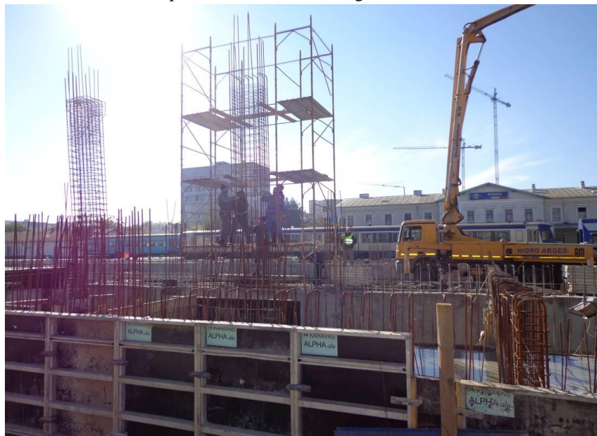
Corp B – Armare stâlpi ax K
