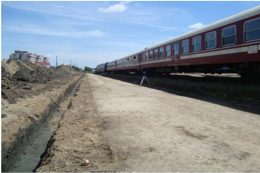
Peron liniile 3 și 4 - fundații pentru elementele prefabricate partea stângă
