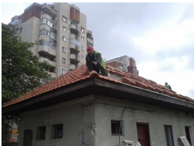
Clădire grup sanitar – Realizare acoperiș
