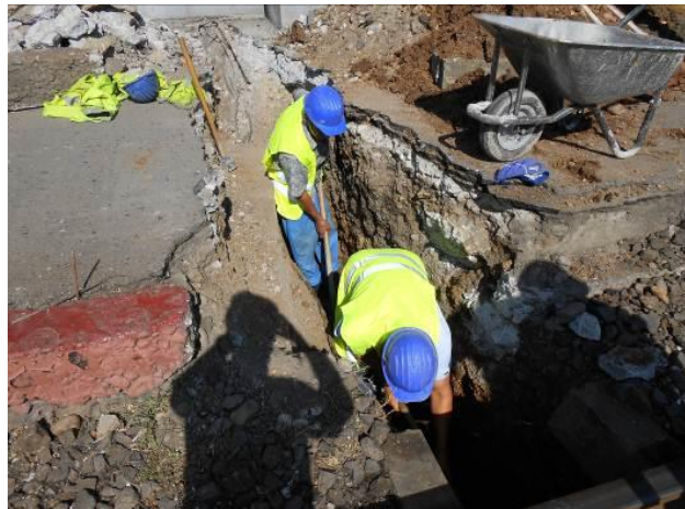
Execuție subtraversări cabluri CED
