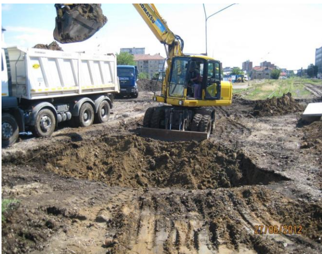
Săpătură amplasament tunel pietonal
