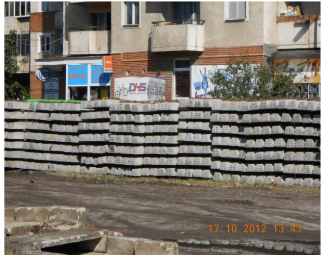
Aprovizionare traverse noi
