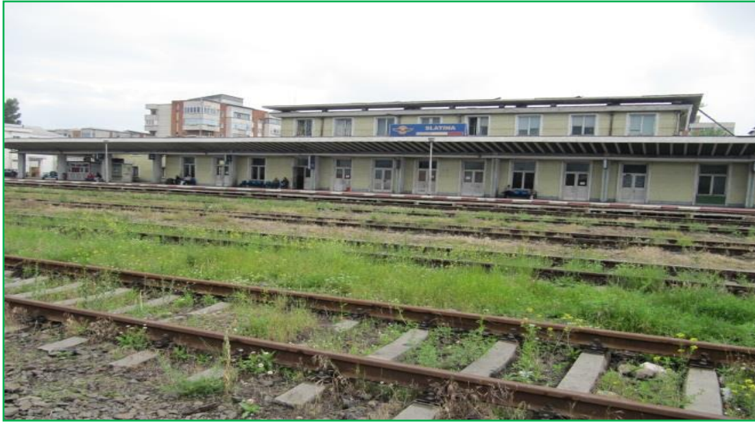
Decopertări la pereți și tavane (subsolul clădirii de călători)
