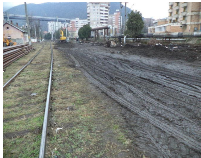
Terasamente CF – amenajare platformă
