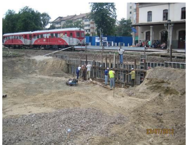
Realizare sprijiniri pentru linia 2 aflată în circulație
