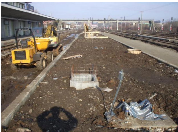
Execuție cămine de tragere și cămine de canalizare
