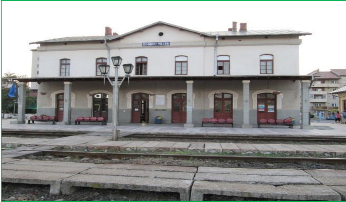
Demolare clădire ELF
