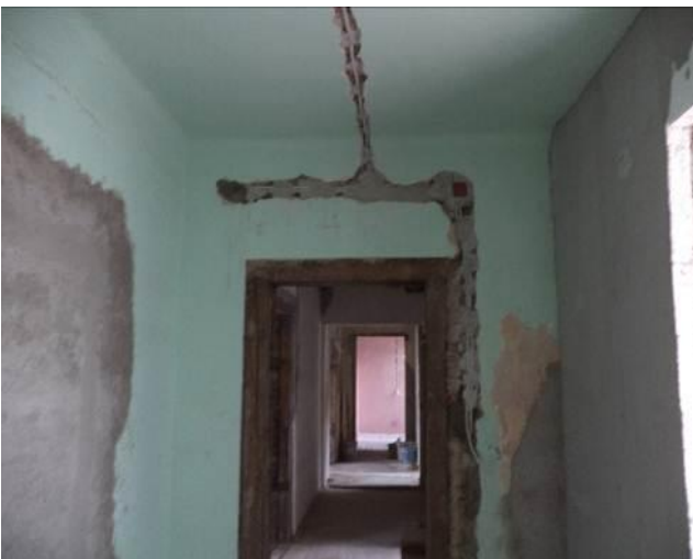
Clădire de călători – trasee instalații electrice
