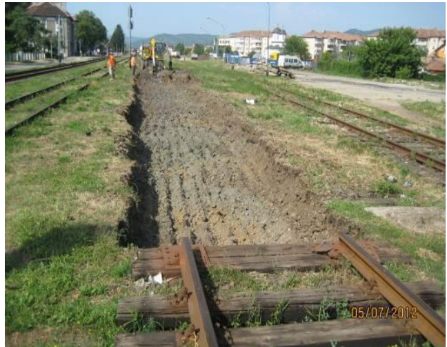
Realizare sprijiniri pentru linia 2 aflată în circulație
