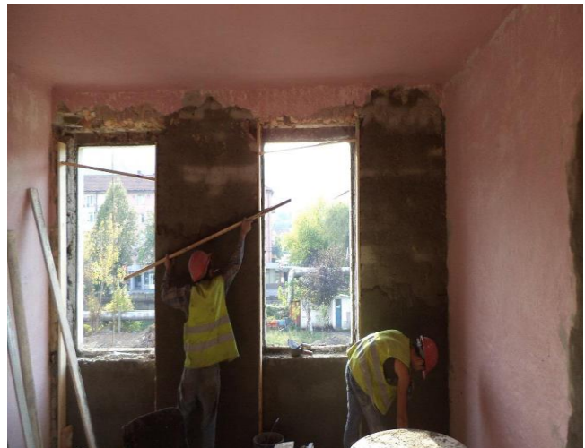
Clădire grup sanitar – execuție tencuiei
