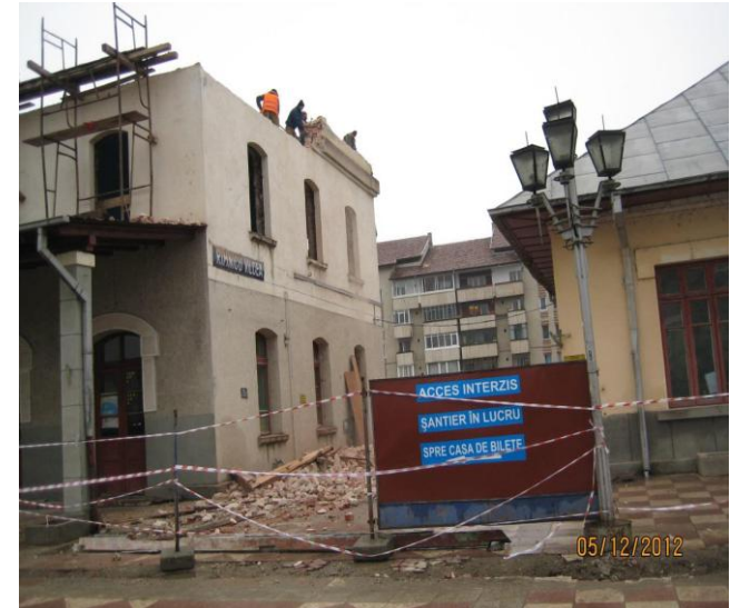
Clădire de calatori – lucrări de desfacere a tâmplăriei exterioare
