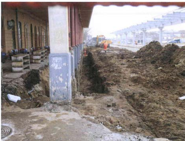
7. 30.01.2013-Săpătură executată la peronul principal în vederea montării elementelor prefabricate tip ZP
