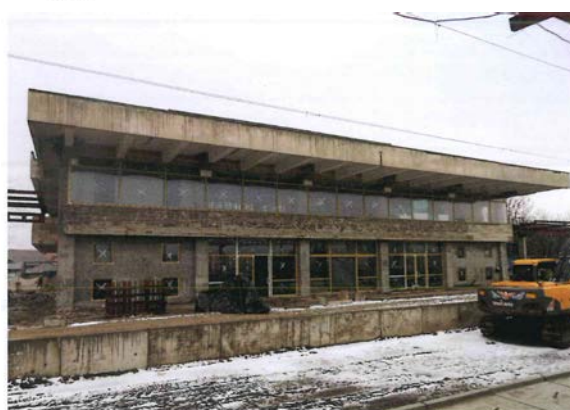
4. 31.01.2013-Finalizare montare tâmplărie exterioară de aluminiu
