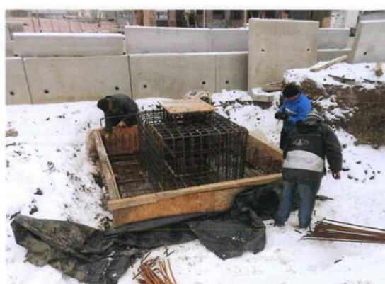
2. 29.01.2013-Armare fundații stâlpi copertină peron intermediar
