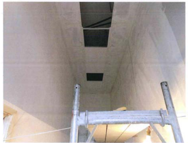
6. 30.01.2013-Lucrări de finisaj executate în holul clădirii de călători (zona Birou Mișcare)
