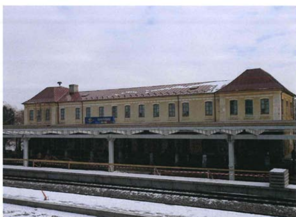
1. 30.01.2013-Finalizarea lucrărilor la învelitoarea clădirii de călători
