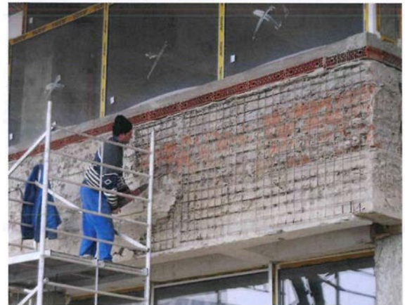
10. 31.01.2013-Desfacere placaj pe exteriorul clădirii de călători
