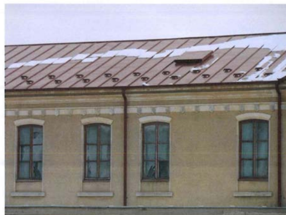
2. 30.01.2013-Montare de parazăpezi pe acoperișul clădirii de călători
