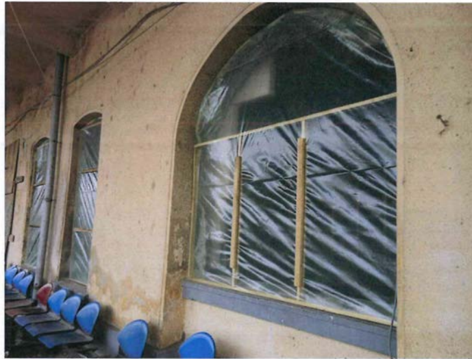
9. 30.01.2013-Protejarea lucrărilor de la parterul clădirii de călători
