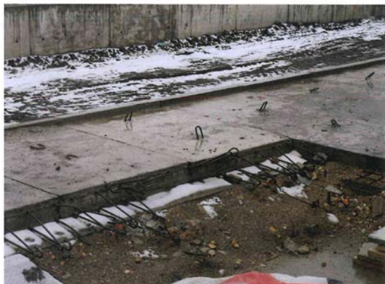
3. 31.01.2013-Montare elemente prefabricate tip DP3 în zona tunelului pietonal
