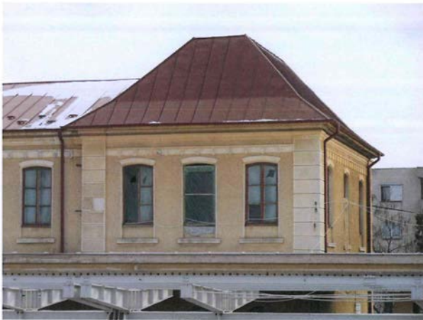
3. 30.01.2013-Finalizare montare sistem de scurgere a apelor de pe acoperișul clădirii de călători
