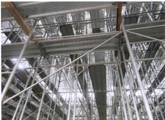
11. 31.01.2013-Montare schelă interioară pentru refacerea tavanului din holul central al clădirii de călători
