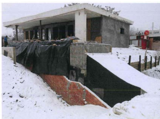
4. 29.01.2013-Betonare cuzinet cu carcase de buloane de pe rampa de acces din tunel la peronul principal
