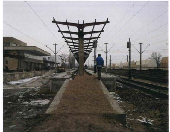
8. 31.01.2013-Umplură executată la rampa de acces al peronului intermediar
