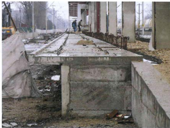
9. 31.01.2013-Finalizare montare elemente prefabricate tip DP la peronul intermediar (inclusiv protecție umplură)
