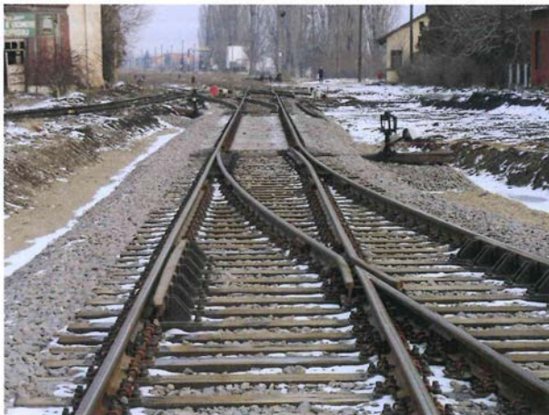
5. 30.01.2013-Finalizarea lucrărilor de balastare a aparatelor de cale montate în cap X
