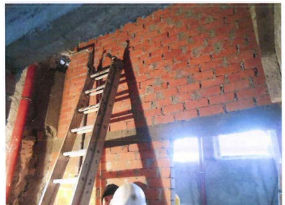
12. 31.01.2013-Lucrări de compartimentare executate la parterul clădirii de călători
