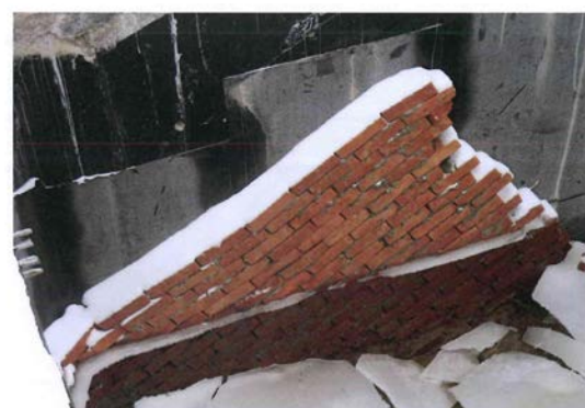
5. 29.01.2013-Protejarea hidroizolației cu cărămidă la rampa de acces la tunelul pietonal
