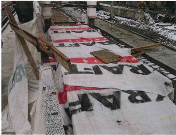
7. 31.01.2013-Demolare parapet existent de beton la tunelul pietonal
