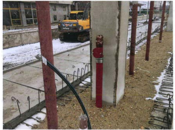
6. 31.01.2013-Țeavă de scurgere a apelor pluviale de pe copertina peronului intermediar
