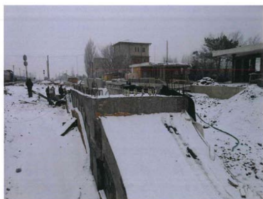
3. 29.01.2013-Betonare cuzinet cu carcase de buloane de pe rampa de acces din tunel la peronul intermediar
