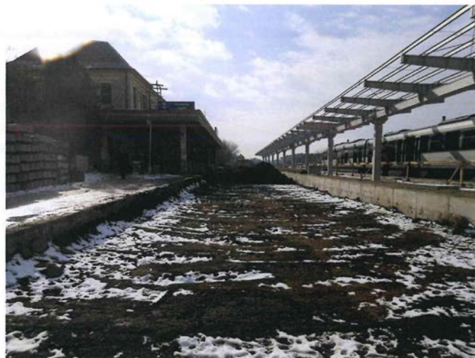
11. 30.01.2013-Lucrări de săpătură pentru realizarea terasamentului liniilor 1B și 2B
