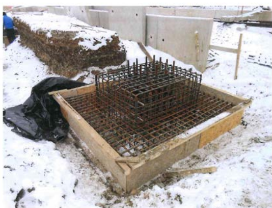
1. 29.01.2013-Cofrare fundații stâlpi copertină peron intermediar
