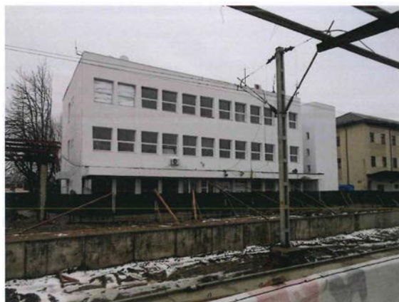
2. 31.01.2013-Finalizare lucrări de termosistem la clădirea CED
