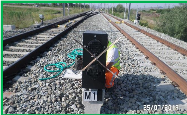
Coșlariu – instalare semnal pitic și bobină de joantă
