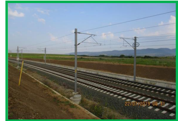
Profilare taluz - km 450+637 - 451+340
