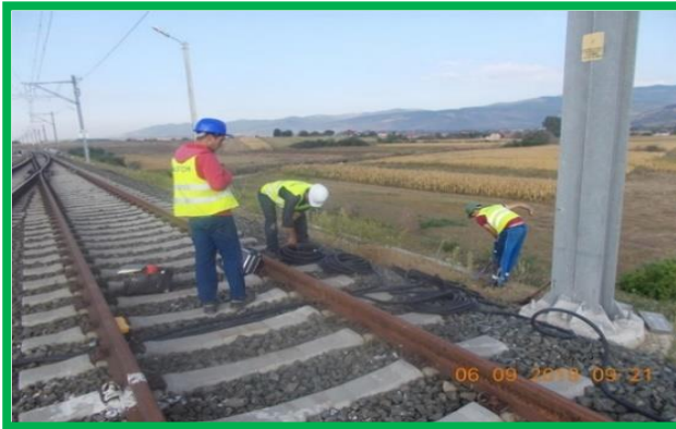
Vințu de Jos – instalare sistem de detectare a roților
