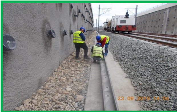
Orăștie – instalare canal de beton în tranșee tunel
