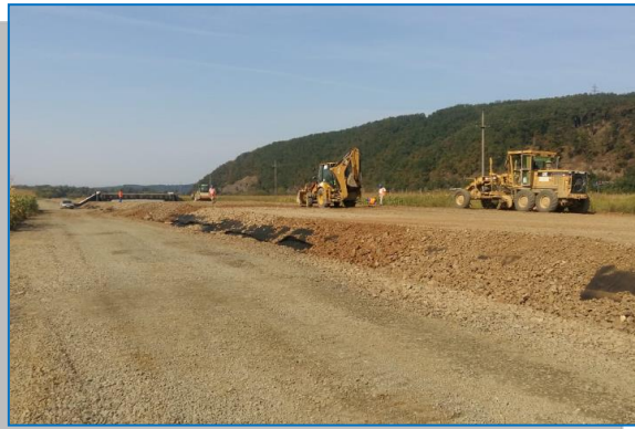
Terasamente – Ilteu - Săvârșin km 537+000
