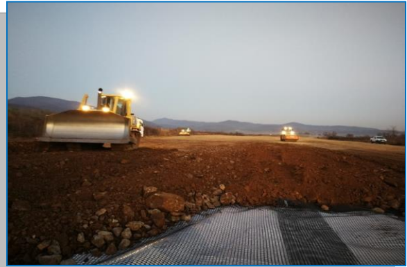
Umplură din material necoeziv km 527+700
