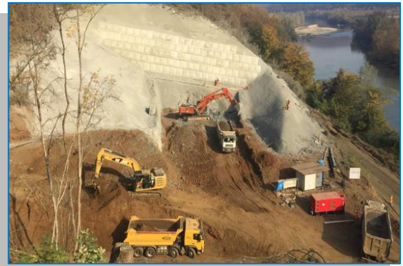
Vărădia - Bârzava - lucrări de excavare portal Simeria
