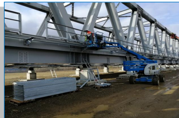
Milova - Bârzava – Asamblare trotuare – Pod km 574+550
