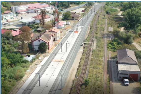
Suprastructură - Stația Păuliș
