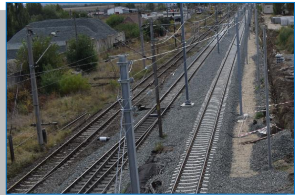
Suprastructură - Stația Ghioroc
