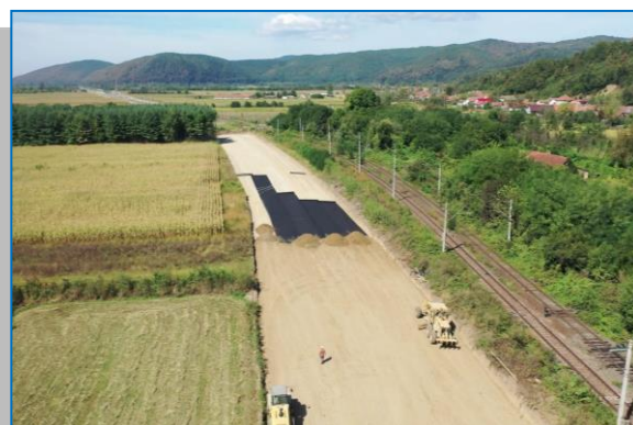
Terasamente – Vărădia - Bârzava
