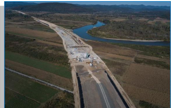
Zid de sprijin km 527+400 – km 527+700
