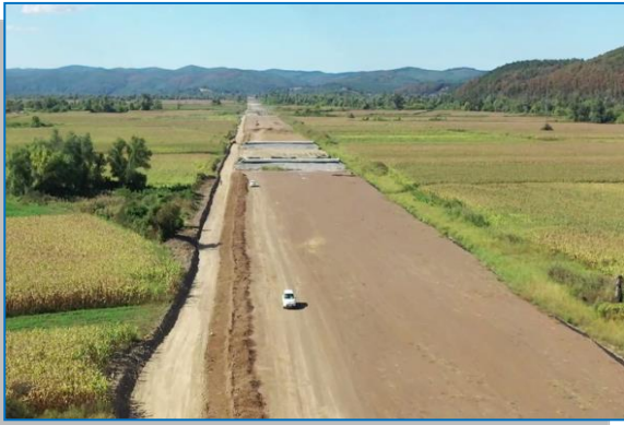
Vărădia - Bârzava - lucrări de umpluturi - km 561+000
