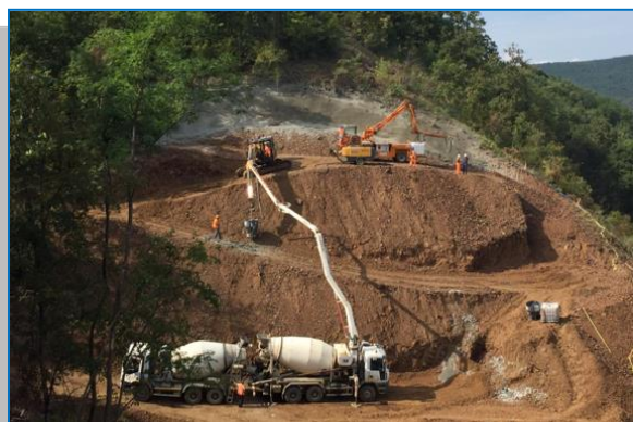
Bârzava - Vărădia – lucrări portal Simeria
