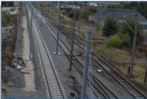
Suprastructură - Stația Ghioroc
