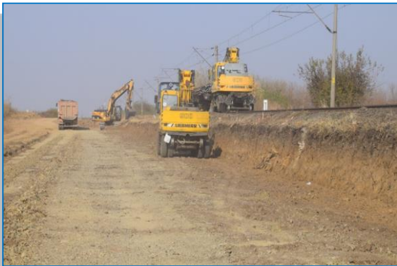
Terasament - interval Ghioroc – Păuliș
