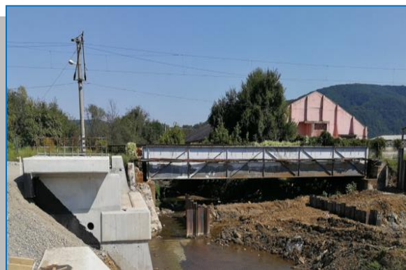
Stația Săvârșin – Pod km 541+540
