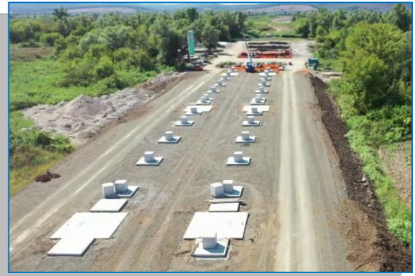
Vărădia - Bârzava – Pod km 554+868
