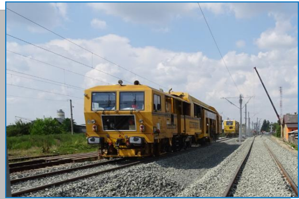
Suprastructură - Stația Ghioroc
