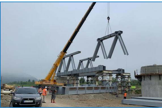
Montare tablier metalic deschidere - Pod km 517+440
