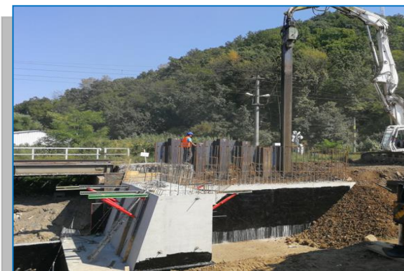
Stația Săvârșin – Pod km 542+670
