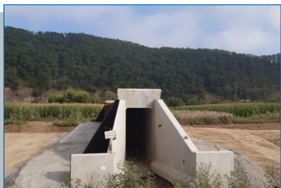
Săvârșin – Ilteu – lucrări de umpluturi Podeț km 535+746
