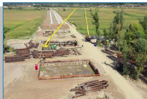
Vărădia - Bârzava - lucrări de sprijiniri, pod km 564+514
