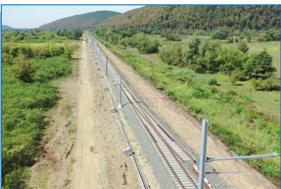
Stația Bârzava – lucrări de semnalizare și LC
