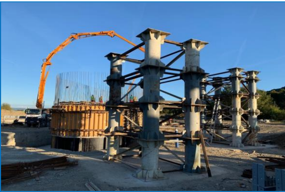
Execuție palei - Pod km 517+440
