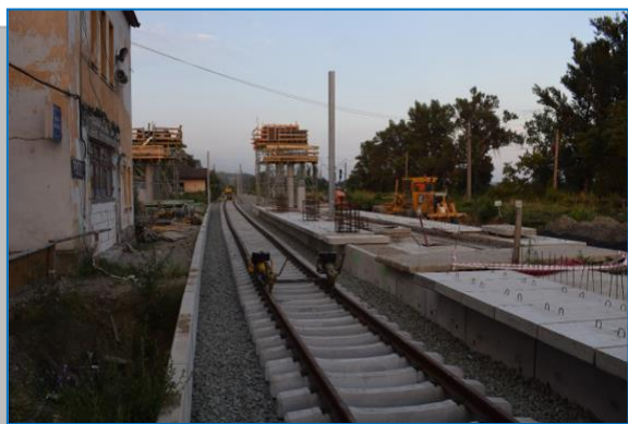
Suprastructură – Stația Păuliș
