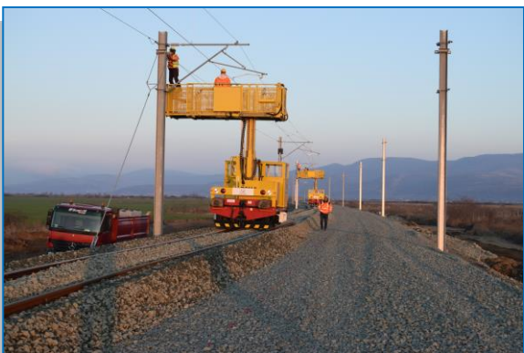
Ghioroc - Km 614 – montaj console pe stâlp
