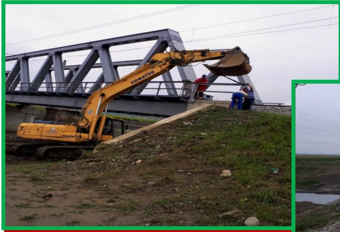
Montare balustrade pe culei
