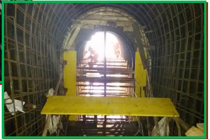
Finalizare armare boltă
