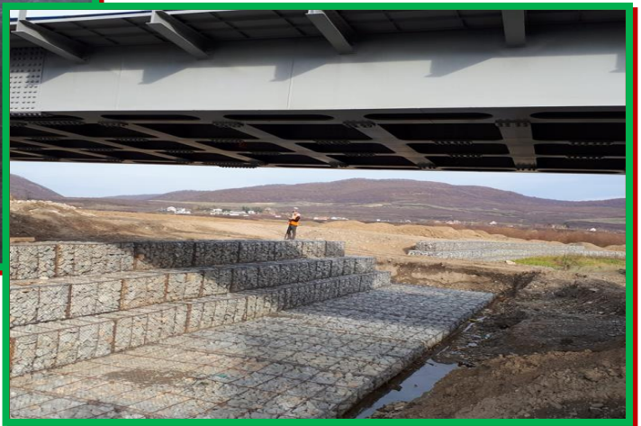
Montare gabioane pe sub podul nou
