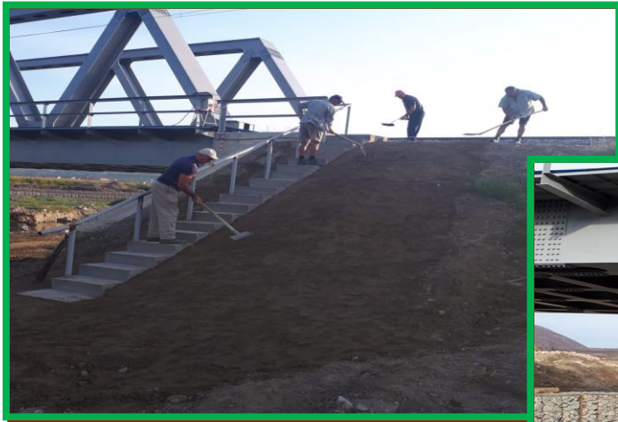
Turnare beton trepte scări pe taluze la culei
