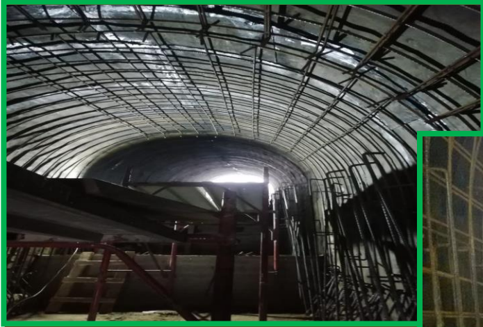
Finalizare armare plasă
