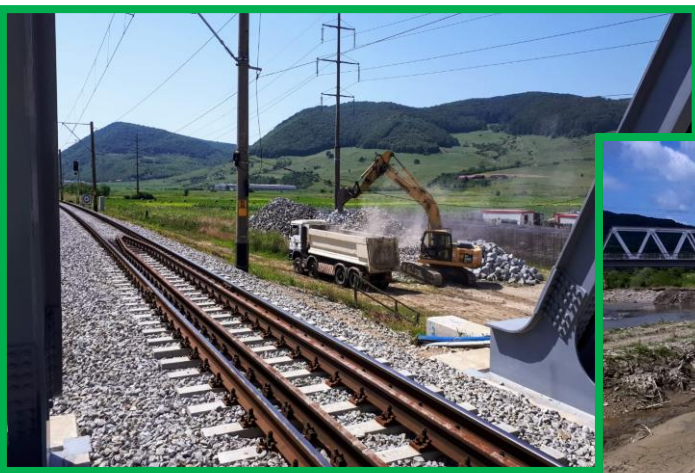
Piatră gabioane și montare gabrioane
