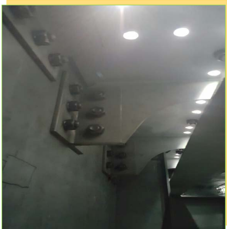
Realizare consolidare în caseta tablierului, fir II
