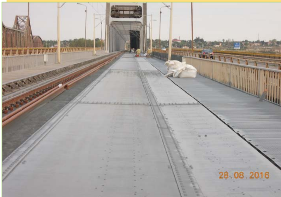
Lucrări de sablare și vopsitorii, fir II
