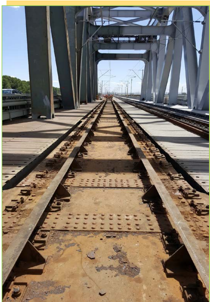
Demontare șină și elemente de prindere, fir II
