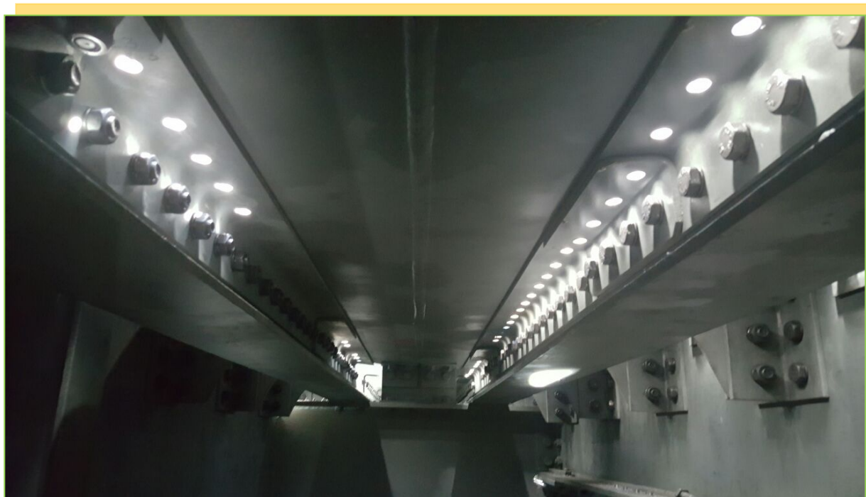
Realizare consolidare în caseta tablierului, fir II
