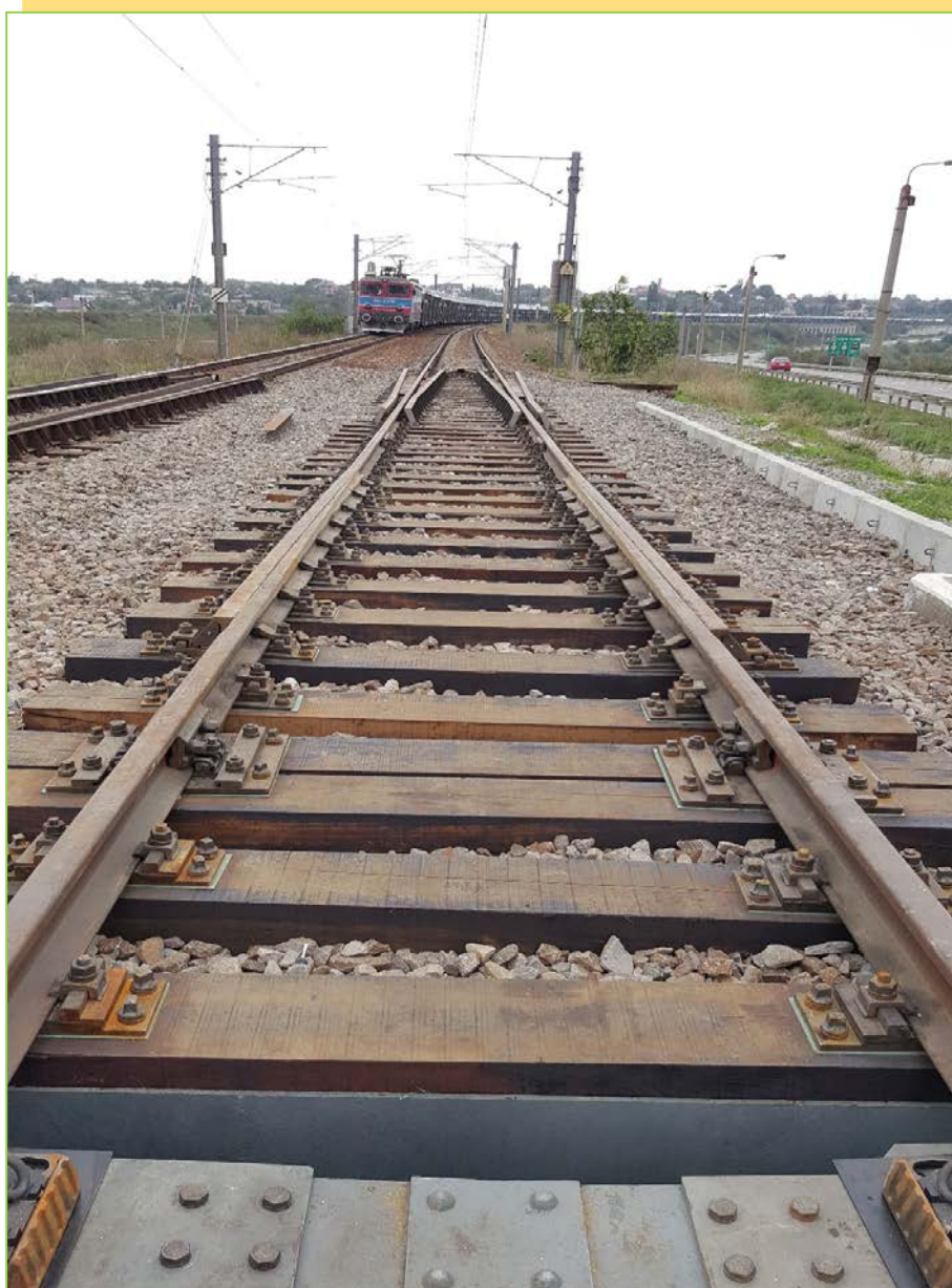
Realizarea racordării cu terasamentul și montaj aparat de compensare
