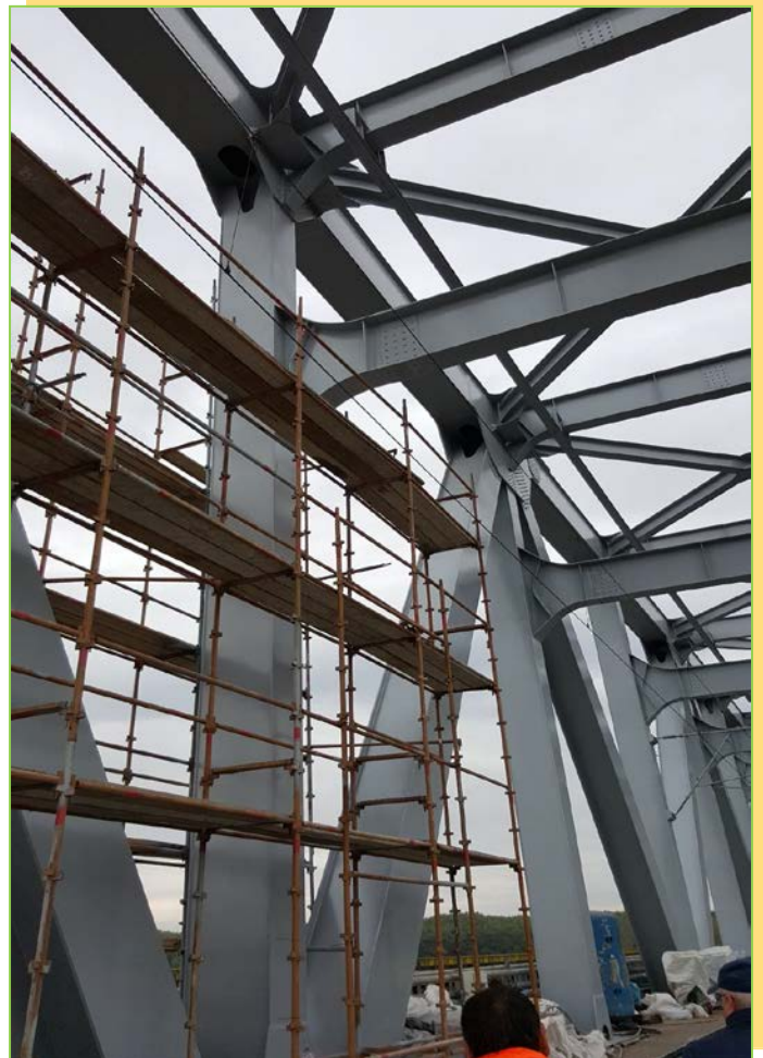
Lucrări de vopsitorii, fir II
