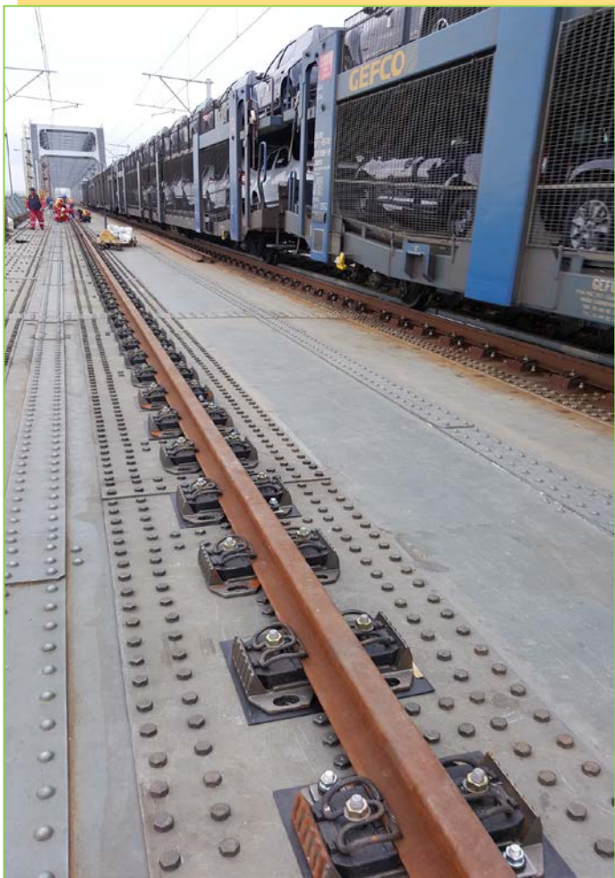
Montare prindere elastică, fir II
