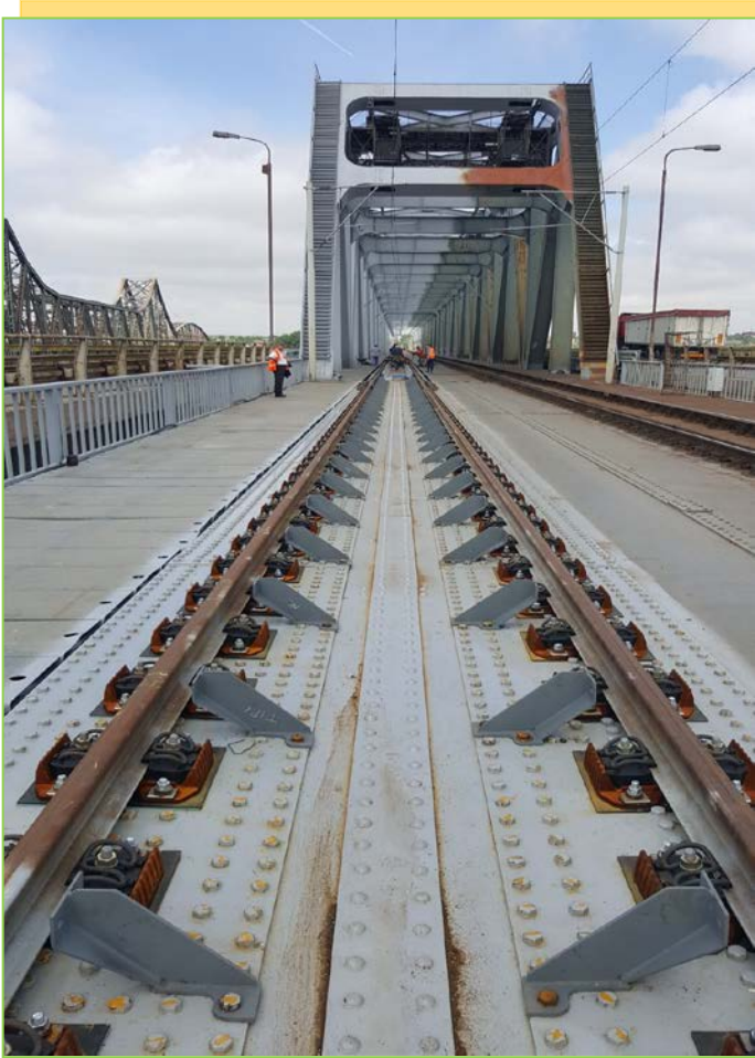
Montare suportți contrașină, fir I
