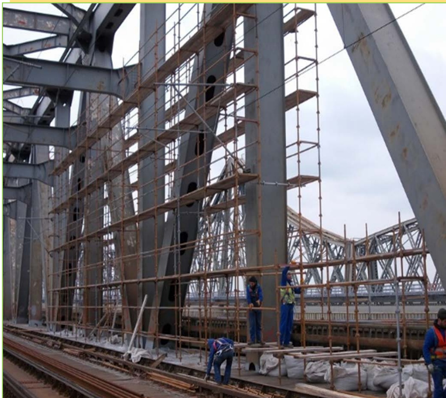
Montare schele pentru lucrări de vopsitorie
