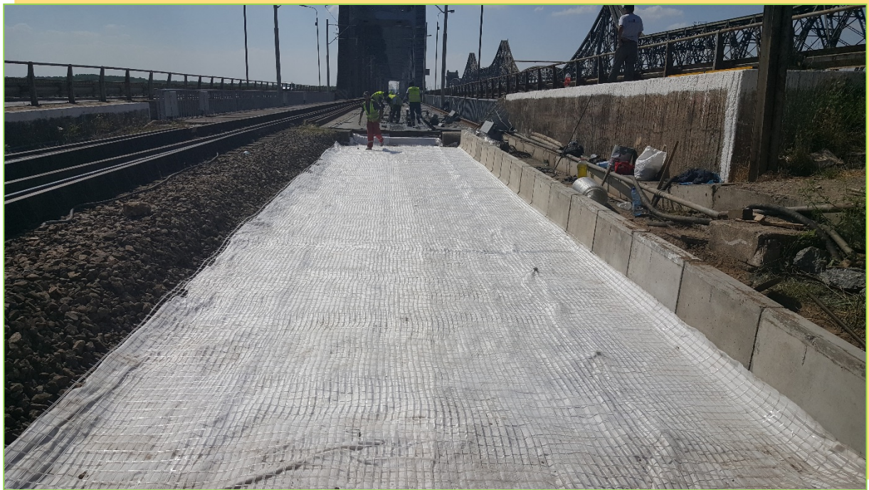
Iunie 2016 – racordarea podului cu terasamentul - pod Cernavodă Nou
