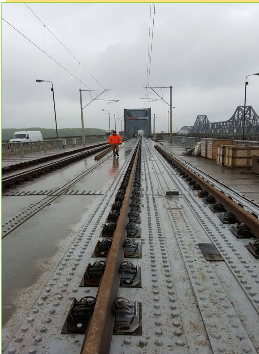
Montarea căii pe pod
