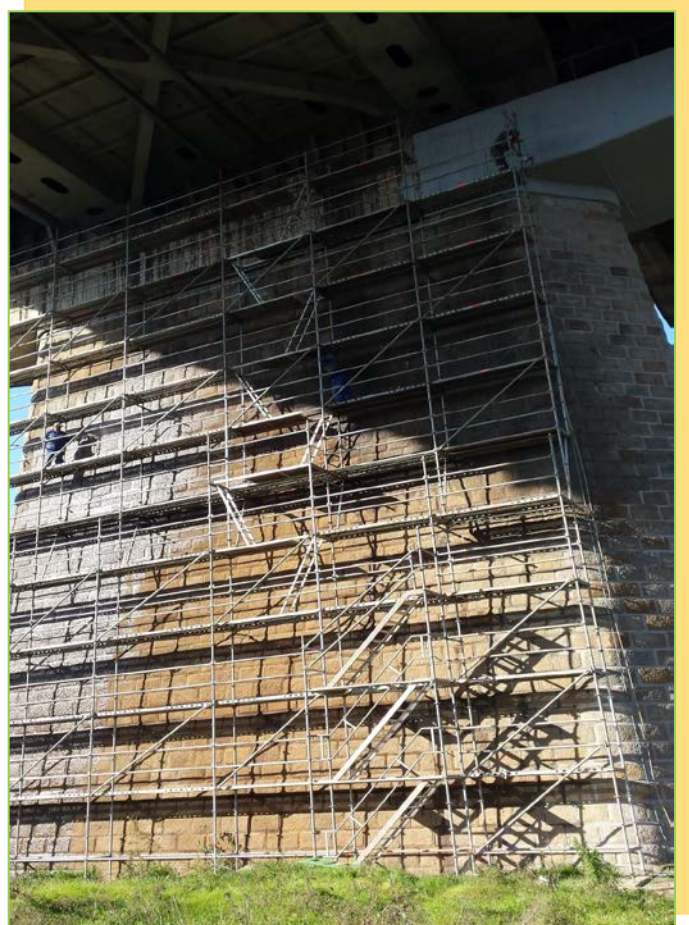
Lucrări de hidrosablare pilă mal
