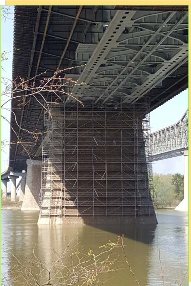
Montare schele pentru lucrări de infrastructură
