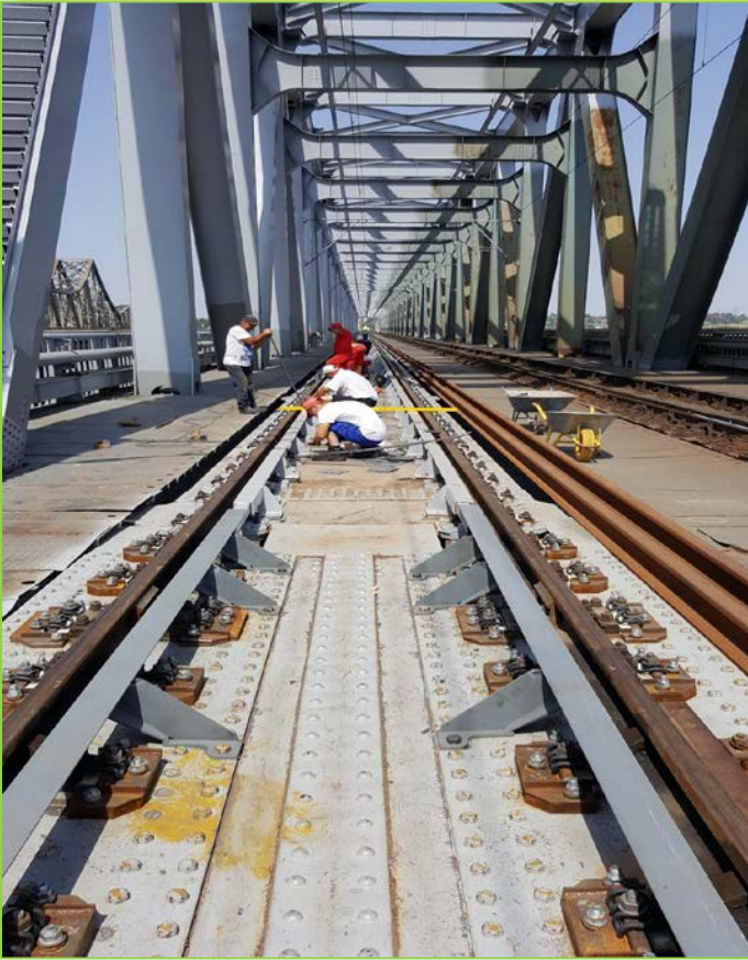
Montare contrașină, fir I
