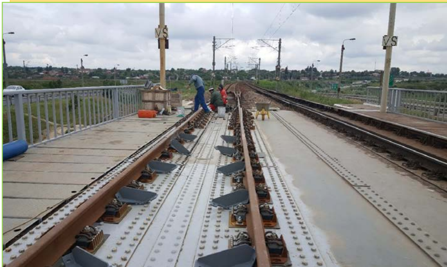
Racordare viaduct cu terasamentul, montare prindere DRV
