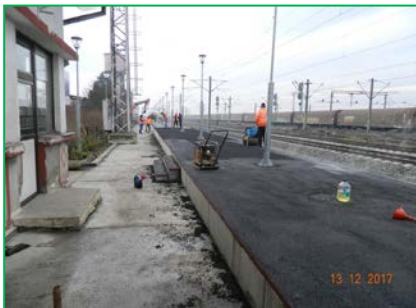
St. Coșlariu – execuție peron principal
