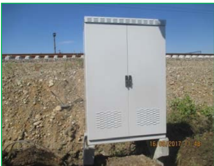
Coșlariu – instalare dulap exterior
