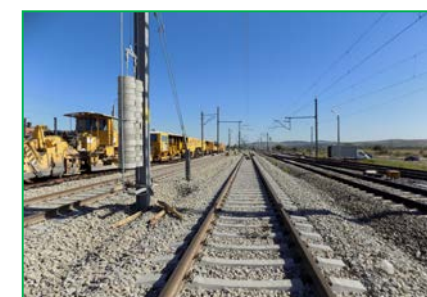
km 411+675pr. – aşternere strat 2 de piatra spartă şi execuţie buraj
