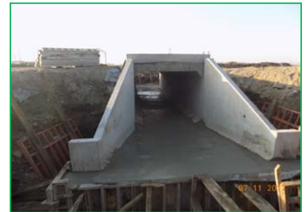
Podet km 402+656 – execuție fundație
