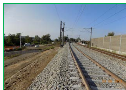
km 401+225pr. – realizare buraj, sudură şi montare LC
