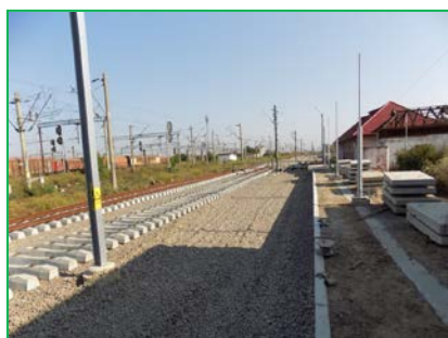
km 403+150ex. - aşternere piatra sparta şi montare suprastructura
