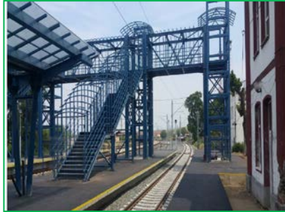
Pasarelă, Stația Orăștie
