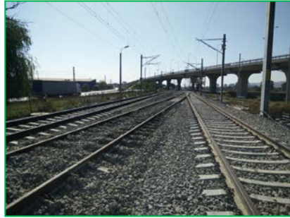
km 413+025pr. – execuție buraj și sudura suprastructura
