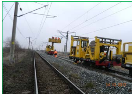
km 401+850pr. – realizare buraj, sudură și montare LC
