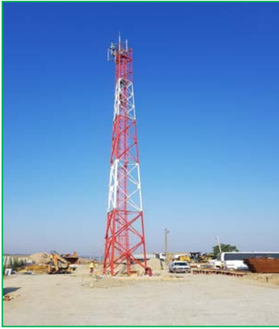
Tunel Turdaș Est – instalare turn GSM-R
