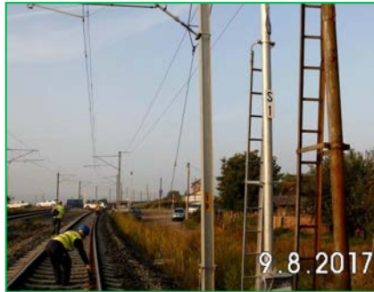
Alba Iulia – instalare semnale de avarie
