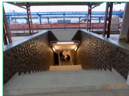
Stația Alba-Iulia –scara acces tunel pietonal
