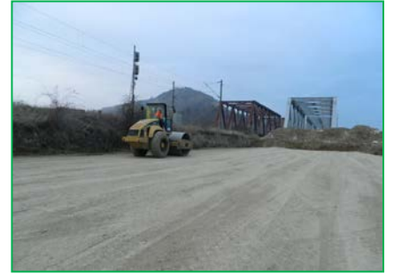
km 395+325pr. - execuție îndesire strat de transfer
