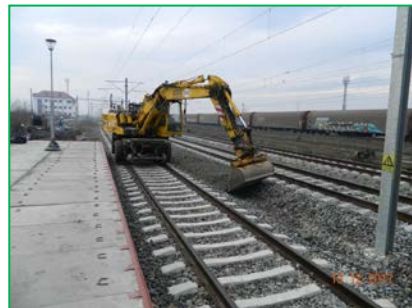
km 403+250ex. – realizare buraj, sudură și montare LC
