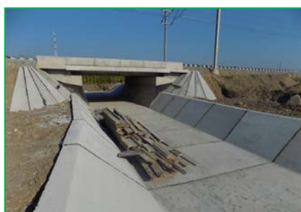
Podeţ km 400+439pr. – execuţie sferturi de con şi amenajare albie aval
