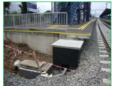
Orăștie – instalare cameră tragere
