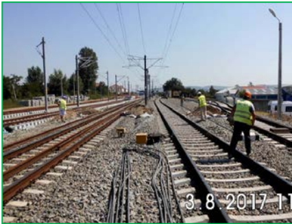
Alba Iulia – instalare cabluri
