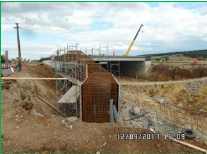
Pasaj km 455+582 - montare armătură
