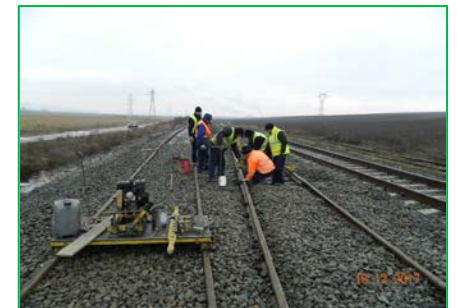
km 1+025pr.– montare joante izolante racord Alba-Iulia spre Sibiu
