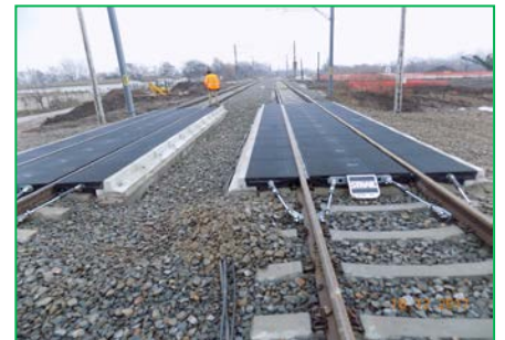
km 402+247pr. – montare dale elastice trecere la nivel
