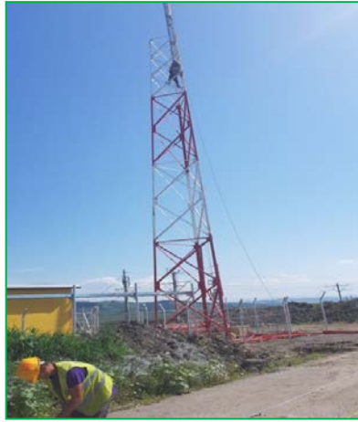
Sântimbru – instalare turn GSM-R
