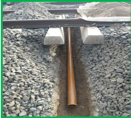
Bărăbaș – subtraversare și compactare
