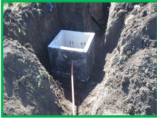
Bărăbaș – instalare cameretă și canal beton
