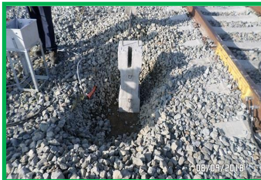
Alba Iulia – instalare fundație semnal pitic și canal beton
