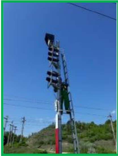
Podu Mureș – echipare semnale cu panouri LED
