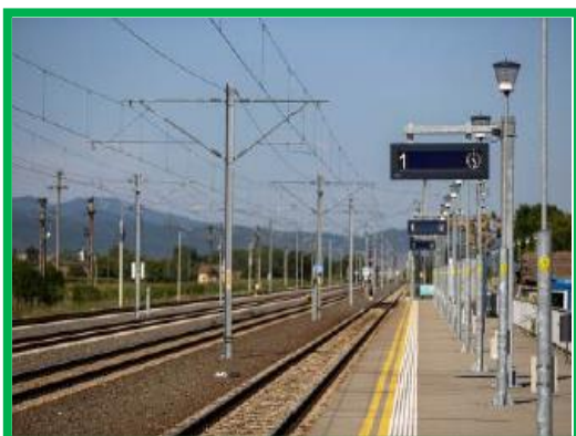
Panouri informare si iluminat peron Aurel Vlaicu
