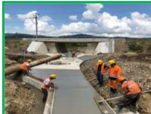
Lucrări pentru scurgerea apelor podeț km 436+483 – Stația Șibot
