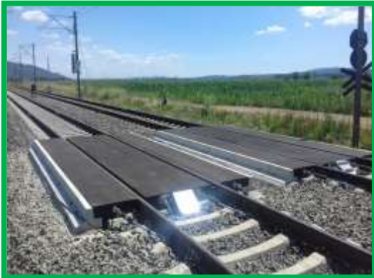
Trecere la nivel Băcăinți, km 439+327
