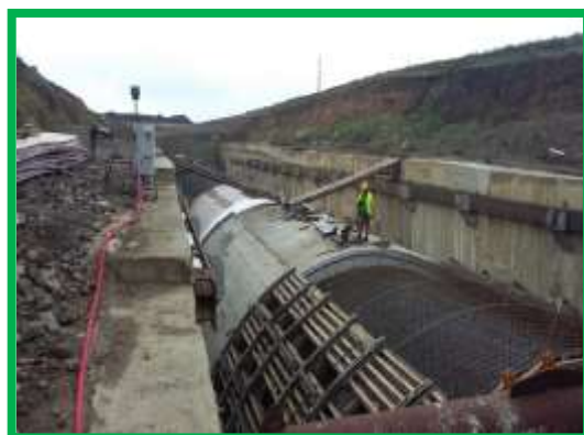
Armare bolta – Tunel Turdaș
