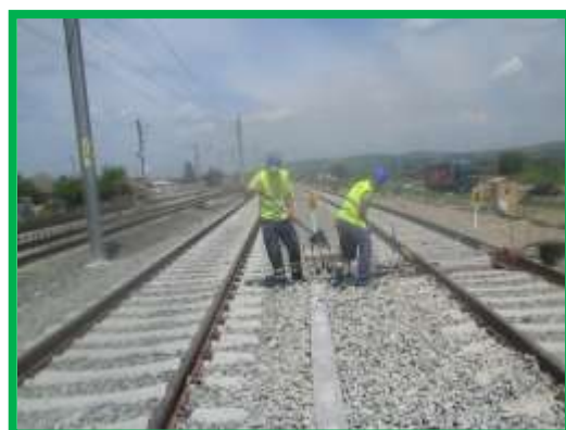
Stația Mediaș, instalare inductori
