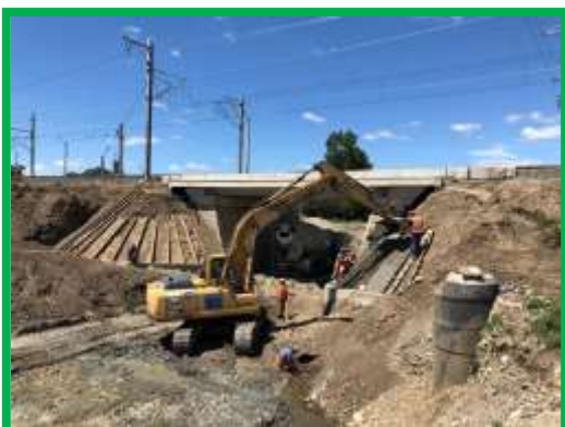
Umpluturi și percu pe sferturi de con pod km 436+699 - Stația Șibot
