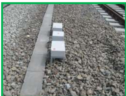
Stația Coșlariu - instalare console susținere cablu aerian
