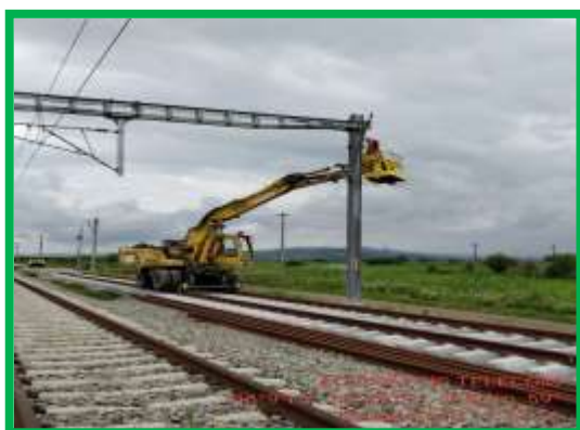
Stația Coșlariu - instalare console susținere cablu aerian
