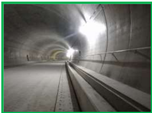
Montare mana curenta pe canal de evacuare ape Tunel Turdaș
