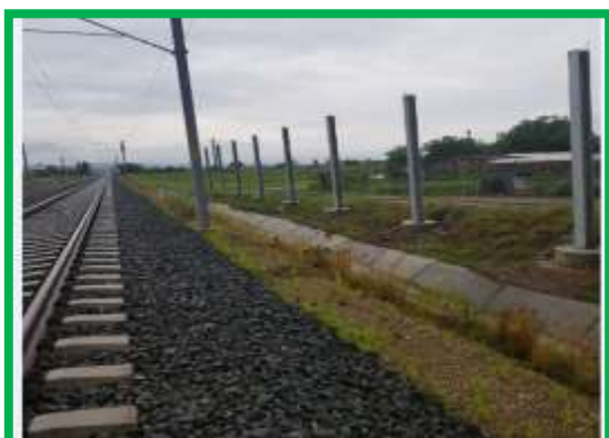
Fundatii si stalpi panouri fonoabsorbante Orăștie - Simeria
