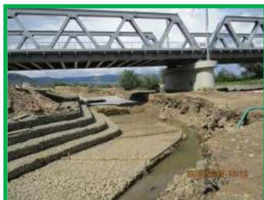
Protectie cu Gabioane - Pod peste raul Strei
