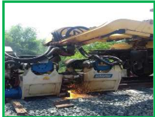
Realizare sudură - Stația Șibot
