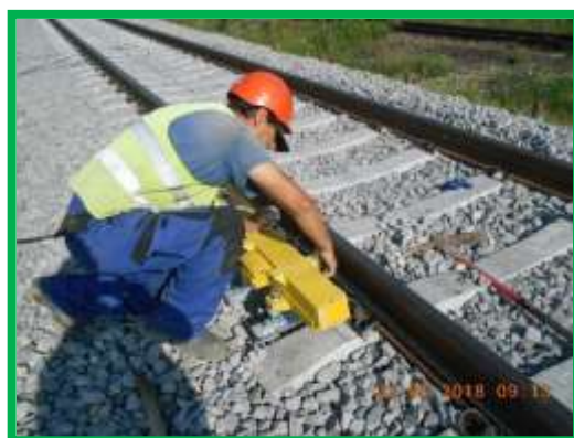
Stația Mediaș, instalare inductori
