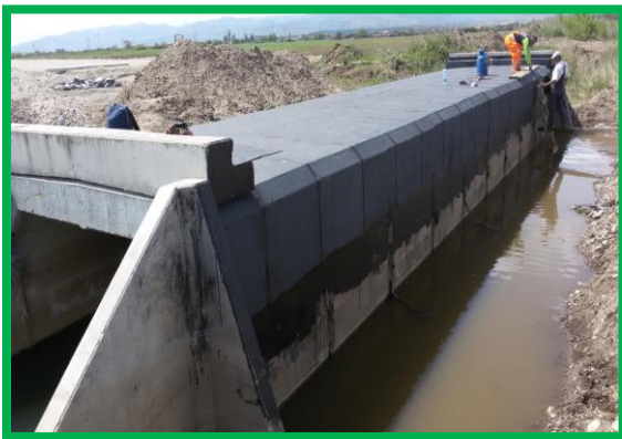
Podetș 396+302 - hidroizolație podetș
