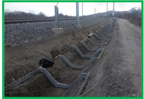
Rigolă monolită km 402+300-500 - cofrare și betonare
