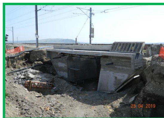
Poduț km 404+452ex. Fir 1 – Execuție dala de beton
