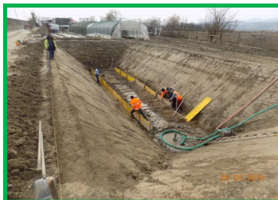
Km 415+700pr. Fir 1 – Realizare bazin de evaporare
