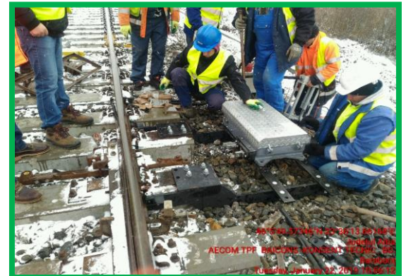
Stația Bărăbaș - instalare electromecanism de macaz
