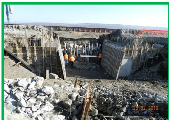
Podet km 404+452ex. Fir 1 – Execuție elevație culei
