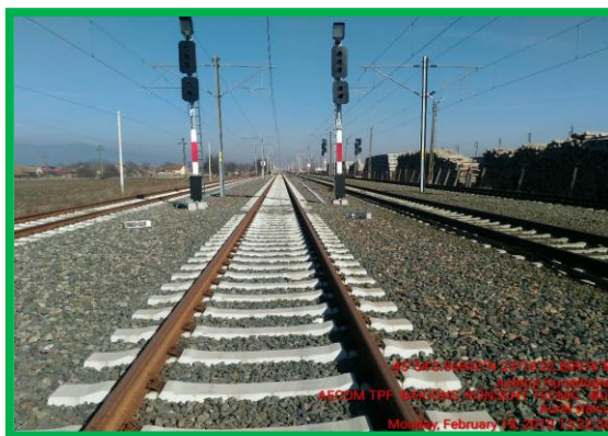
Stația Aurel Vlaicu - instalare semnale pe catarg
