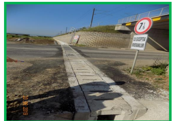
Pod km 417+158pr. Fir 2 – Execuție subtraversare drum
