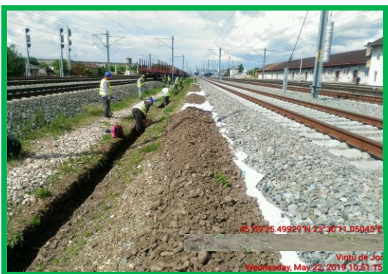
St. Vințu de Jos - săpătură șanț instalare cabluri ERTMS
