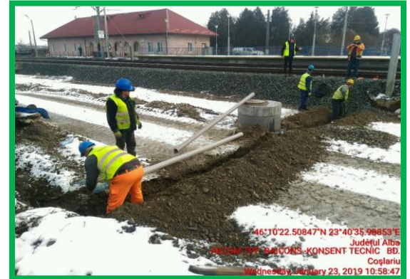
Stația Coșlariu - subtraversare liniile 4 - 6
