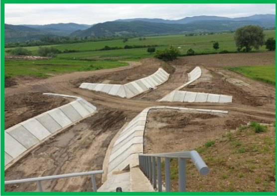
Pod km 430+194 - amenajare albie aval
