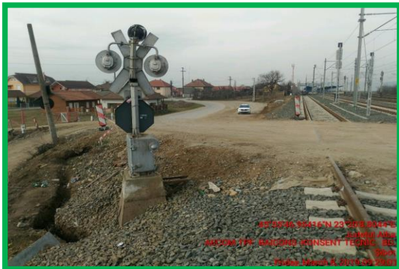
St. Șibot - relocare semnal rutier A și cabluri de la instalația SAT
