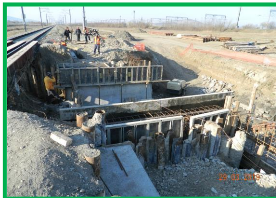
Podet km 404+452ex. Fir 1 – Execuție banchetă cuzineți
