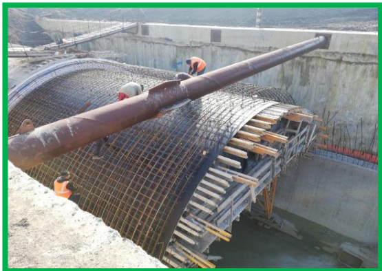
Tunel Turdaș - armare boltă inel nr. 77
