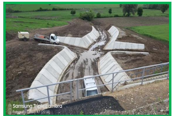
Podetș 430+194 - amenajare aval - taluze finite
