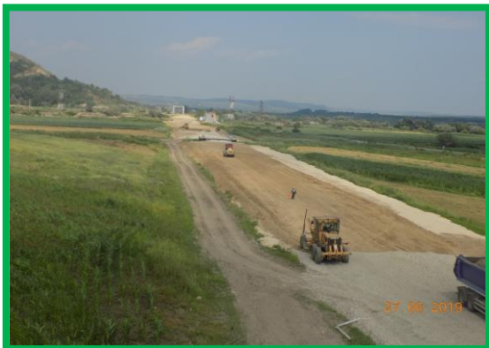
Km 396+200pr. Fir 1+2 – Execuție umplură
