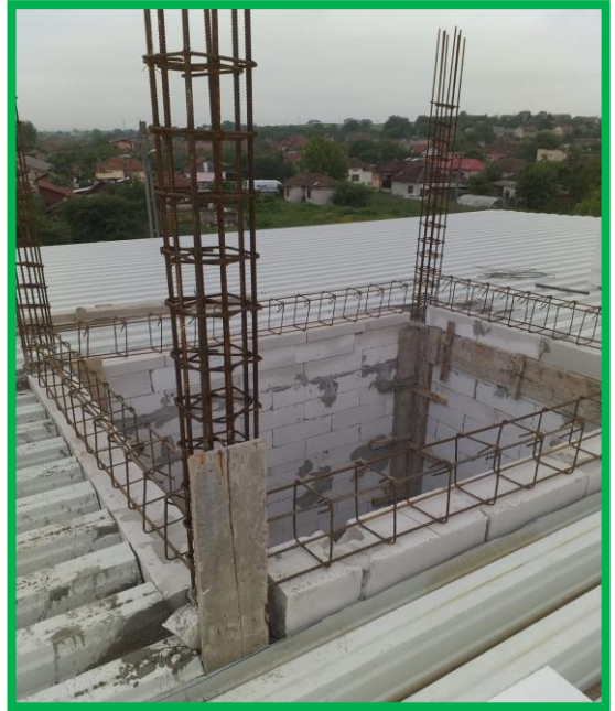
Clădirea OCC Simeria - zidărie coș de evacuare
