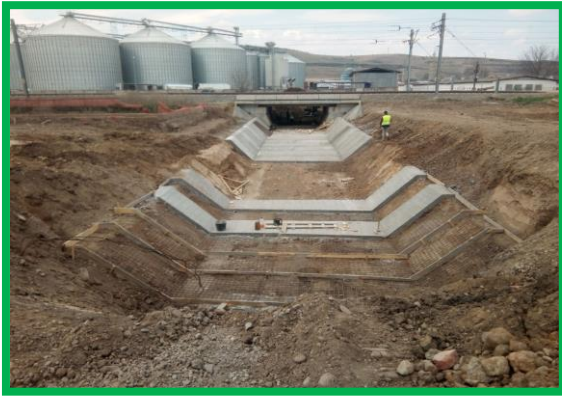
Podetș km. 402+485 - plasă sudată pereu și betonare aval
