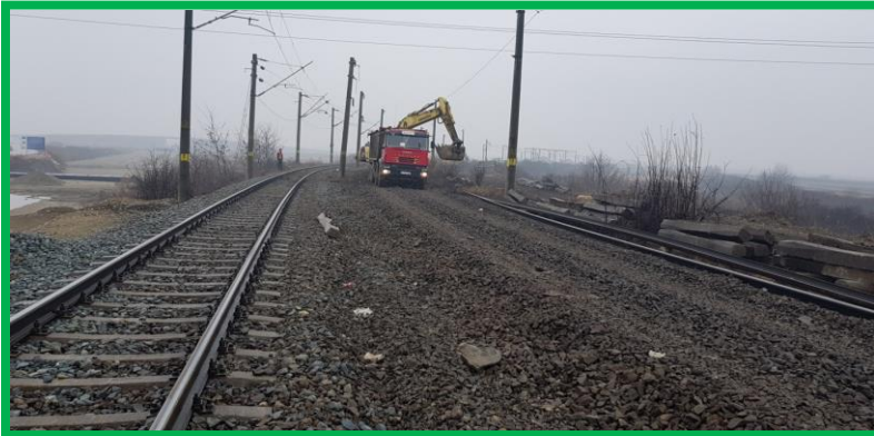
Halta Podu Mureș - demontare linie CF
