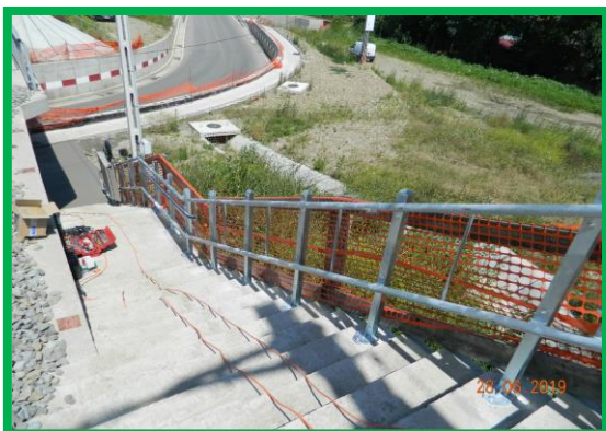
P.O. Sântimbru – Montare platforma elevatoare Peron Fir 1+2
