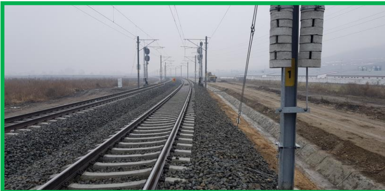
Interval Sântimbru – Bărăbaș - racordare taluz terasament la rigolă
