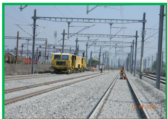
Km 403+350ex.– Execuție buraje Liniile 4, 5, 6
