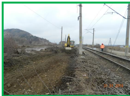
Km 395+450ex. Fir 1 – Scoatere piatra sparta din cale si săpătură
