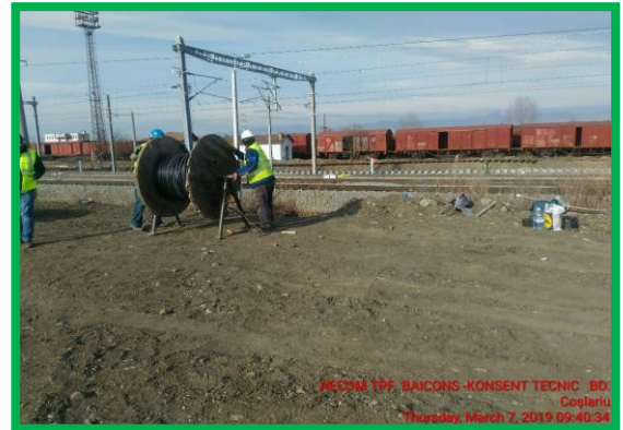
Stația Coșlariu - instalare rețea cabluri de semnalizare ERTMS
