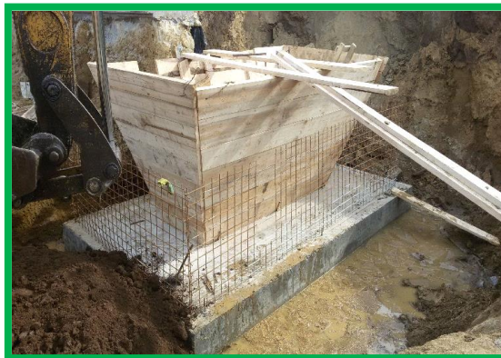
Tranșee Turdaș - elevație cameră colectare Fir II
