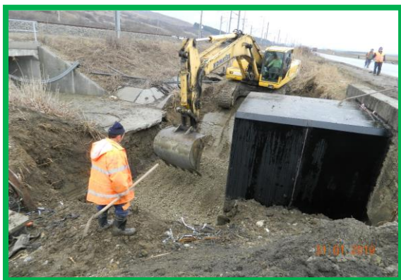
Podet km 394+575pr. Fir 2 – Prelungire podet rutier
