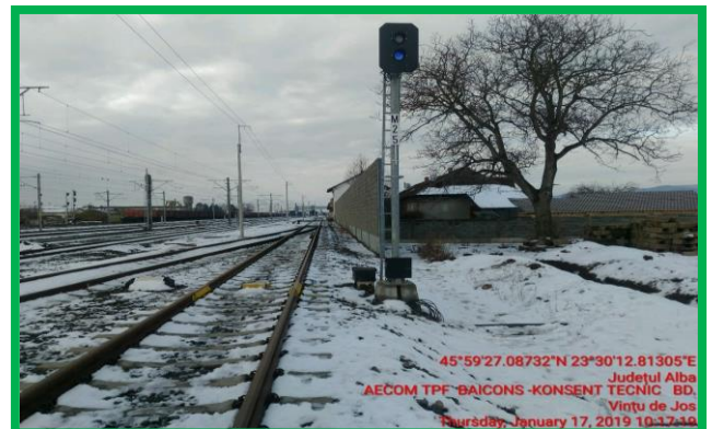
Stația Vințu de Jos - instalare semnal de manevră pe catarg
