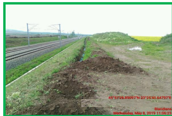
Stația Blandiana - instalare cabluri de semnalizare ERTMS
