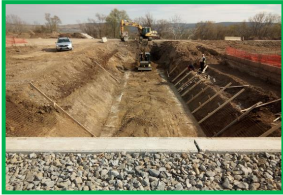
Poduț km. 402+485 - profilare taluze, armare și cofrare
