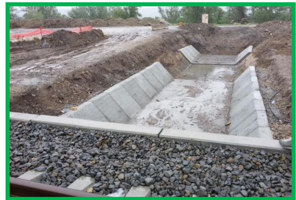
Podetș km. 402+485 - amenajare aval
