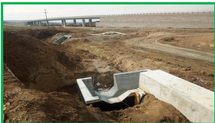
Tranșee Turdaș - armare/cofrare/betonate cameră colectare dren F2
