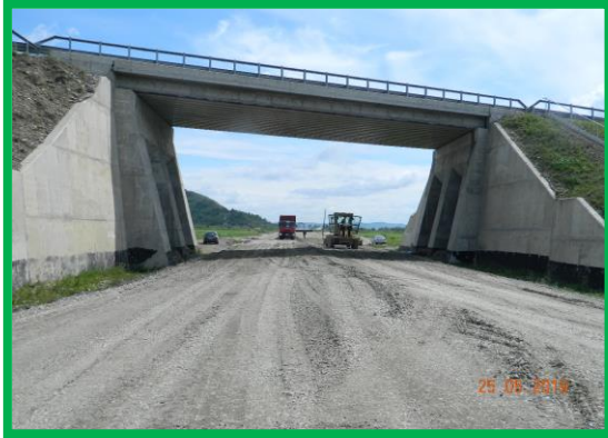
Km 396+200pr.– Execuție umplură peste stratul de transfer
