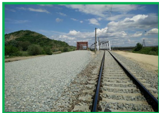
Km 395+350ex. Fir 1 – Așternere strat 1 de piatră spartă
