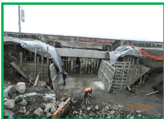
Podet km 404+452ex. Fir 1 – Execuție elevație culei
