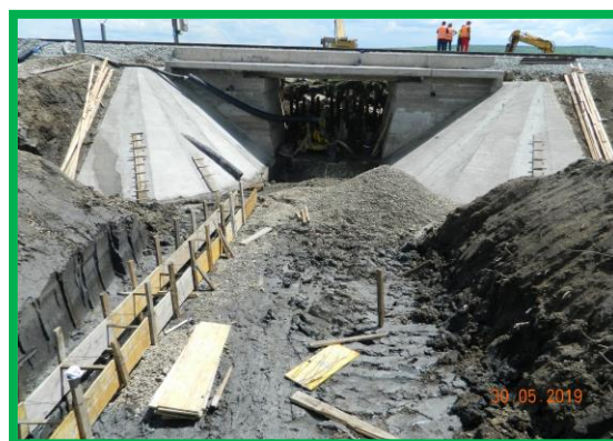
Poduț km 404+452ex. Fir 1 – Execuție sferț de con și amenajare albie
