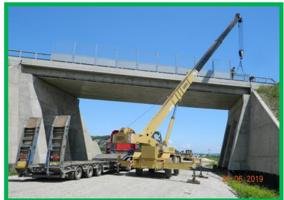
Pasaj superior .km 396+200pr.– Montare parapet
