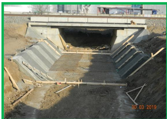
Podet km 404+485pr. – Amenajare albie aval
