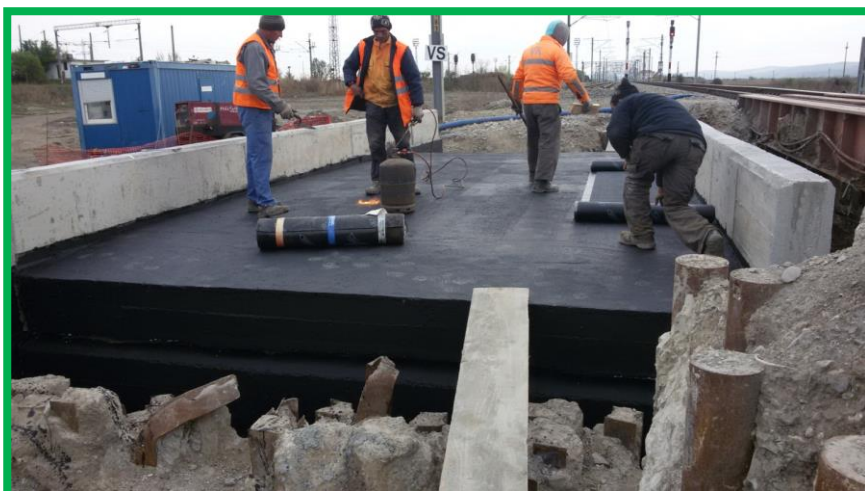
Pod km 404+450 Fir I - betonare pantă, amorsă și hidroizolație
