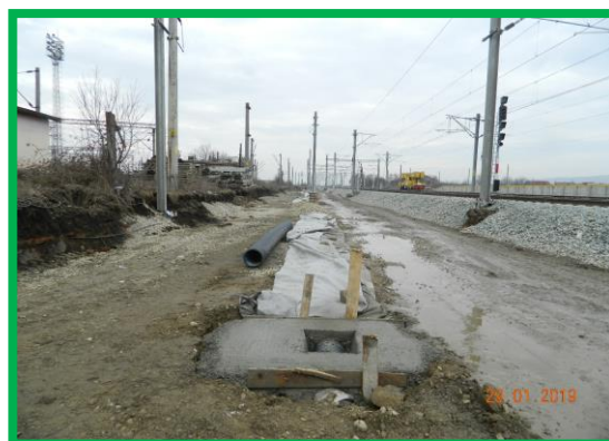
Km 403+050ex.– Execuție dren si montare stâlpi LC
