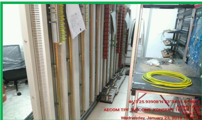
Stația Alba Iulia - conectare cabluri ERTMS
