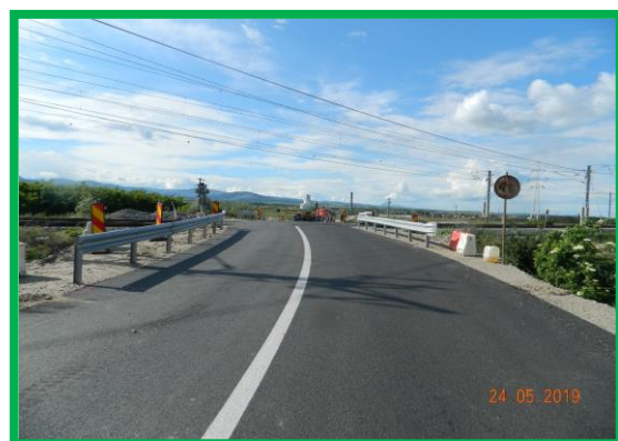
Trecere la Nivel km 402+026ex. – Montare parapeti
