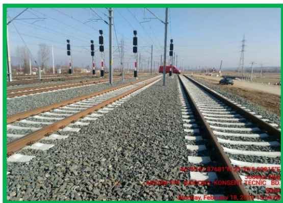
Stația Șibot - instalare semnale pe catarg
