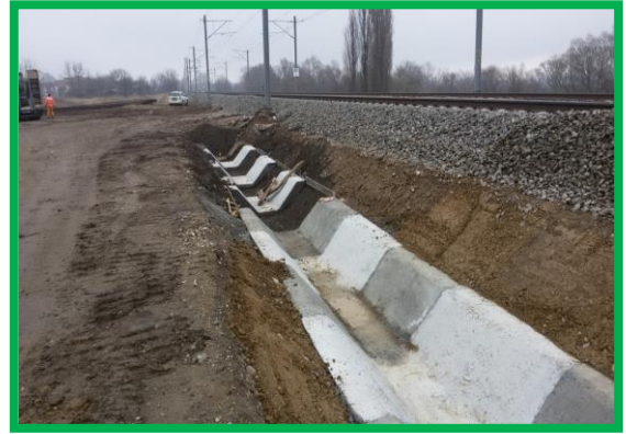
Rigolă monolită km 402+300-500 - cofrare și betonare
