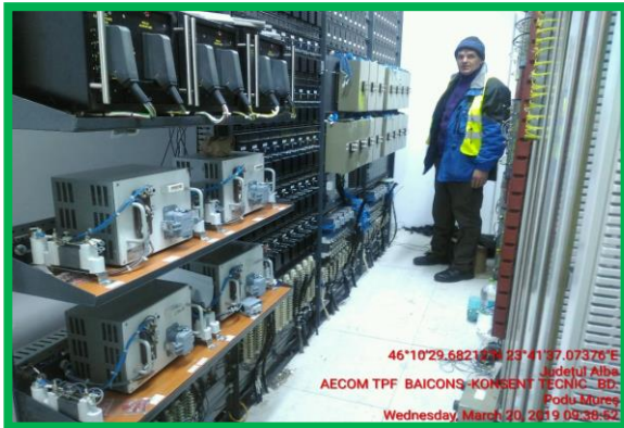
St. Podu Mureș - montare echip. și aparataj pentru circuite de cale
