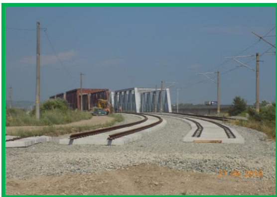
Km 395+450ex. Fir 1+2 – Montare suprastructură
