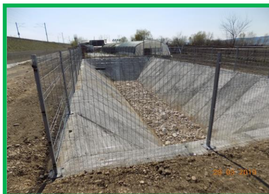
Km 415+700pr. Fir 1 – Realizare bazin de evaporare
