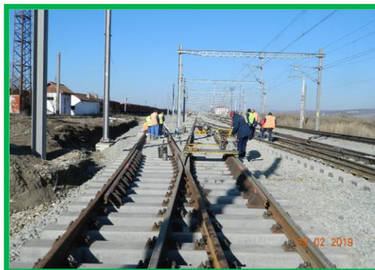
Km 403+950ex.– Execuție sudura sine Liniile 4, 5, 6
