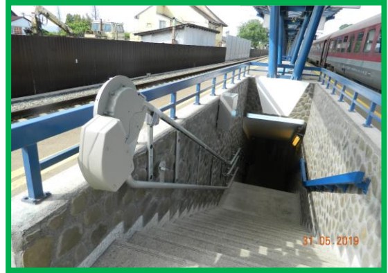
Stația Alba-Iulia – Montare platformă elevatoare tunel pietonal
