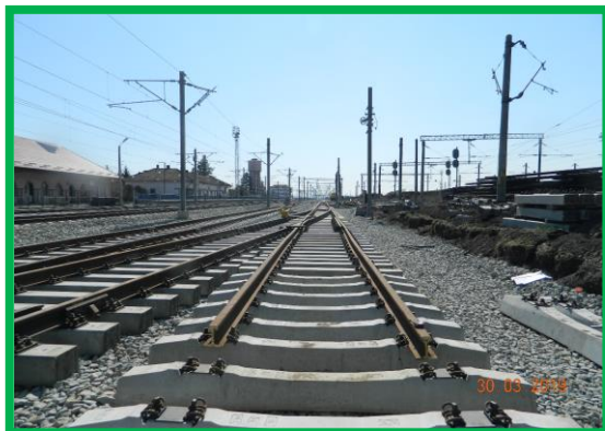
Km 403+120ex.– Montare suprastructura Liniile 4, 5, 6
