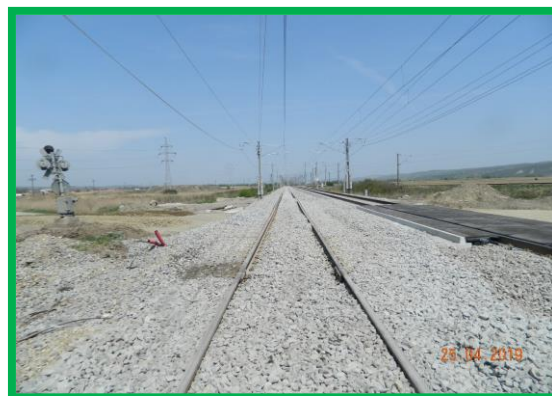
Trecere la Nivel km 402+026ex. – Montare dale Strail
