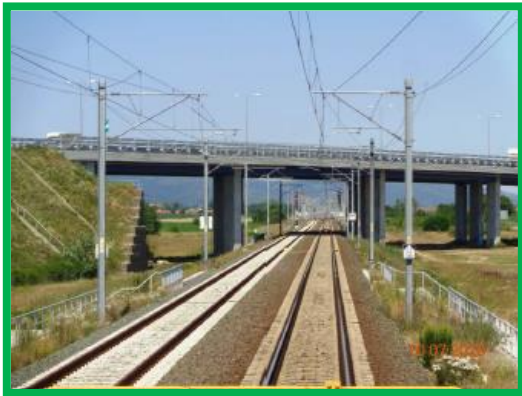
Statia Aurel Vlaicu / km 444+700
