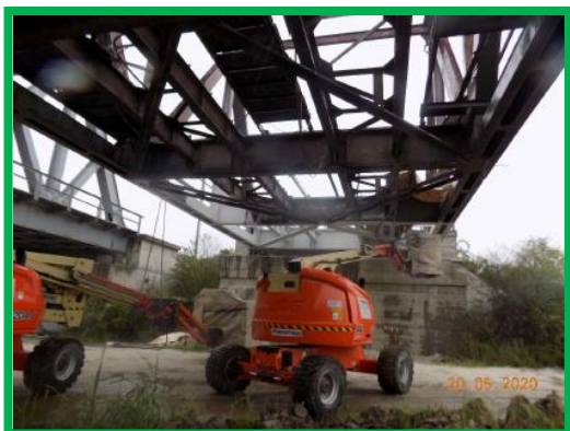
Pod km 396+222 HM Podu Mures
