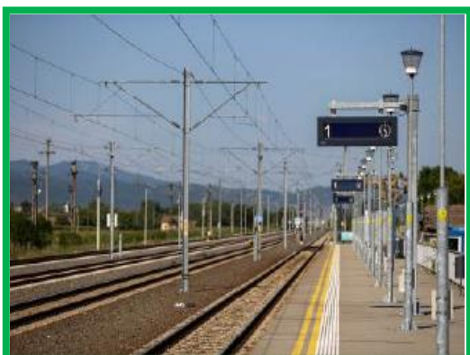
Panouri informare si iluminat peron Aurel Vlaicu
