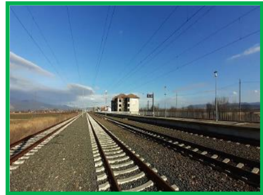
Statia Aurel Vlaicu / km 443+300
