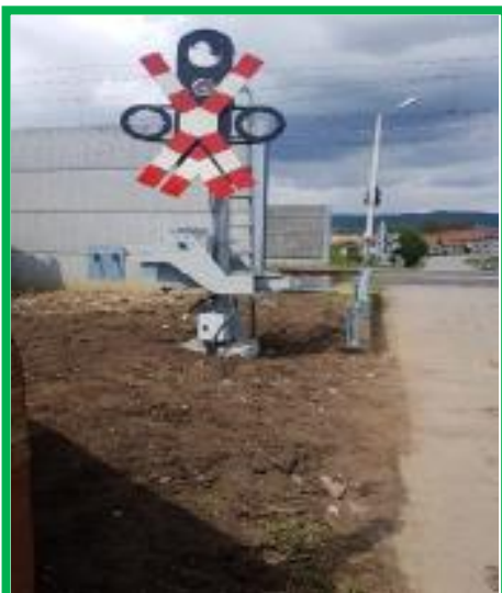
Orăștie – instalare semnal rutier TN Pricaz
