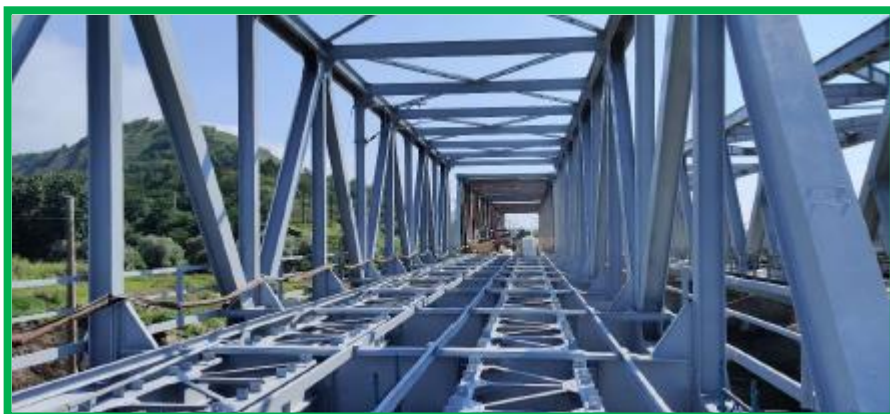
Pod km 396+222 HM Podu Mures
