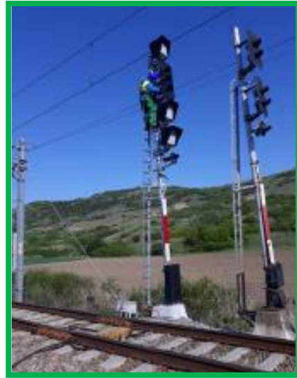
Podu Mureș – echipare semnale cu panouri LED
