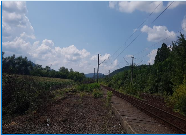
Defrișări și curățare teren Stația Câmpuri Surduc
