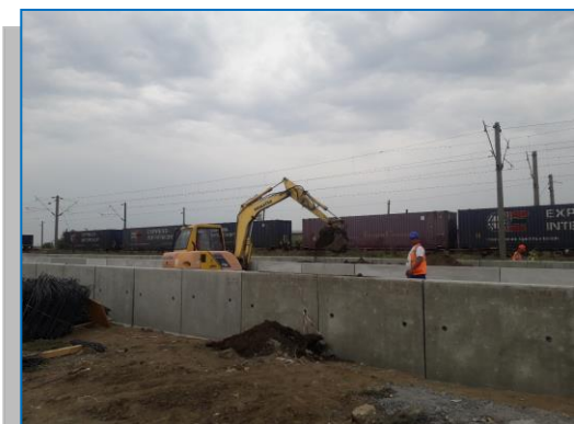
Stația Ghioroc - execuție peroane linia I și II
