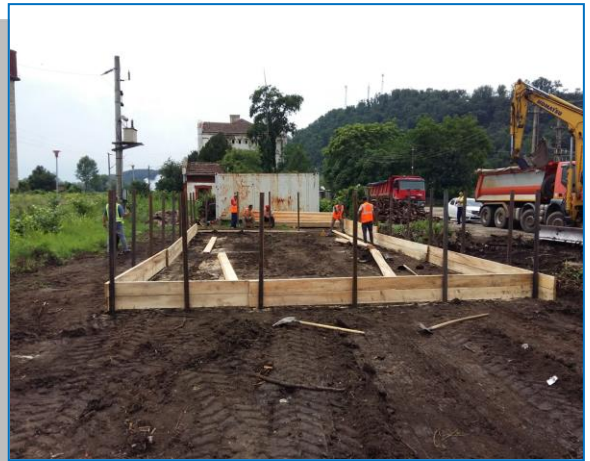
Stația Săvârșin Km 541+800 cofrare fundații
