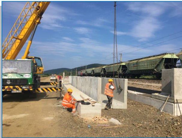
Stația Bârzava - montare elemente prefabricate
