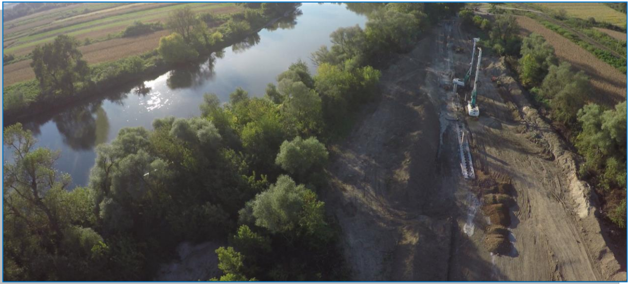
Consolidări - interval Vărădia – Săvârșin km 548+300 Jet-grouting
