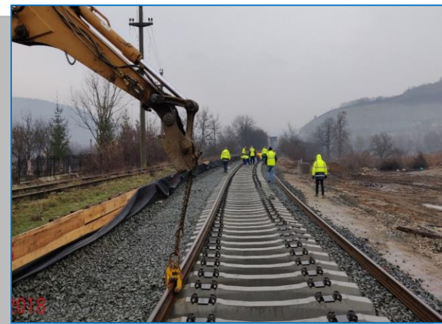
Montare traverse și șină Linia Brad - km. 5+900 ÷ km. 6+200
