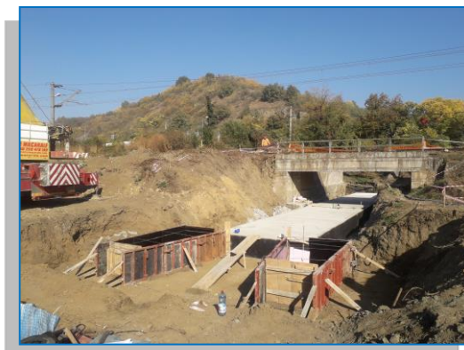
Execuție Podeț - Stația Păuliș
