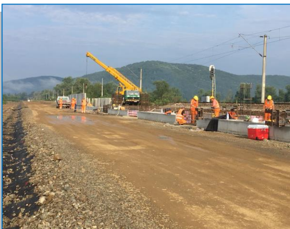
Stația Bârzava - turnare fundație stâlpi copertină
