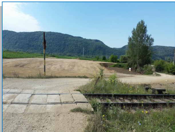
Trecere la nivel+rampa 2, km 531+320
