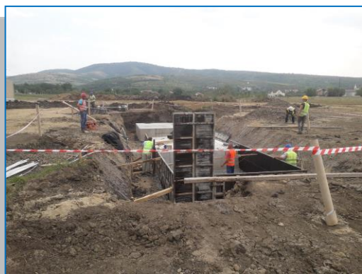
Lucrări podeț interval Km 614 – Ghioroc Km 607+366
