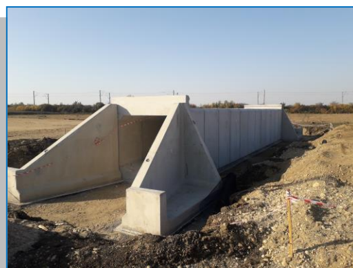
Execuție podeț - interval Km 614 – Ghioroc
