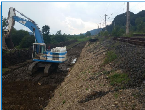
Pregătirea terenului, fir II, km 532+650
