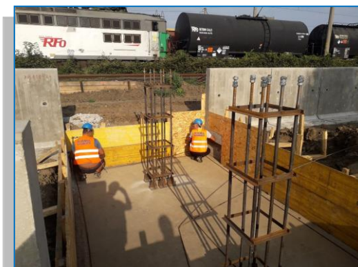
Stația Ghioroc - execuție peroane
