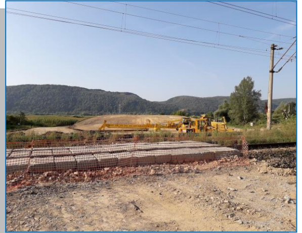
Amenajare trecere la nivel provizorie, km 531+320
