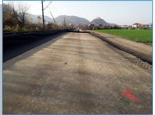
Montare geotextil Stația Deva
