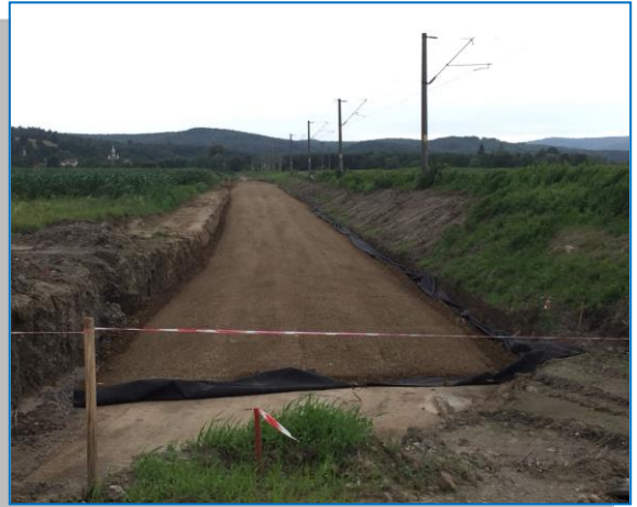
Terasament Stația Bârzava
