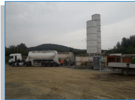
Execuție jet grouting - interval Milova – Bârzava
