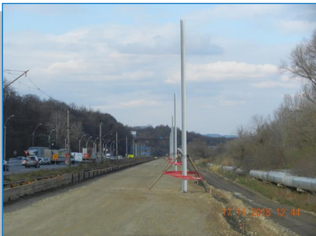
Montare stâlpi LC - km. 482+900 ÷ km. 483+350
