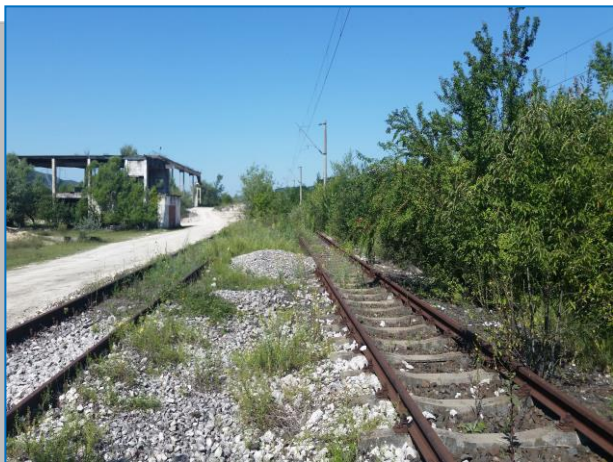
Liniiile 6-7 din Stația Ilteu
