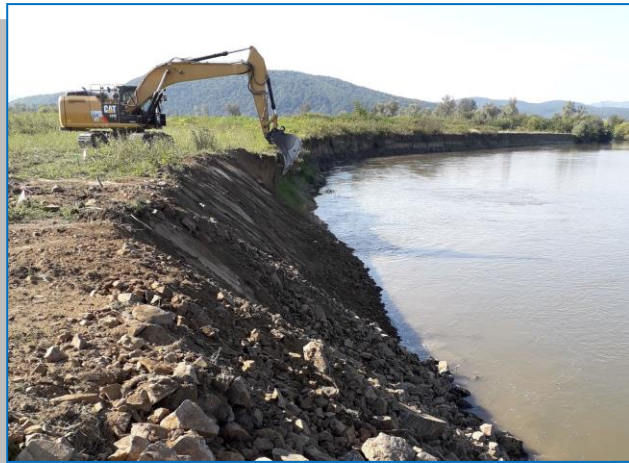
Lucrări de apărări de mal, km 527+400 - km 527+689
