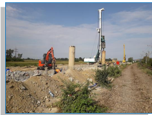
Stația Radna - execuție piloți forajați
