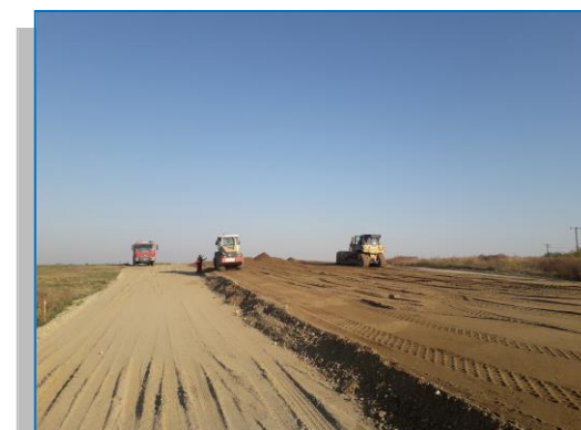
Lucrări de terasament interval Km 614 – Ghioroc
