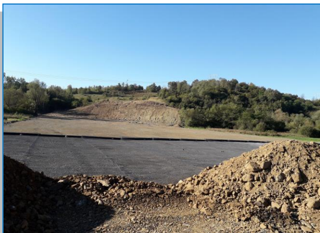
Umplutura cu material necoeziv, strat 2, km 525+280
