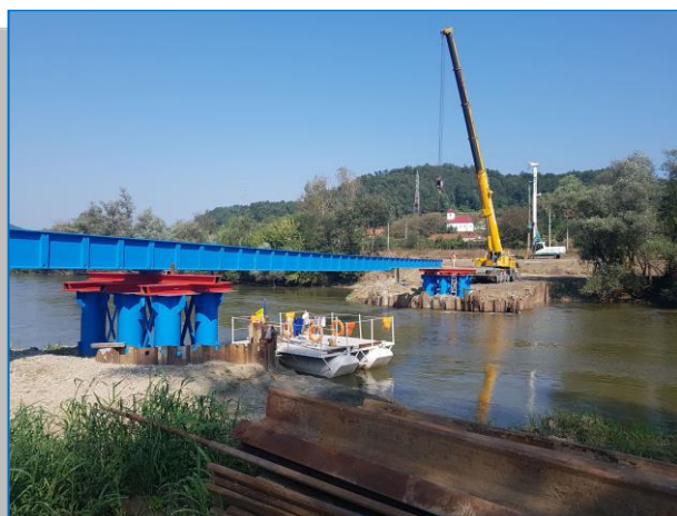
Pod provizoriu peste Mureș, km 516+500
