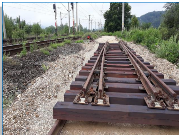
Aprovizionare schimbător cap Y, linia 1, Stația Ilteu
