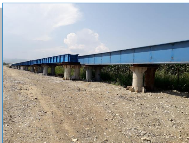
Depozitare grinzi - Pod provizoriu peste Mureș, km 516+500
