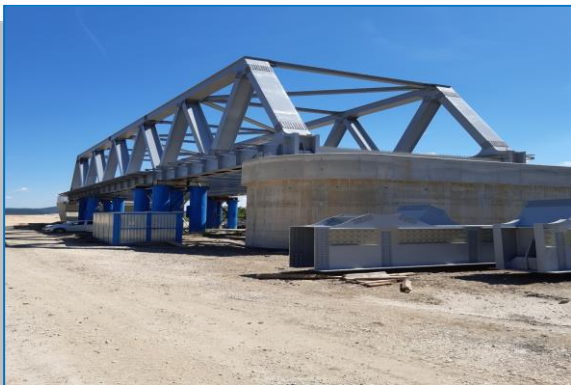
Montare tablier metalic – Pod km 528+514
