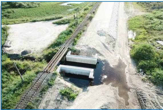
Realizare elevație culei – Pod 533+058
