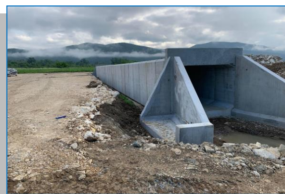
Montare elemente prefabricate – Podet km 527+371
