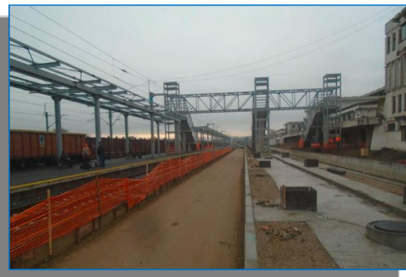
Stația-Deva – Terasamente linia II
