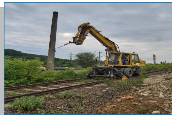
St. Câmpuri Surduc - demontare catenara si stâlpi
