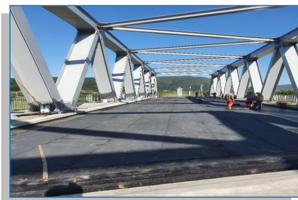
Realizare hidroizolație – Pod km 517+440
