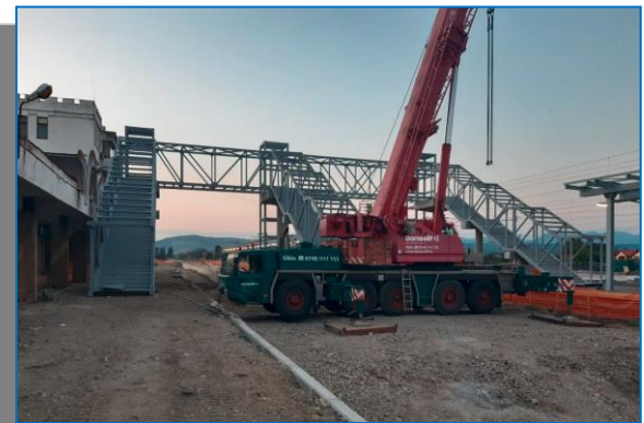
Stația Deva – Pasareleă pietonală
