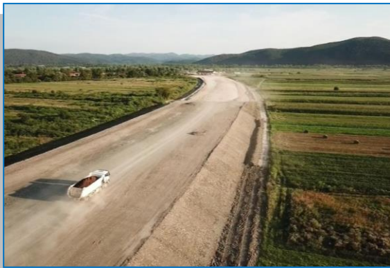
Umplutura din mat. necoeziv si profilare taluz km 526+900
