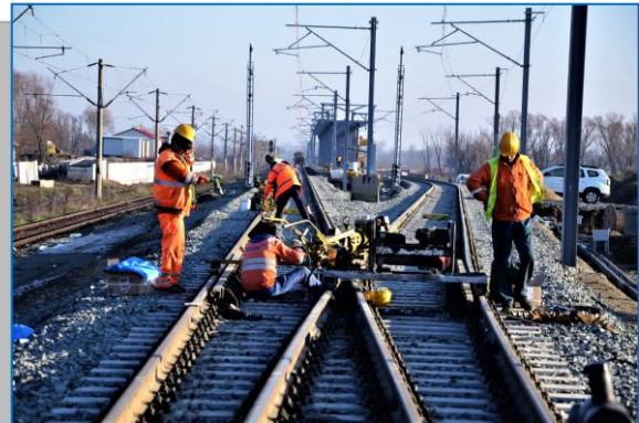
Statia Varadia – Sudura joanta interioara
