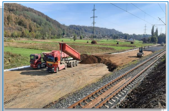
Extindere terasamente km 514+020 - 514+389
