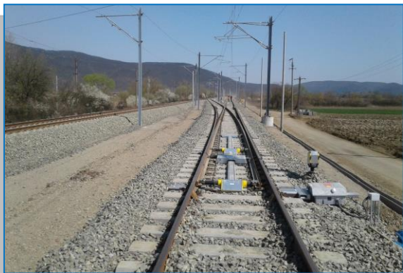
Stația CF Săvârșin - Calibrare schimbători
