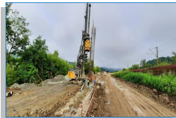
Execuție coloane Zid de Sprijin km 516+575 - 516+704
