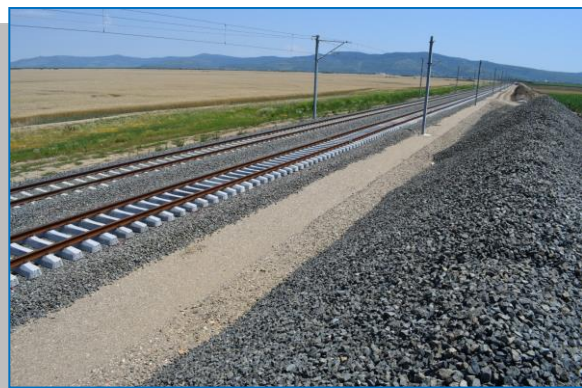
Km 614 - Ghioroc km pr. 611+200 – km pr. 609+900
