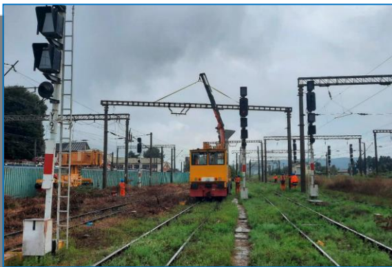
Stația Simeria – Demontare linie de contact
