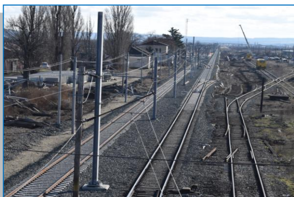
Stația CF Ghioroc – km pr. 603+751 - km pr. 605+910
