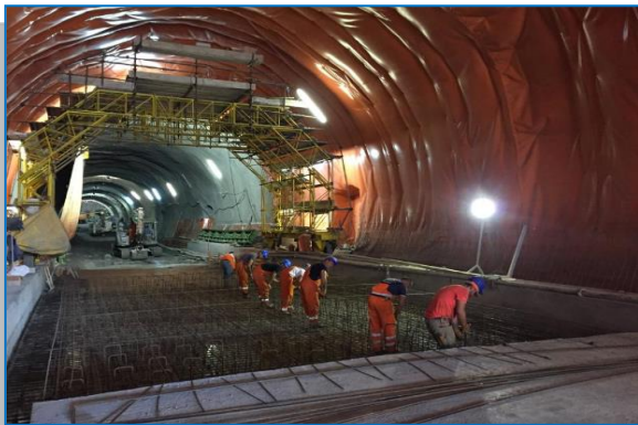
TUNEL - Hidroizolatie si armare radier
