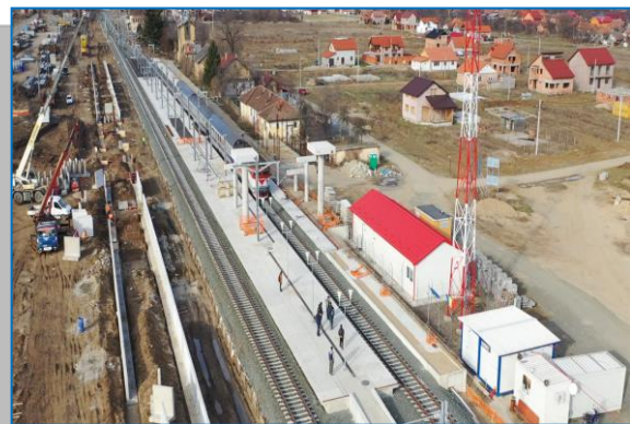
Stația CF Ghioroc – km pr. 603+751 - km pr. 605+910
