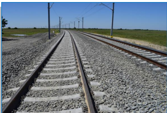
Km 614 – Ghioroc km pr. 605+905 - km pr. 609+900
