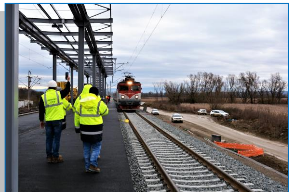
Statia Varadia – Redeschiderea circulatiei pe liniile III-4
