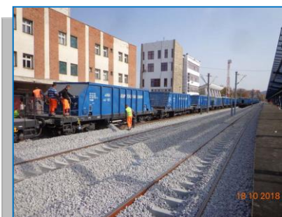
Piatră spartă linia 1, 2 și 3, Stația Mediaș
