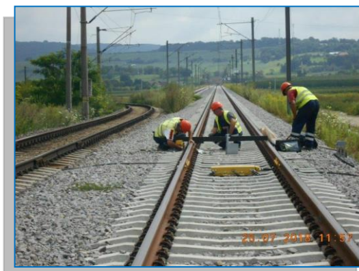
Daneș – instalare autostop și canal beton
