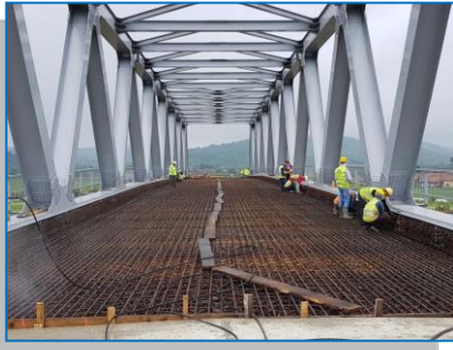
Armare dala din beton. Pasaj Daneș
