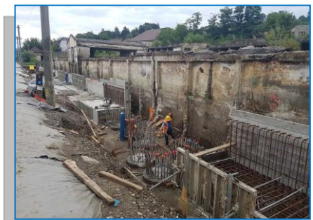
Consolidare cu piloți cap Y, Stația Mediaș
