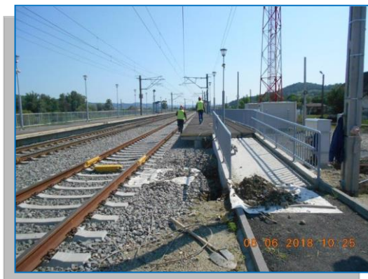
Copșa Mică – instalare cabluri la semnalele S1 și S3
