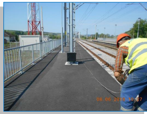
Copșa Mică – instalare cabluri la semnalele S1 și S3
