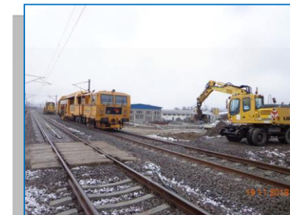
Buraj, profilare, stabilizare, Ațel - Mediaș
