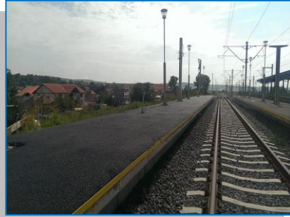
Stația Blaj - asfaltare peron linia 1
