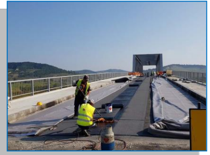
Hidroizolație Pasaj Daneș
