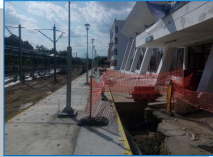
Clădire călători, Stația Mediaș
