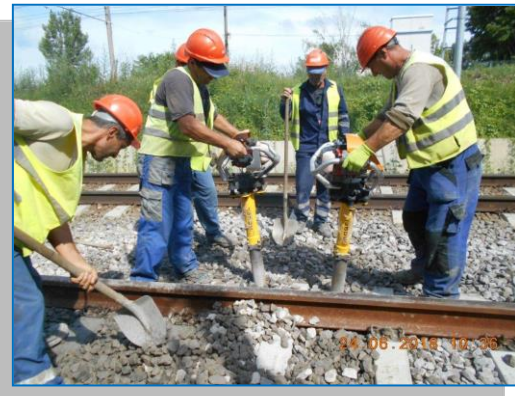
Mediaș – subtraversare prin șanț deschis și compactare
