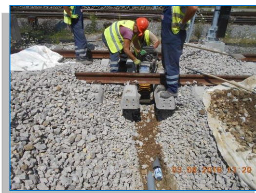
Copșa Mică – subtraversare deschisă și compactare
