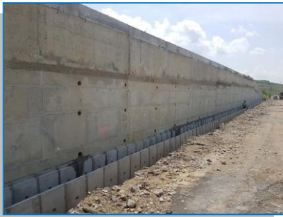
Consolidare DN 14 km 314+050
