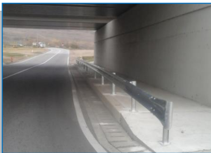
Stația Blaj - Pod 5 montare parapeti
