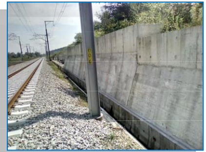
Remediere consolidare km 315+000
