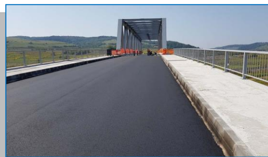
Asfalt AB2 - Rampe Pasaj Daneş
