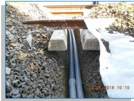
Mediaș – subtraversare prin șanț deschis și compactare
