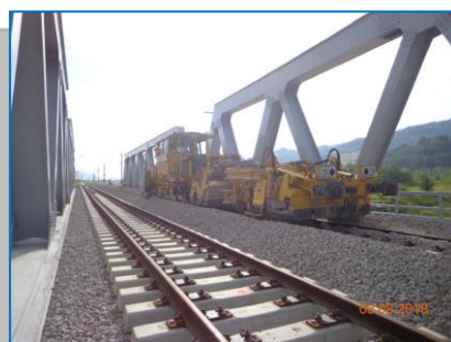
Profilare piatră spartă Fir II, Copșa – Micăsasa
