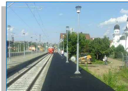
Stația Blaj - asfalt peron principal
