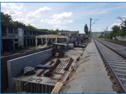
Zid de sprijin, Stația Mediaș
