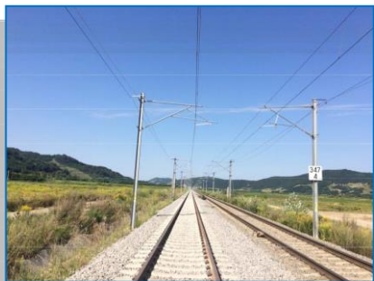
LC montată și reglată , Copșa Mică - Micăsasa
