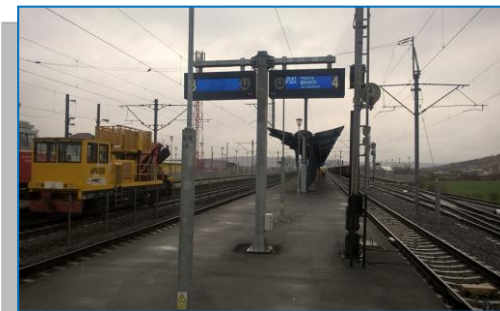
Stația Crăciunel – teste la terminare lucrări SI
