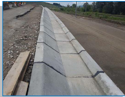
Consolidare DN 14 km 314+000
