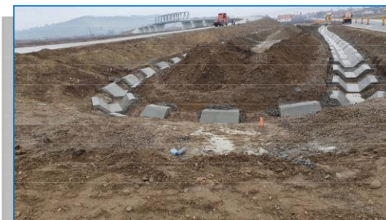
Şanţ beton - Pasaj Daneş (relocare DC58)
