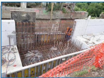
Grindă coronament, Stația Mediaș
