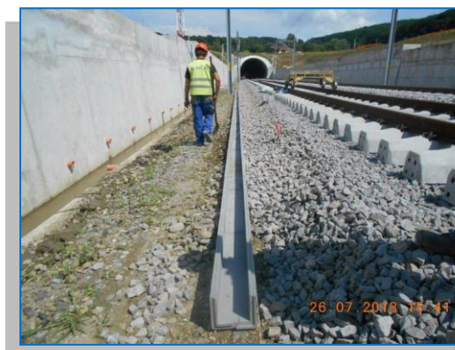
Daneș – instalare autostop și canal beton
