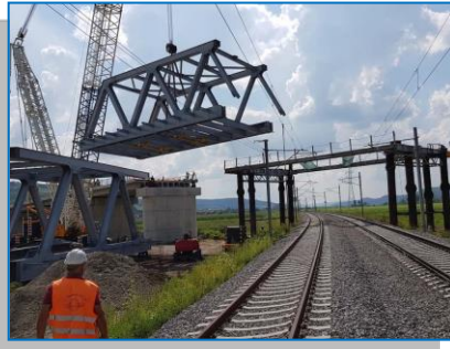
Montare structura metalica Pasaj Dumbrăveni
