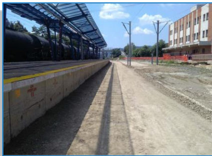
Platformă de pământ, Stația Mediaș
