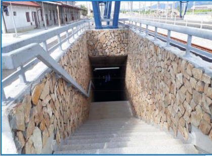
Tunel pietonal, Stația Copșa Mică
