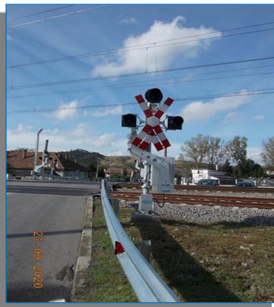
Blaj – instalare LED-uri semnal rutier
