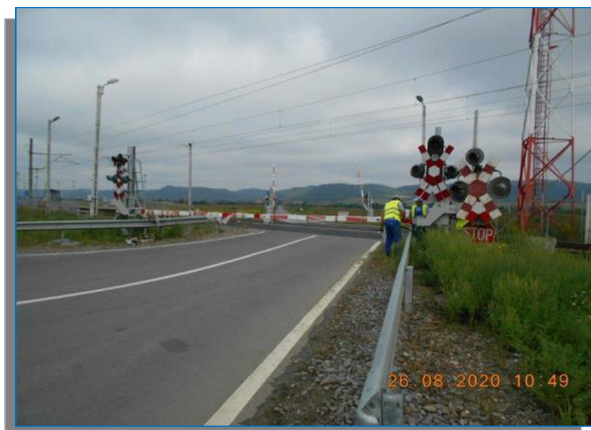
Daneș – instalare LED-uri, instalare și reglare semicumpene la BAT
