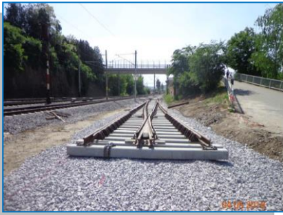
Stația Mediaș - Montare aparat de cale
