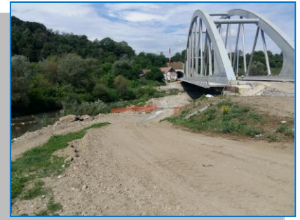
Sighișoara - Daneș - Pod 1, km 299+720
