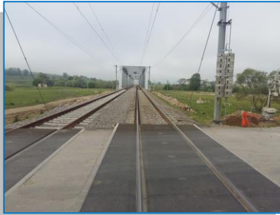
Mediaș-Copșa Mică, PO Târnavă – stabilizare
