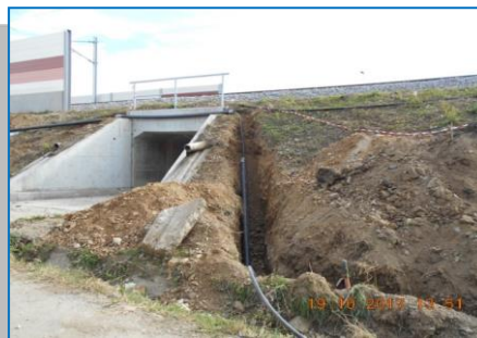
Mediaș – protecție cabluri pe poduri și podețe
