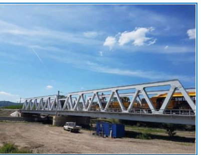
Pod 12 - lucrări suprastructură pod
