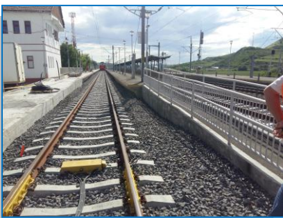
Stația Blaj, Linia 1 - spre Crăciunel
