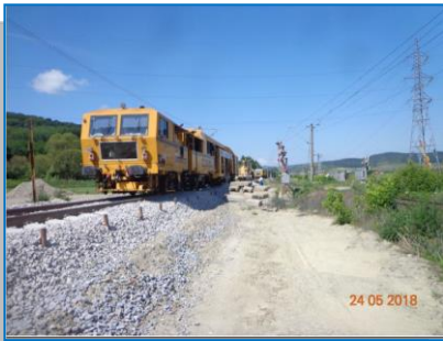
Ațel-Mediaș -buraj, profilare si stabilizare
