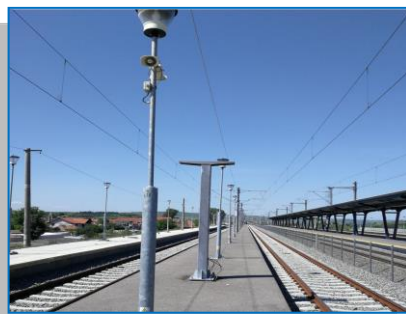
Montare stâlpi panouri afișaj, stația Blaj
