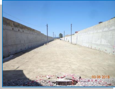
Sighișoara - Daneș Montare stâlpi LC
