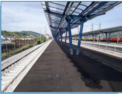
Stația Copșa Mică - așternere asfalt
