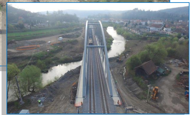
Sighişoara – Daneş – Pod 1 – încărcare cu convoi de probă
