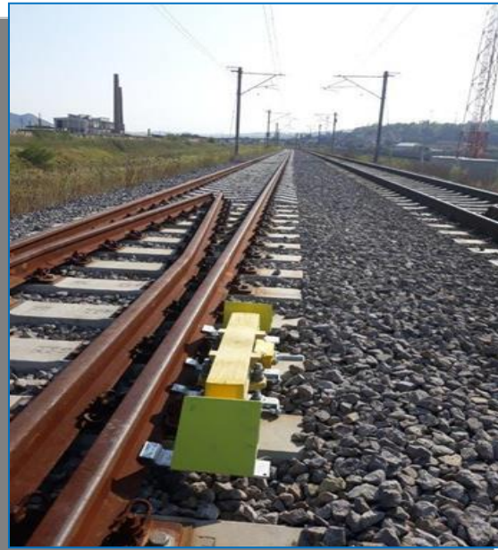
Copșa Mică – instalare inductor
