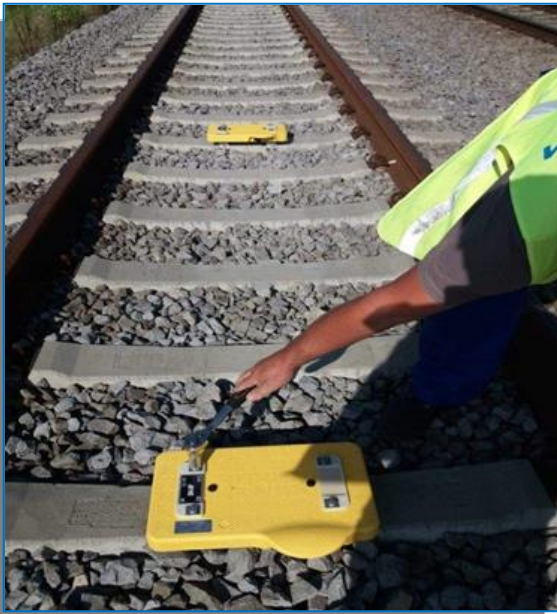
Copșa Mică – instalare eurobalize
