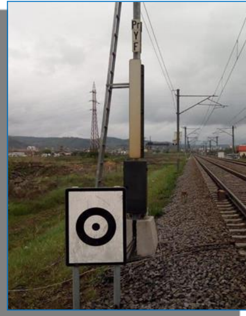
Mediaș – instalare reper țintă
