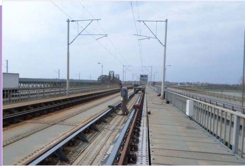
Finalizarea montării contrașinei
