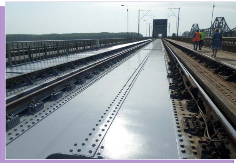
Protecție anticorozivă - Viaduct Fetești
