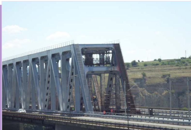
Lucrări de protecție anticorozivă GZCJ, fir I, cap X
