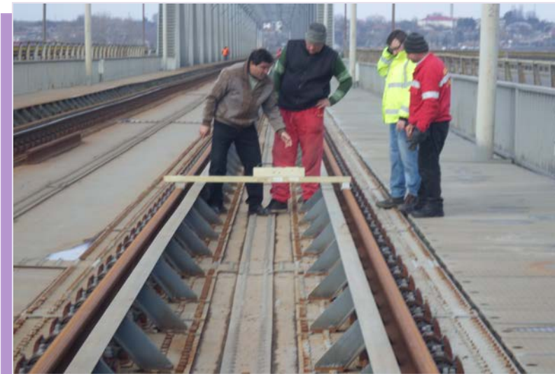
Verificare cale pe Viaduct Ovidiu
