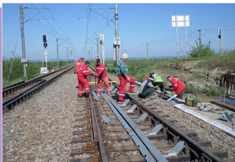
Montare contrașină pe firul II VDI
