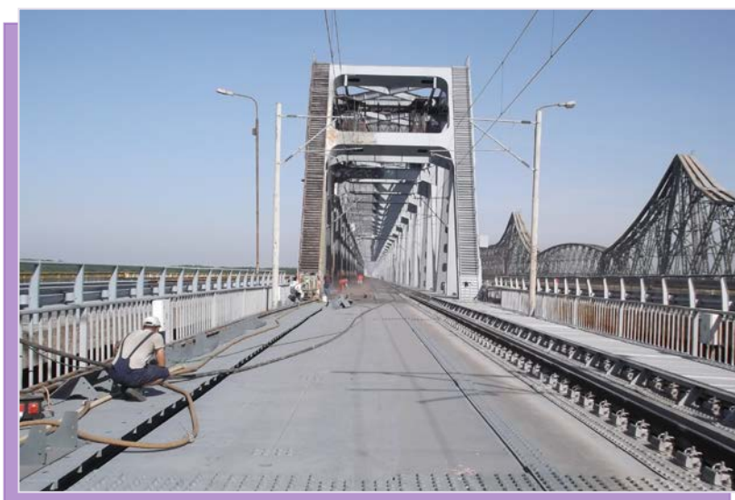
Pregătire suprafețe în vederea consolidării viaduct independent, Y
