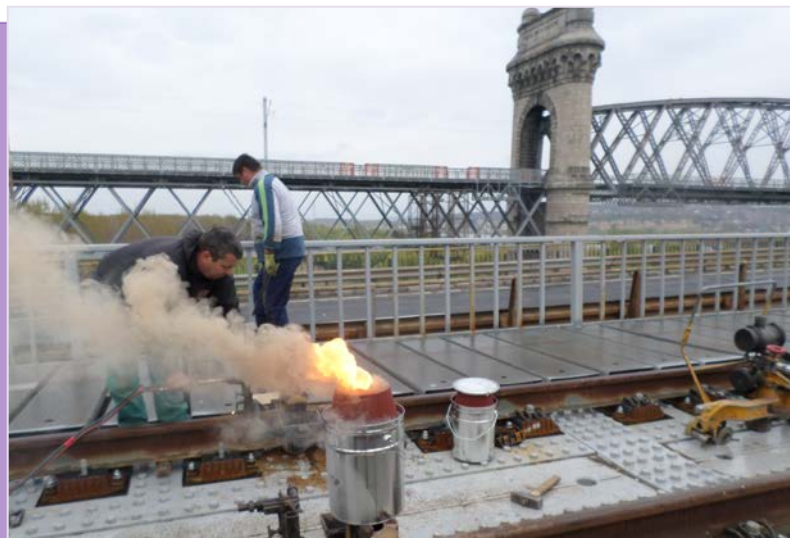
Sudură șină fir 2
