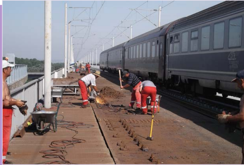
Demontare cale fir
