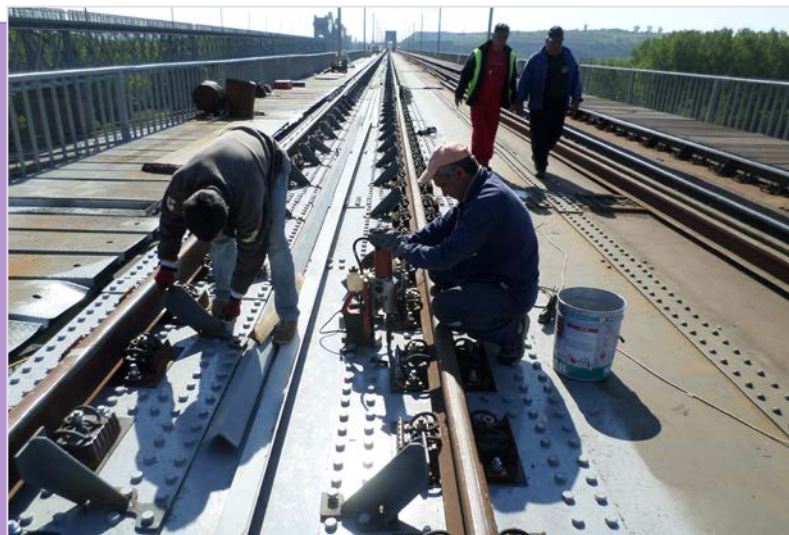
Montare contrașină pe firul II VD3
