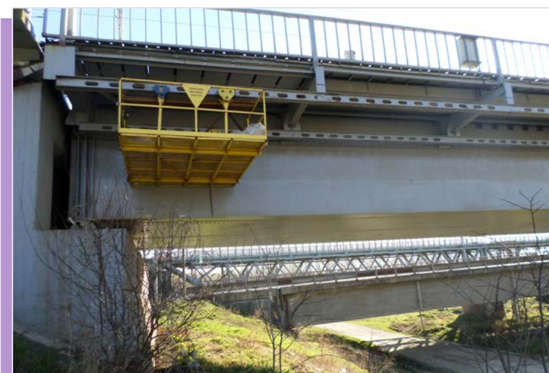
Montarea șuruburilor la consolă
