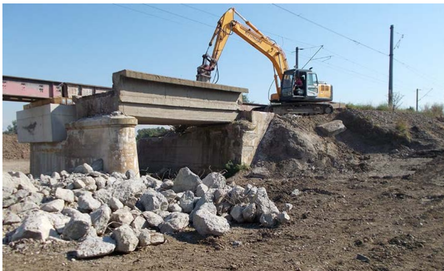
Demolare tabliere Fir II
