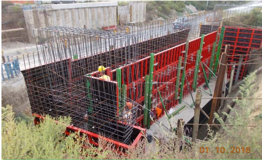
Armare/Cofrare elevatie culee Urziceni
