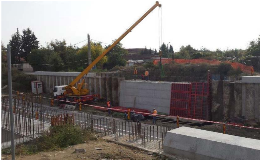
Decofrare elevație culee București
