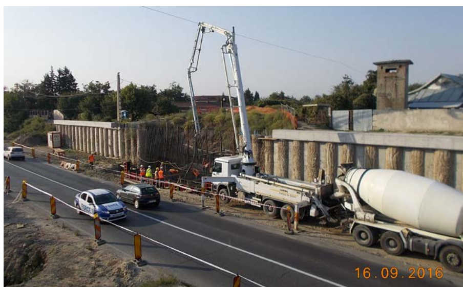
Betonare radier culee București
