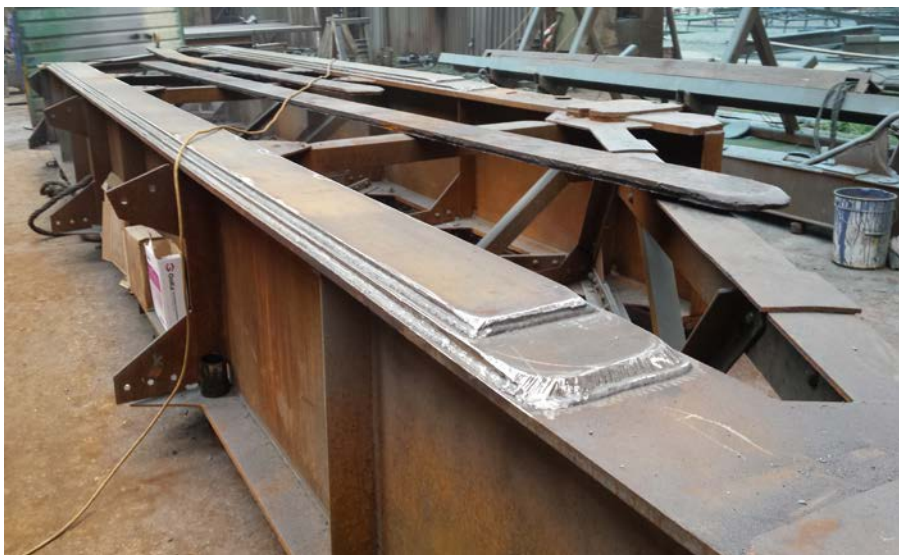
Înlocuire platbande grinzi principale
