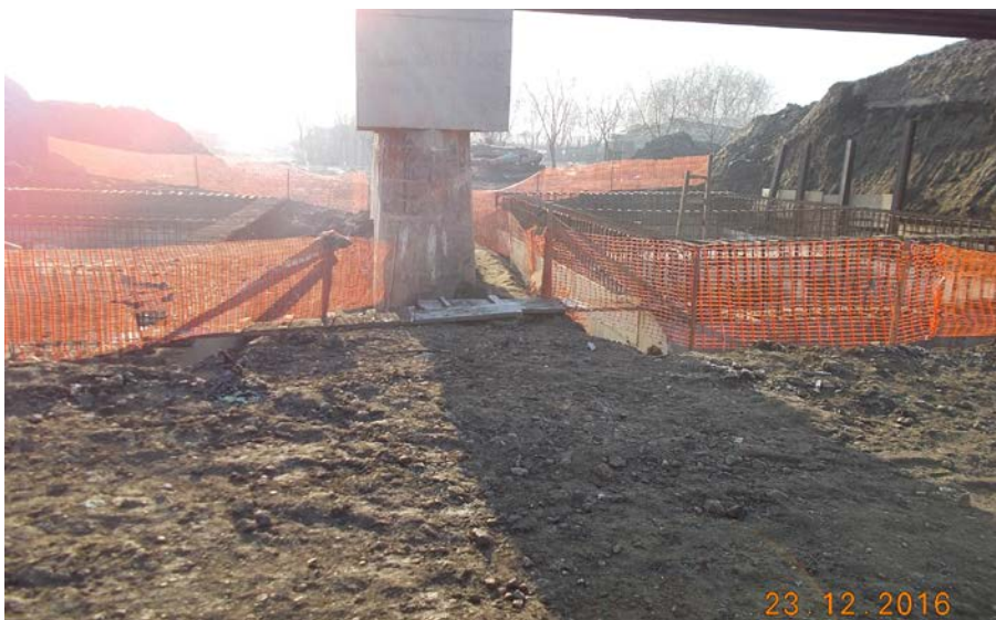
Lansare chesoane II și protecție
