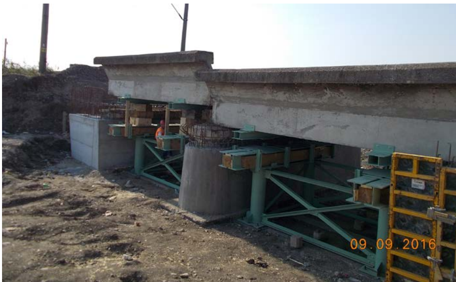
Ridicare tablier existent cu ajutorul preselor
