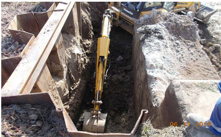
Săpătură în spatele culei cu protecție palplanșe
