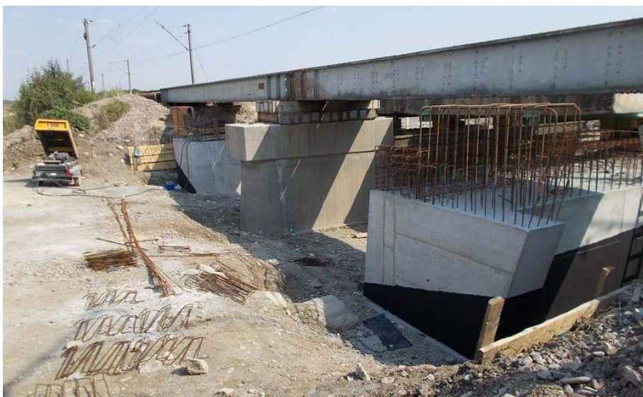
Aspect beton infrastructuri și hidroizolare
