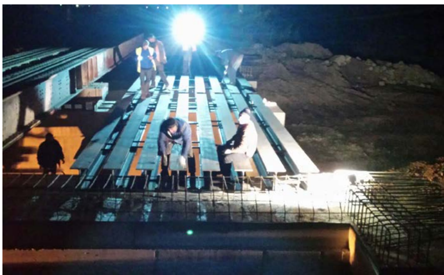
Montare grinzi metalice înglobate – Fir II
