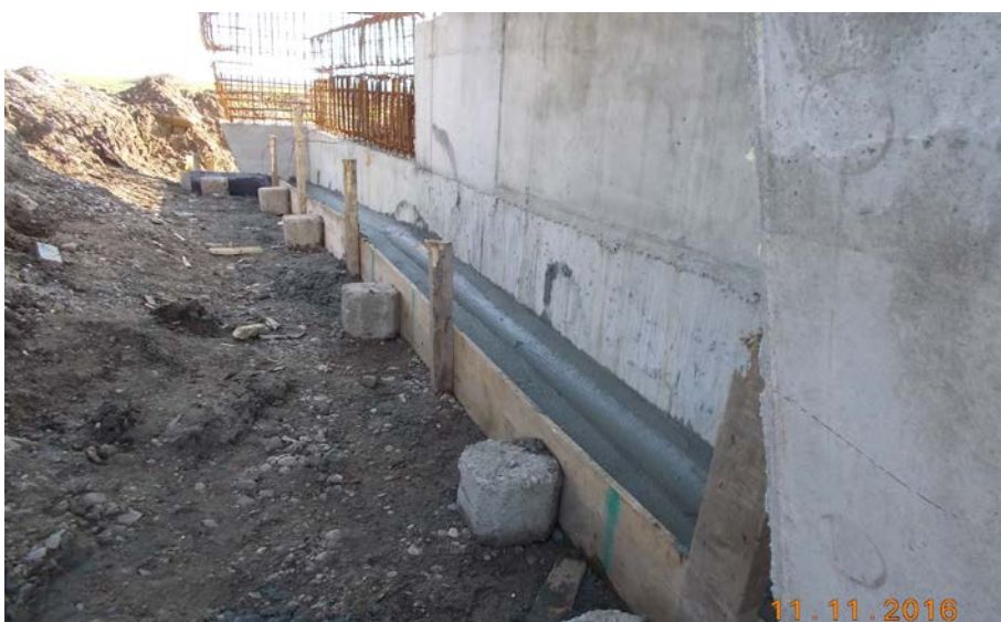
Betonare chiuneta dren
