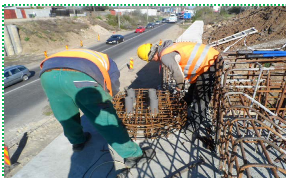
Armare cuzineți culee
