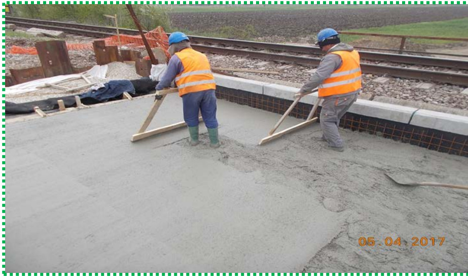
Șapă protecție hidroizolație
