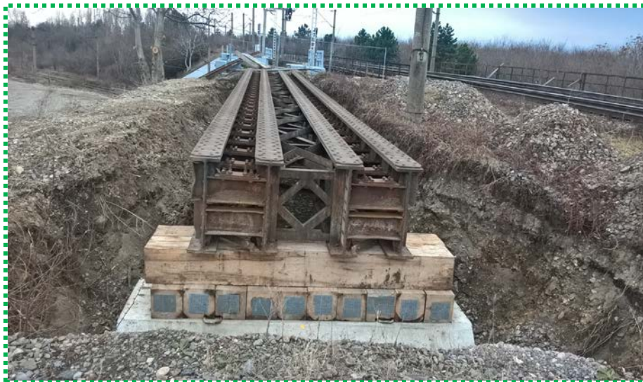
Așezare pod provizoriu pe poziție
