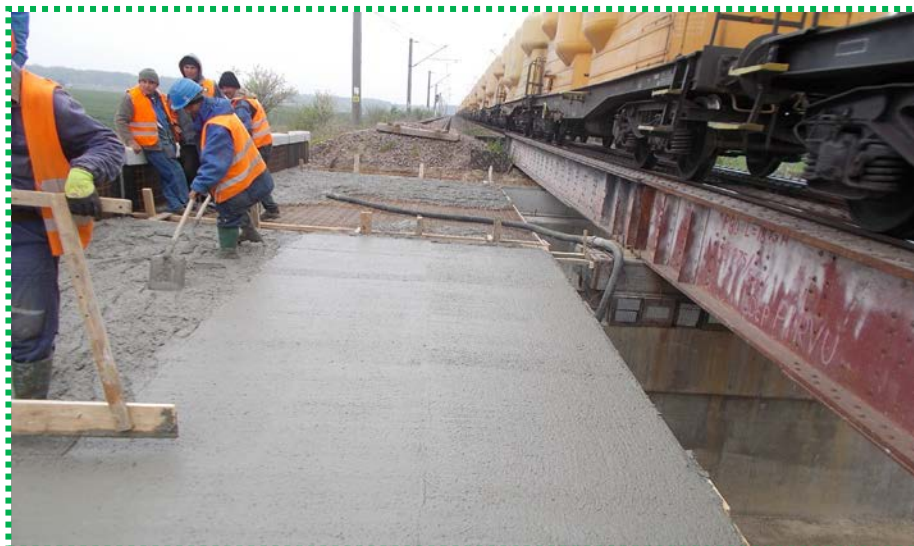
Șapă protecție hidroizolație culei și tabliere Fir II
