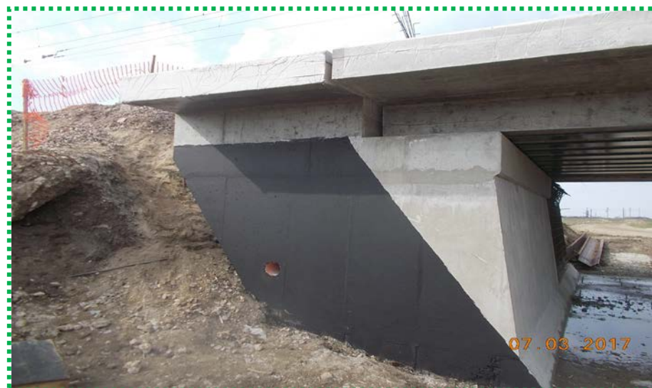
Hidroizolație aripi culee București
