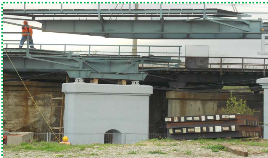
Montare tablierele metalice
