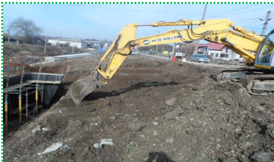
Săpătură pământ pentru executare umpluturi armate
