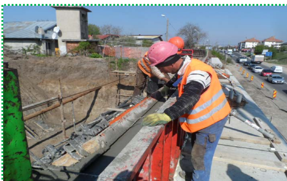
Betonare zid de garda culee Urziceni
