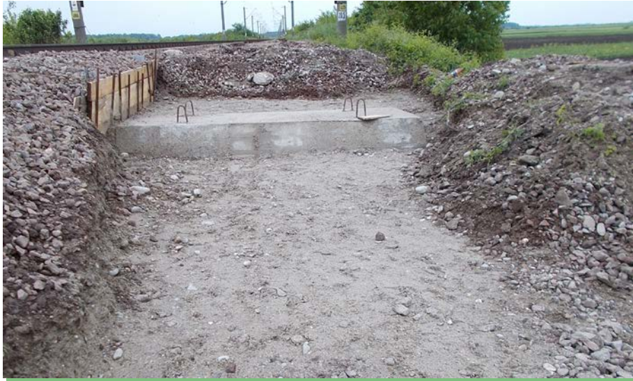
Fundație pod provizoriu
