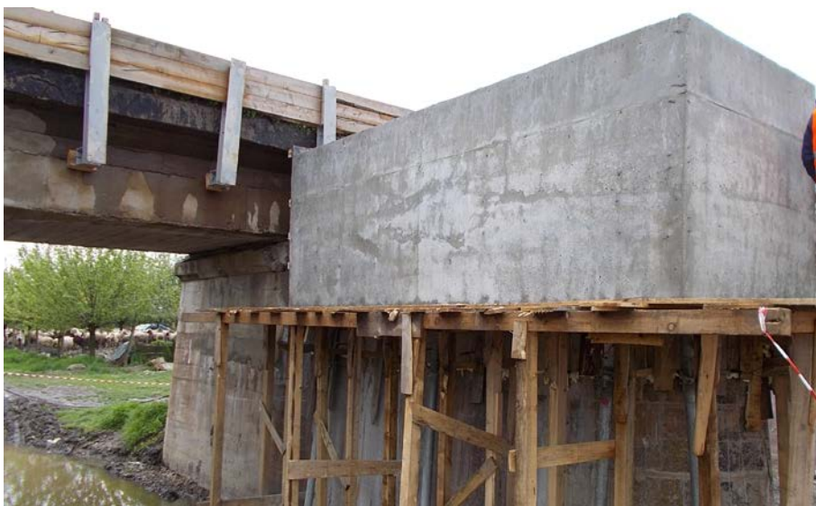
Aspect beton bancheta provizorie pila
