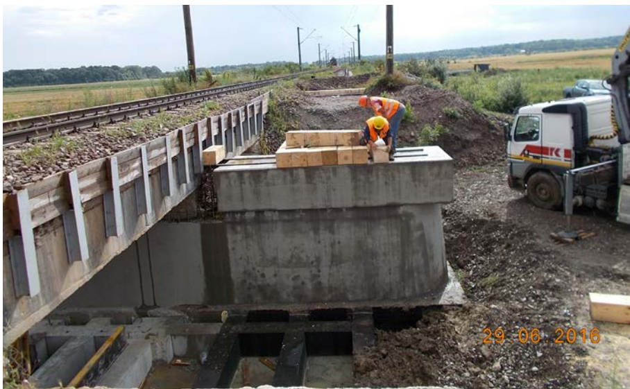
Pregătire montare pod provizoriu
