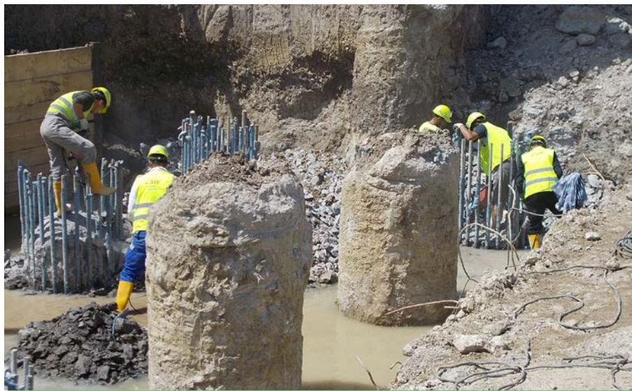
Armare radier și elevație culee
