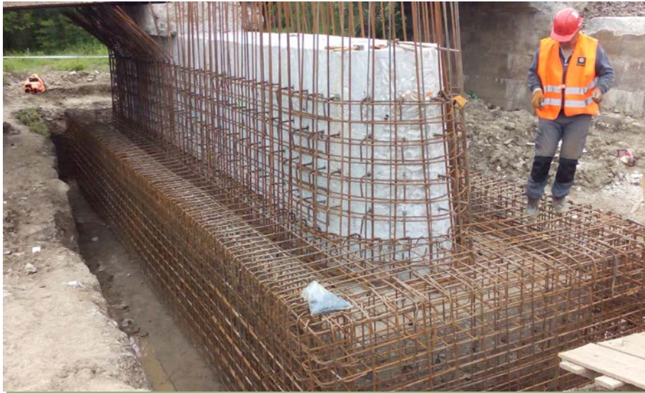
Armare cămășuială fundație și elevație pilă
