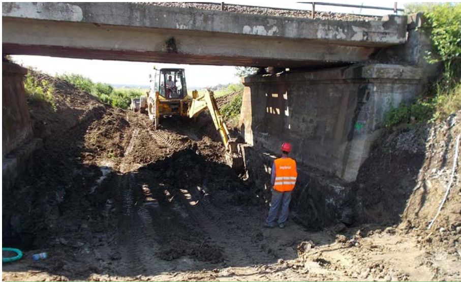
Săpătură realizare radier comun
