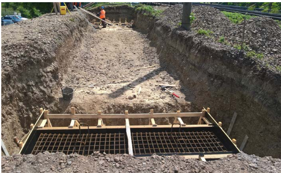
Fundații pod provizoriu pe linia 304J
