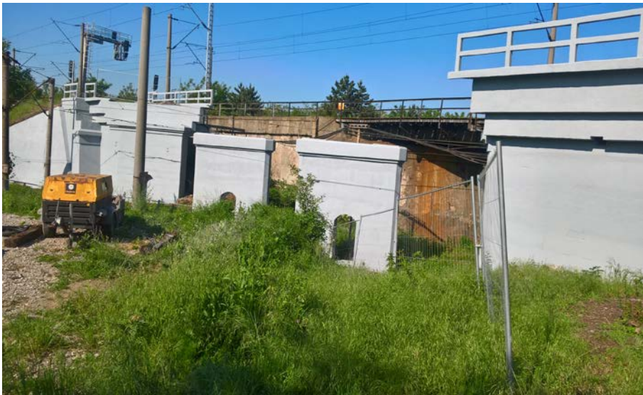
Reparații și protecție beton infrastructuri
