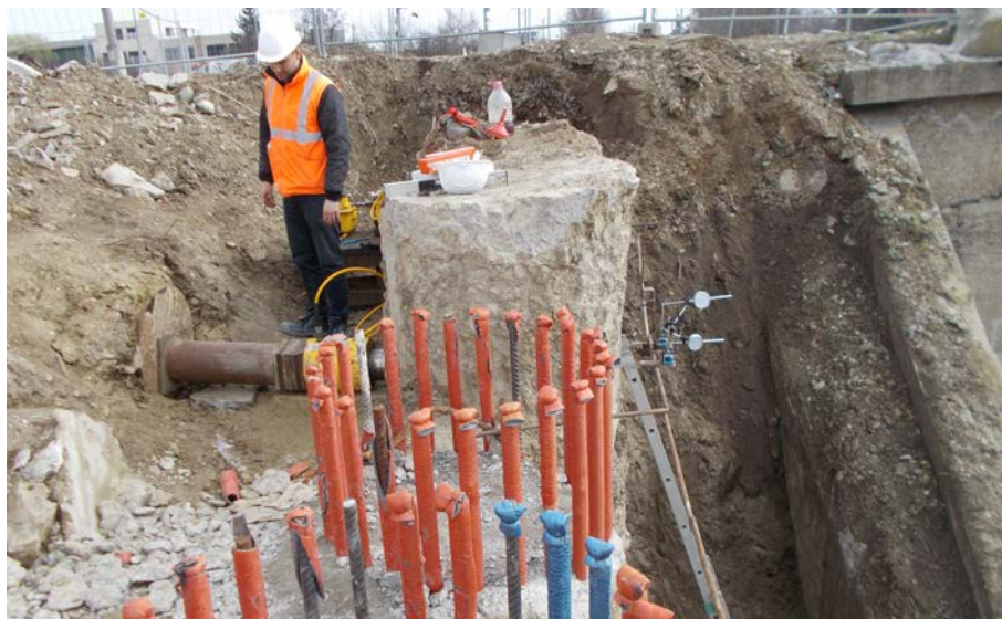
Teste piloți forăți - forțe orizontale
