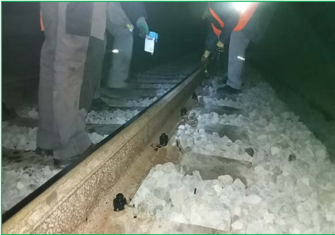
Ungerea materialului mărunț, interior Tunel Balnaca
