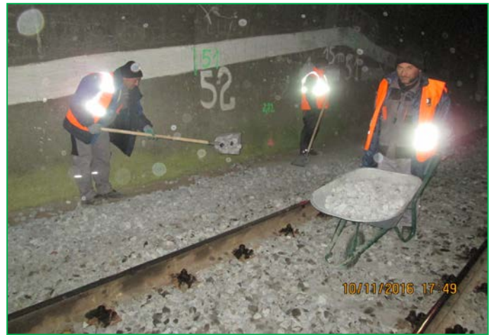
Profilare manuala a prismeii de piatra sparta Tunel Balnaca
