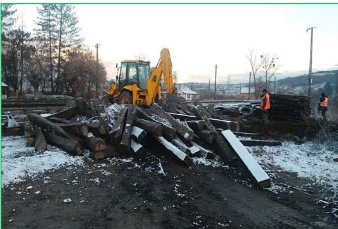
Depozitare si stivuire traverse de lemn, statia Suncuius
