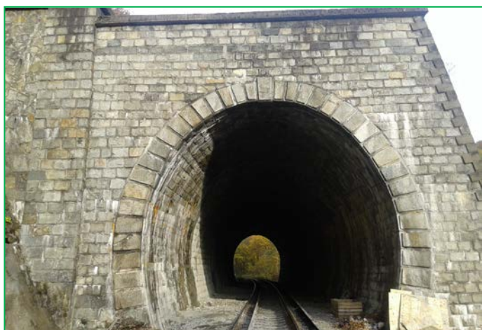
Vedere cap Y, Tunel Stanca
