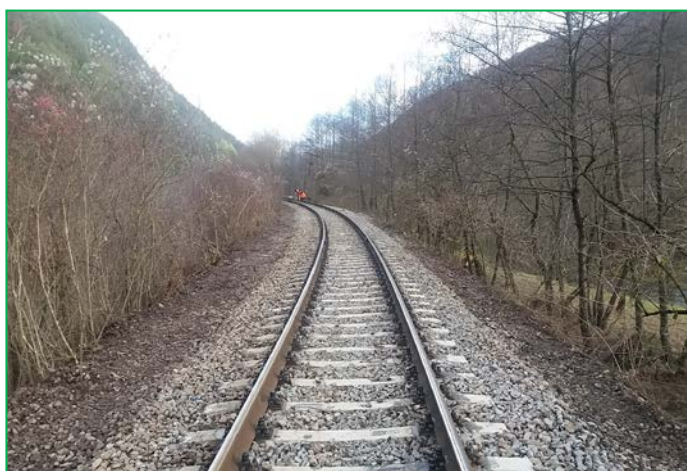
Aplanarea banchetei, cap x Tunel Balnaca
