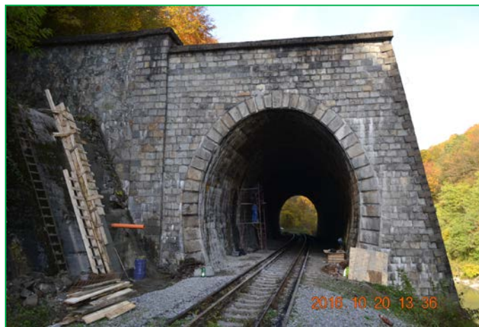
Execuție casii și betonare rosturi dintre inele
