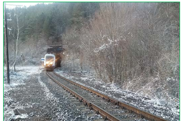
Vedere cap X, Tunel Balnaca
