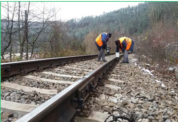
Ungerea materialului marunt, Tunel Balnaca, cap x
