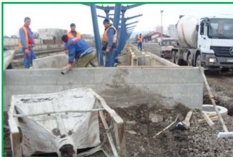
Cofrare grinzi fundare dale prefabricate
