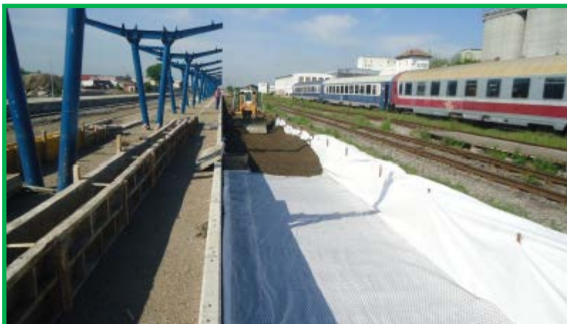
Așternere geotextil și geogrid Linie 5
