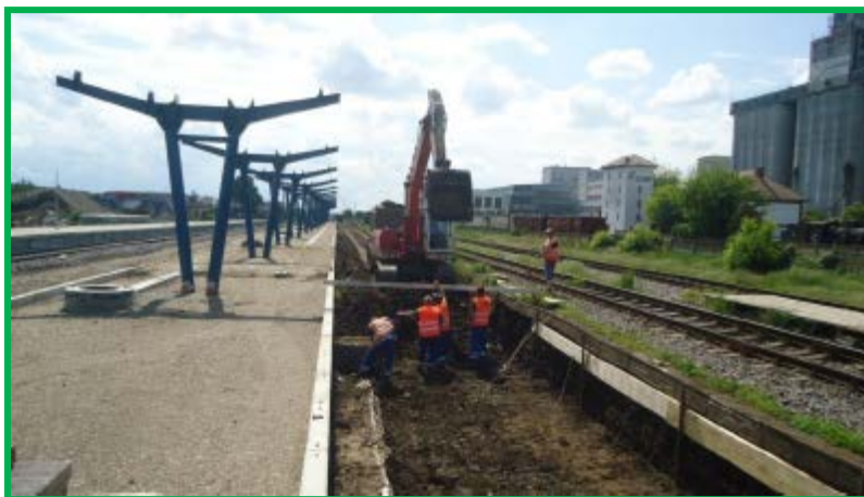
Săpătură linia 5 și realizare îmbunătățire teren de fundare
