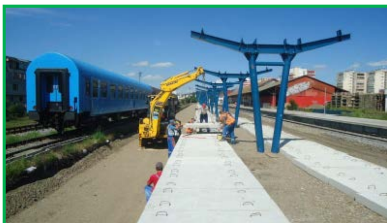
Montare dale prefabricate la peronul intermediar intre liniile 3 si 5
