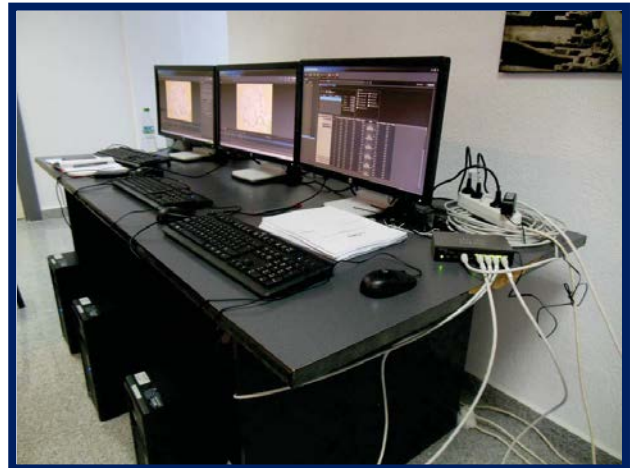
DCOS Post Central CMS - Efectuarea testelor la terminarea lucrărilor la CMS aferent DCOS Bărăganu
