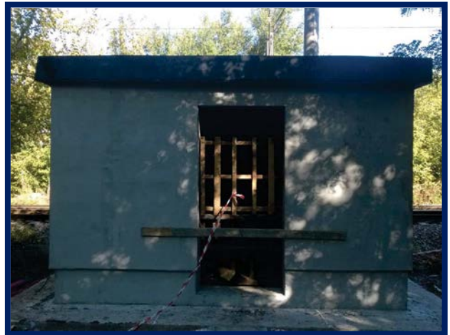
DCOS Cotești – Lucrări construcție clădire container
