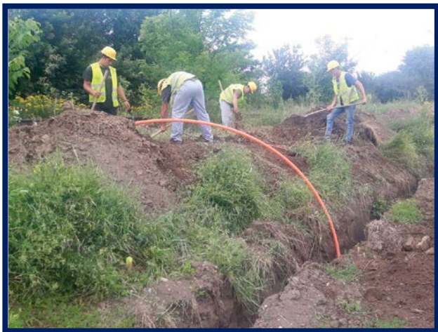
DCOS Sascut – Lucrări săpătură șanț cabluri FO și EA
