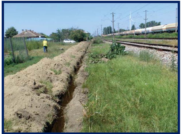
DCOS Movila – Lucrări săpătură șanț cabluri FO și EA
