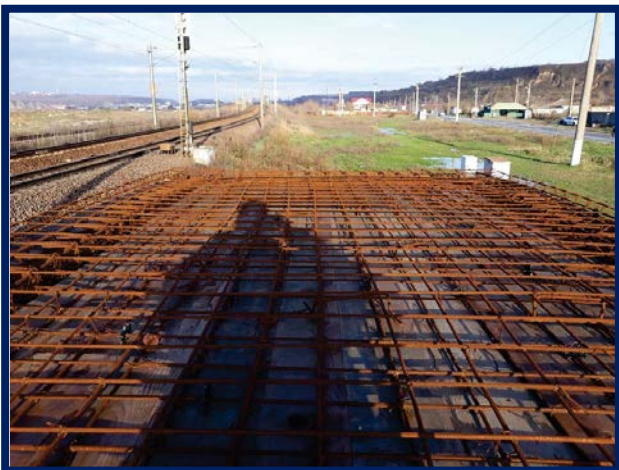
DCOS Saligny – Lucrări placa superioară clădire container
