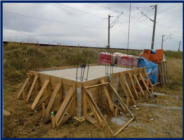
DCOS Măldăeni – Lucrări fundație clădire container
