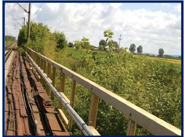
DCOS Săcuieni Roman - Lucrări pozare cabluri FO și EA
