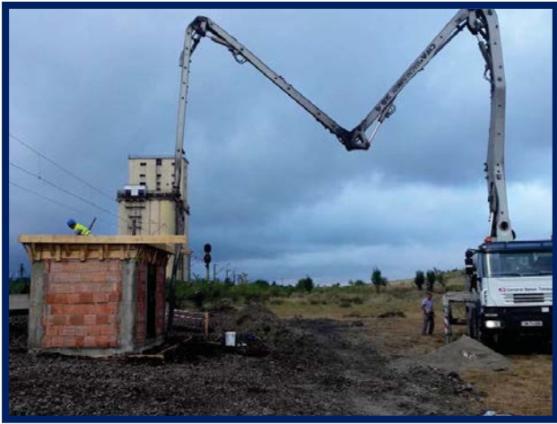
DCOS Vinga - Lucrări finisaje clădire container
