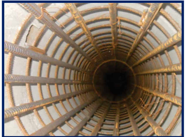
Execuție piloți forajați pentru fundație clădire container DCOS Brănești
