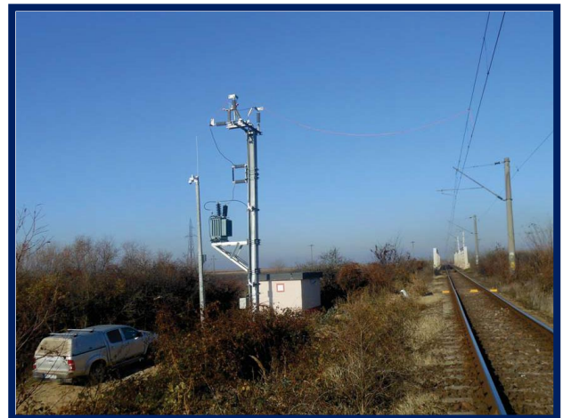
Teste la terminarea lucrărilor și verificări în vederea punerii în funcțiune DCOS Jabăr
