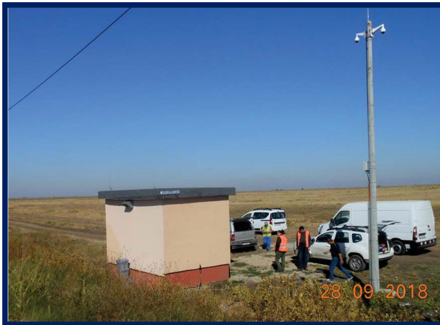
Teste la terminarea lucrărilor și verificări în vederea punerii în funcțiune DCOS Măldăeni
