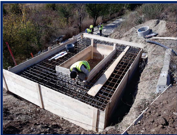
Execuție fundație clădire container DCOS Brănești
