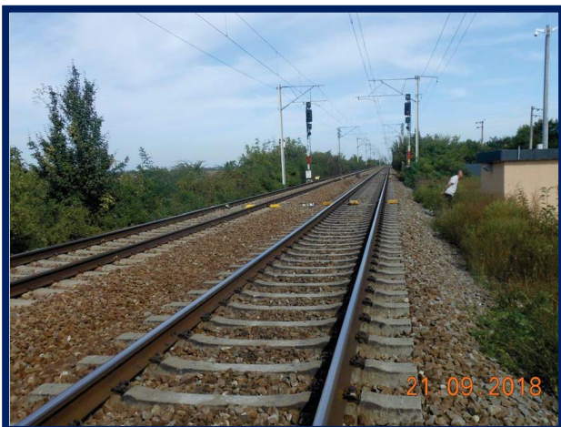
Echipe DCOS de cale și clădire container – Crivina
