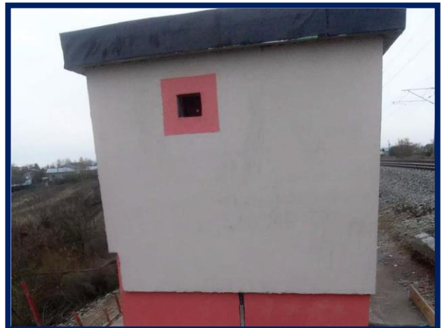
Finisaje exterioare clădire container – DCOS Brănești
