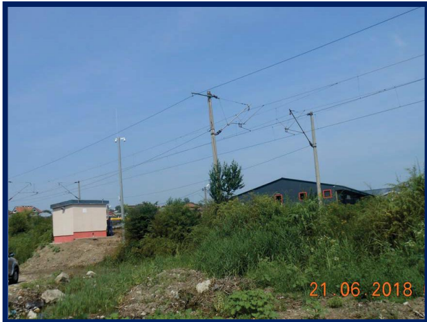
Teste la terminarea lucrărilor și verificări în vederea punerii în funcțiune DCOS Târgu Frumos
