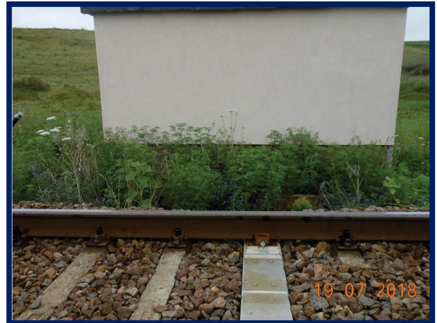
Finisaje exterioare clădire container și traversă specială senzori DCOS montată în cale aferent DCOS Vinga
