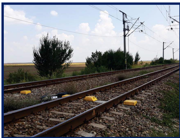
Teste la terminarea lucrărilor și verificări în vederea punerii în funcțiune DCOS Grozăvești
