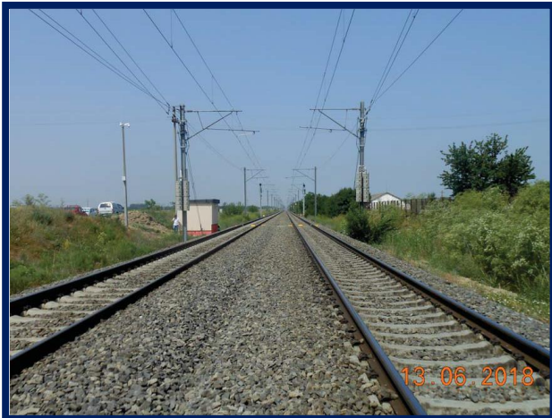
Teste la terminarea lucrărilor și verificări în vederea punerii în funcțiune DCOS Dragoș Vodă
