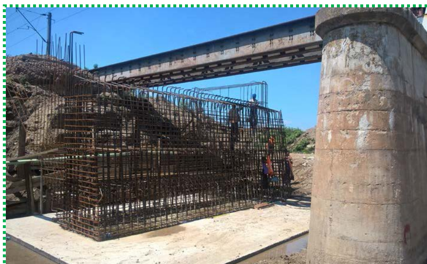
Armare elevație - culee Videle
