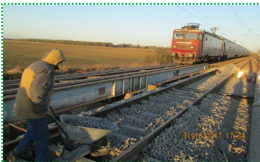
Montare suprastructură CF Fir II
