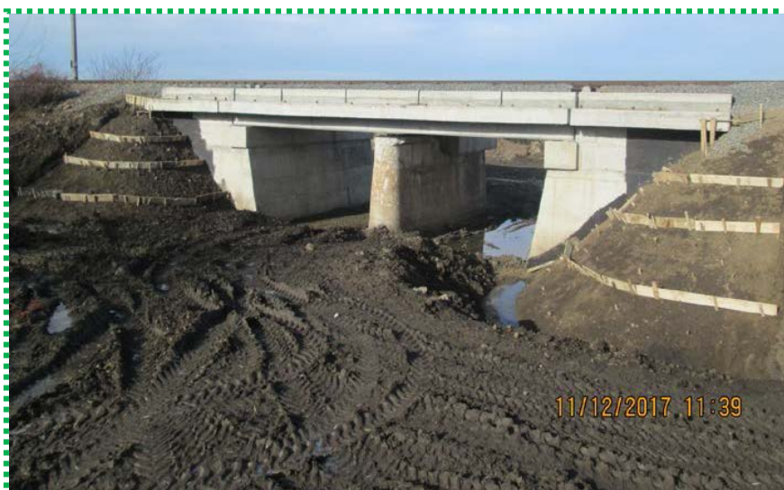
Umpluturi sferturi de con Fir II
