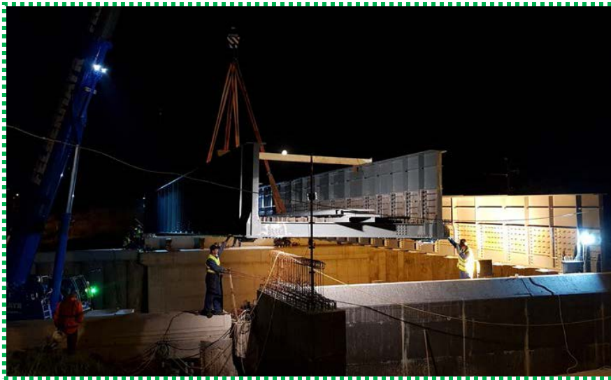
Montare tablier metalic - Tronson II
