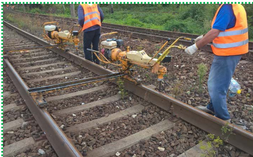
Desfacere tirfoane - scoatere suprastructură CF
