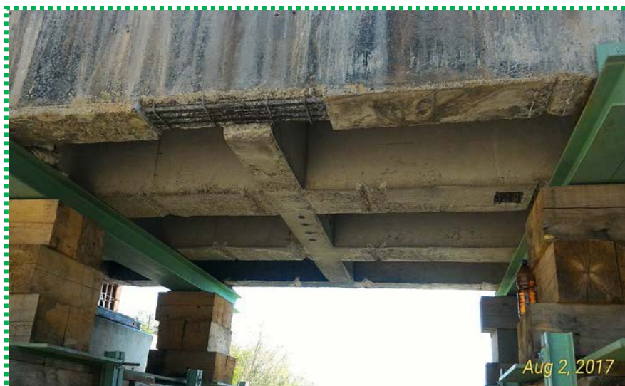
Reparații tablier existent la intrados
