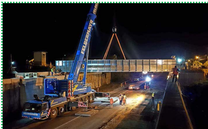
Montare tablier metalic - Tronson I
