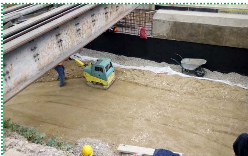
Compactare umplutură - în spate culee Videle
