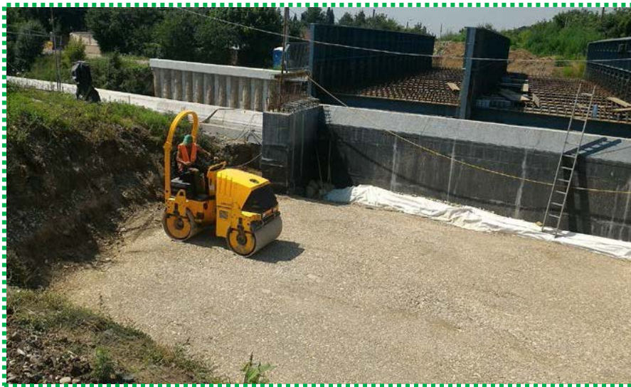
Compactare umplutură pământ armat - spate culee Mogoșoaia
