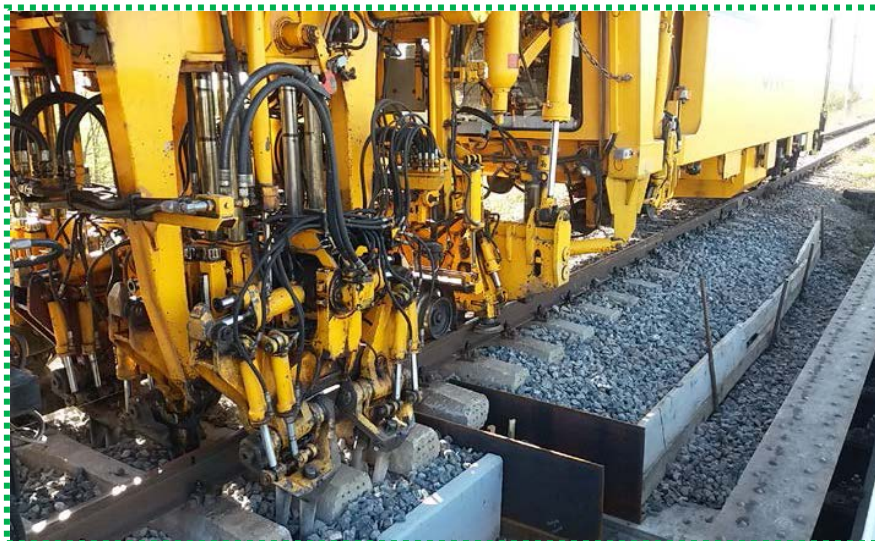
Buraj mecanizat prism piatră spartă
