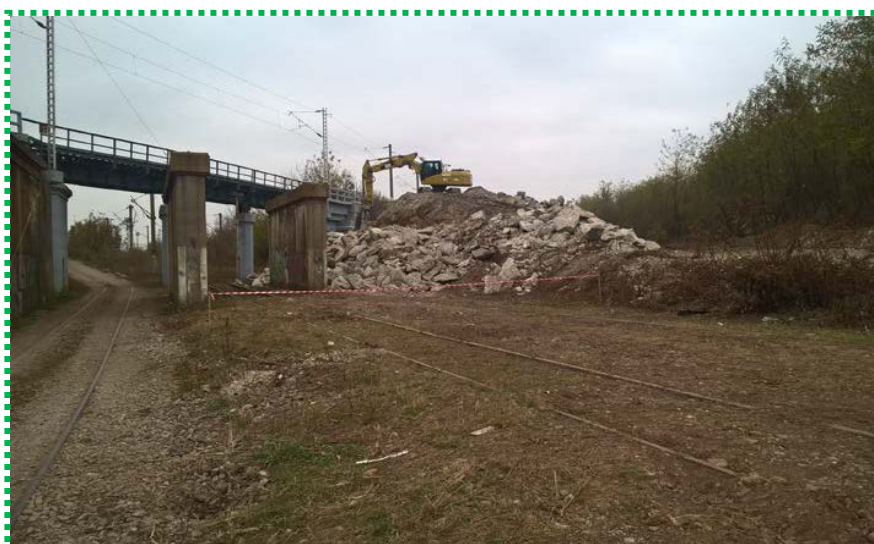
Demolare infrastructuri existente - culee București
