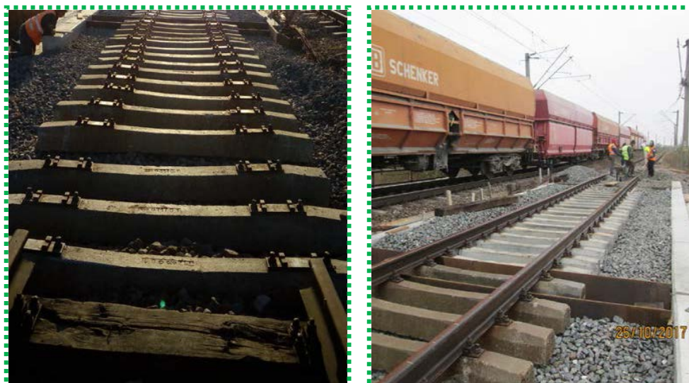
Montare traverse / Profilare prism piatră spartă
