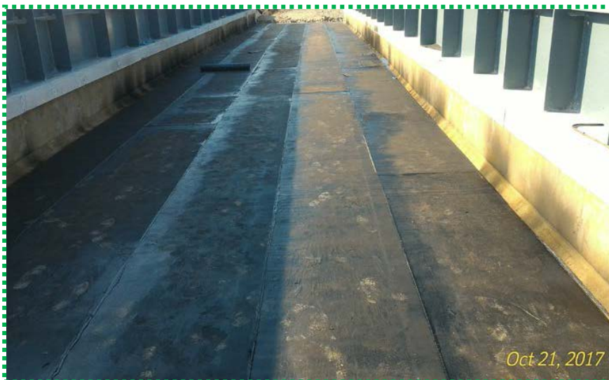
Așternere membrană hidroizolație tablier - dala
