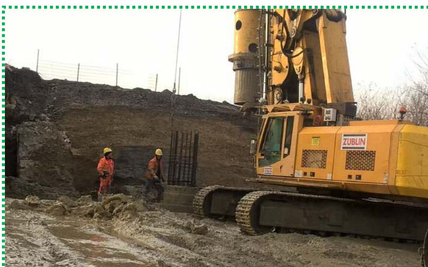
Forare coloane fundație culee
